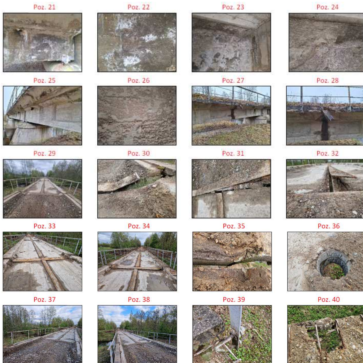
3 pav. tęsinys. Tilto defektai
