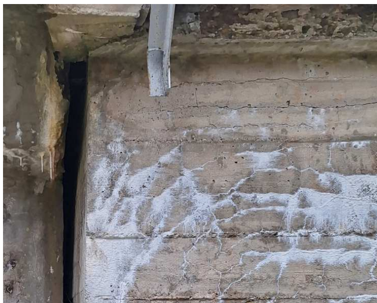
13 pav. Plyšiai taurų sparnų konstrukcijose
