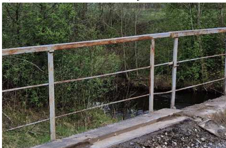
17 pav. Turėklų paviršinė korozija
