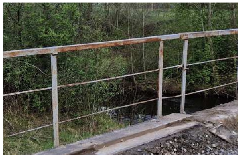
2.15 pav. Turėklų paviršinė korozija
