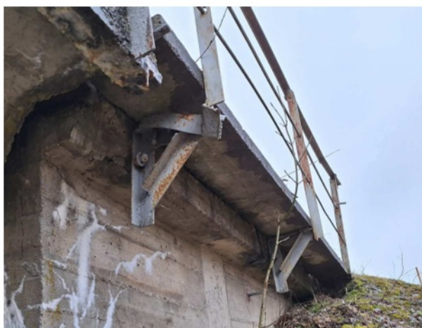
2.13 pav. Šaltilčio konsolių paviršinė korozija, nepilnai užsuktos veržlės
