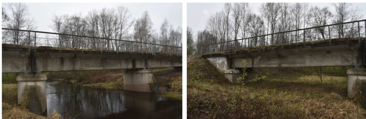
2.12 pav. Patiltės šlaitų būklė gera
