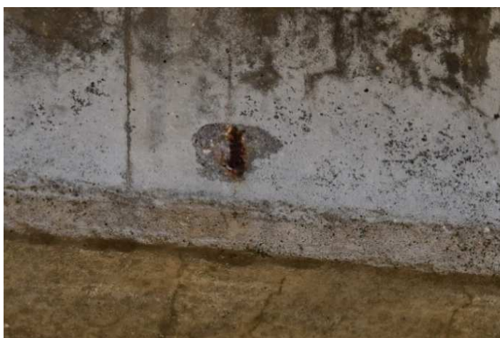
5 pav. Koroduojanti armatūra
