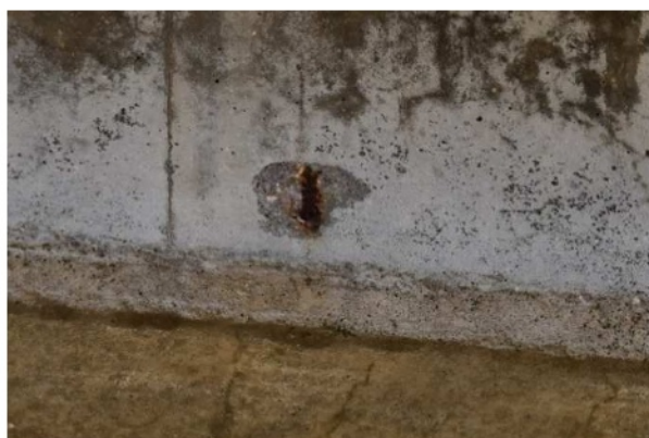
2.3 pav. Koroduojanti armatūra
