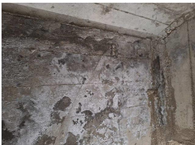
8 pav. Įstriži plyšiai perdangos sijose
