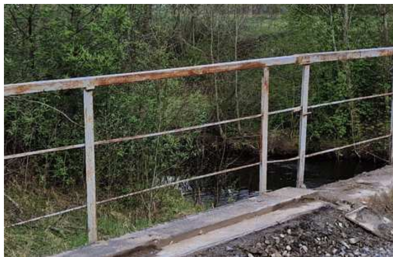
17 pav. Turėklų paviršinė korozija
