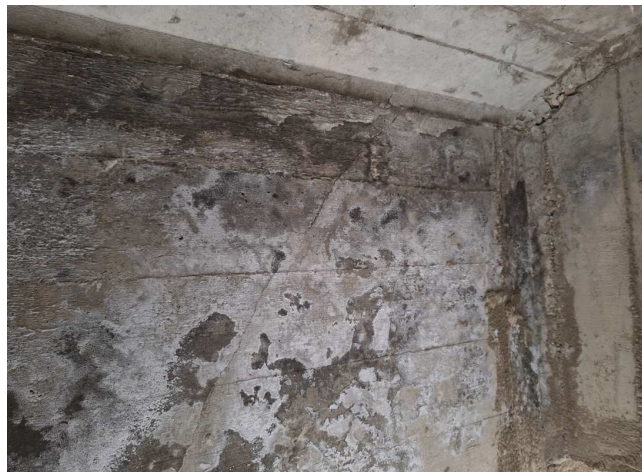
8 pav. Įstriži plyšiai perdangos sijose
