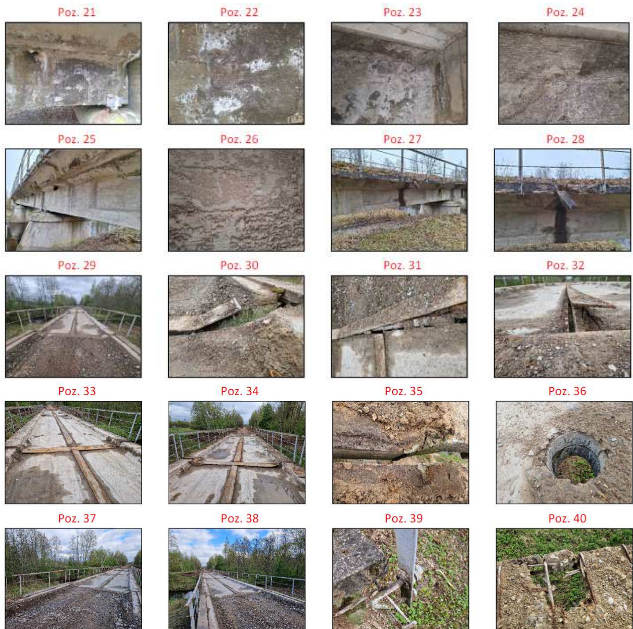
3 pav. tęsinys. Tilto defektai
