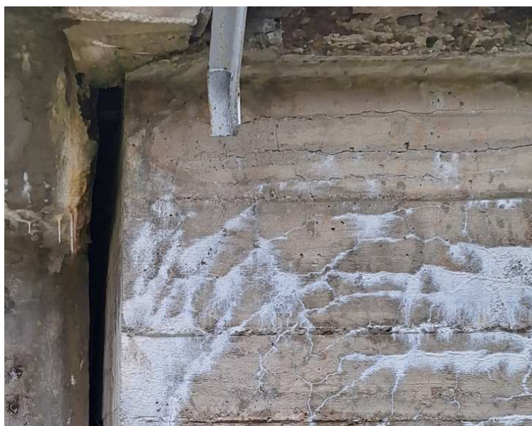
13 pav. Plyšiai taurų sparnų konstrukcijose
