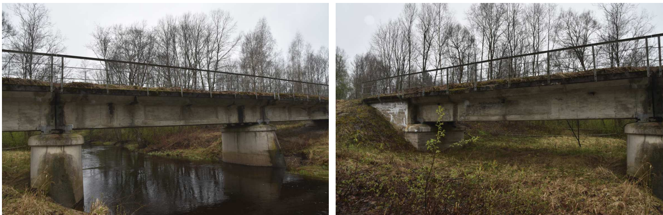
14 pav. Patiltės šlaitų būklė gera
