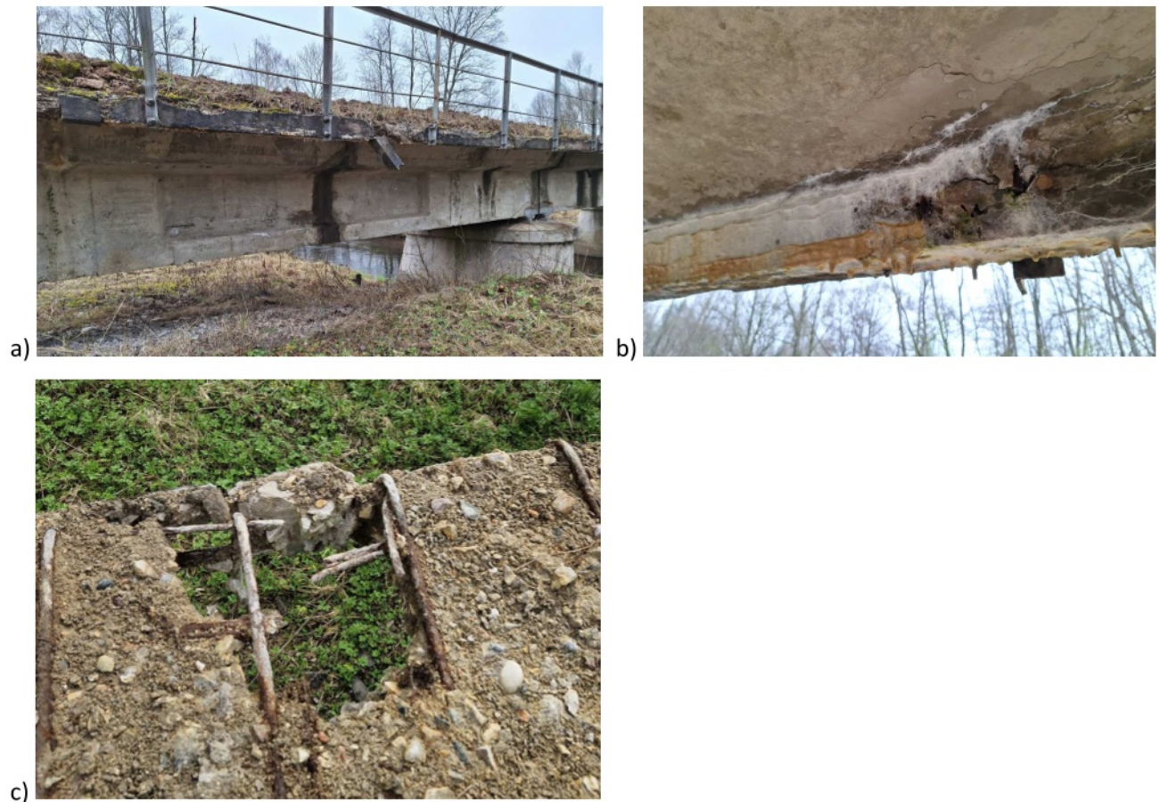
2.14 pav. Šaitilčio paviršių pažeidimai: a) nuskilinėję, išlūžę, ištrupėję šaitilčių paviršiai; b) šaitilčių apačioje atšokęs apsauginis betono sluoksnis, matoma korduojanti armatūra; c) einamosios dalies paviršiuje ištrupėjęs betonas, matoma korduojanti armatūra;
