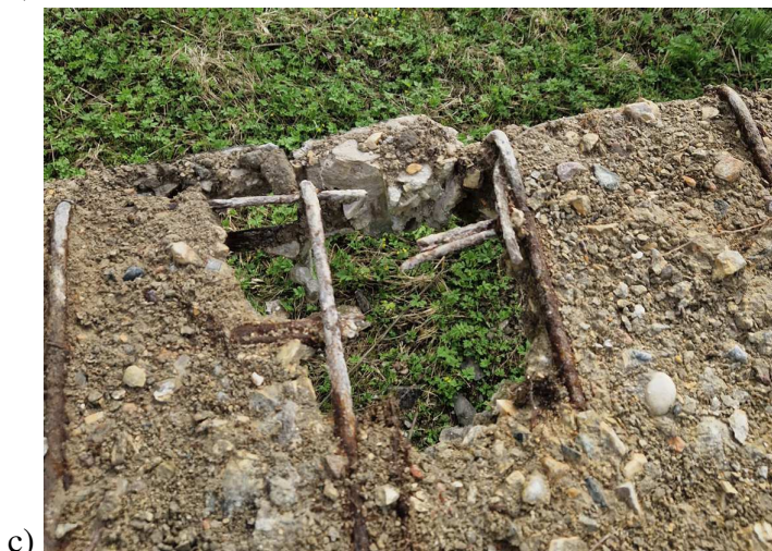
16 pav. Šaltilčio paviršių pažaidos: a) nuskilinėję, išlūžę, ištrupėję šaltilčių paviršiai; b) šaltilčių apačioje atšokęs apsauginis betono sluoksnis, matoma koroduojanti armatūra; c) einamosios dalies paviršiuje ištrupėjęs betonas, matoma koroduojanti armatūra;
