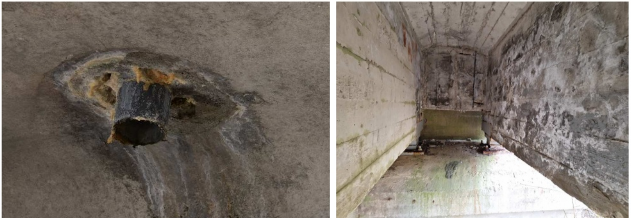
2.5 pav. Išplauti cementinio akmens elementai nusėdę baltų dėmių bei stalaktitų pavidalu
