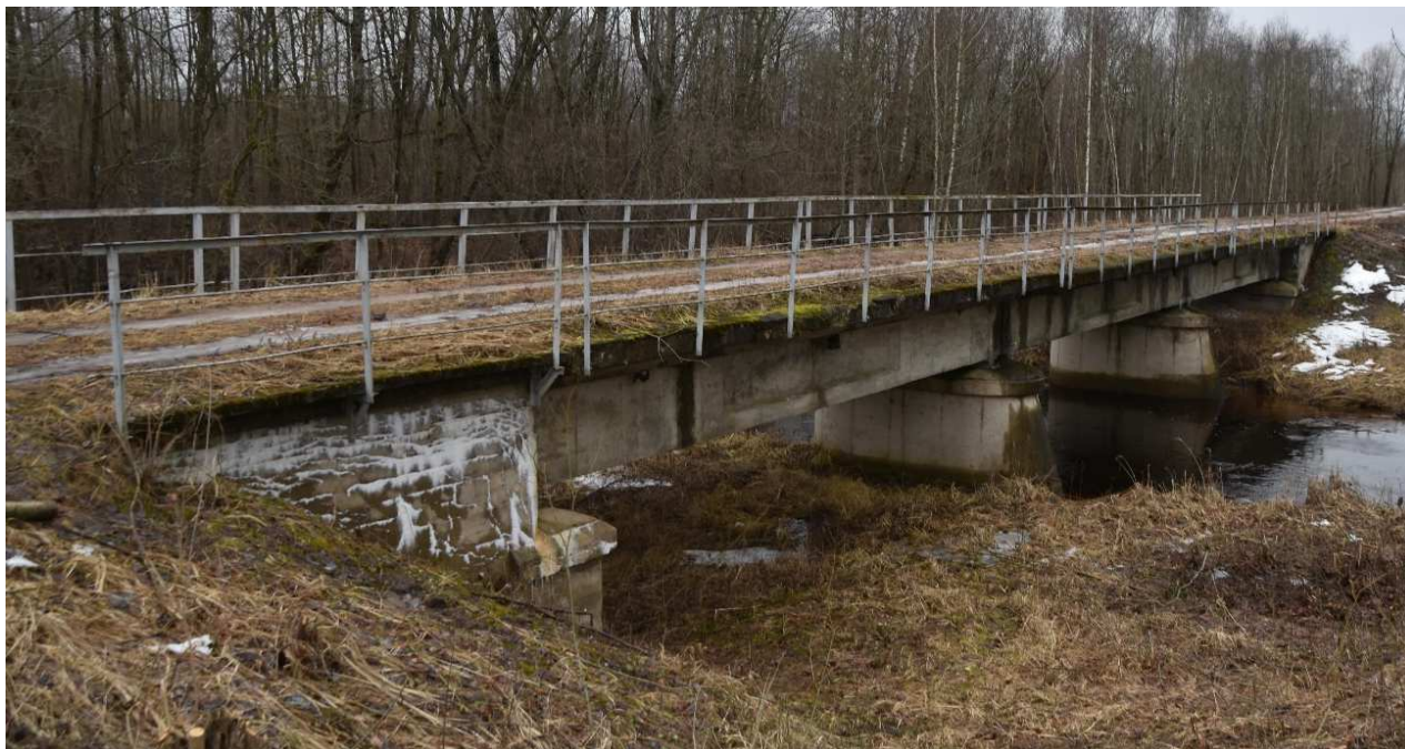
2 pav. Tiltu Panevėžio GS kelio Nr. 42-2-2 6+264 km fasadinis vaizdas
