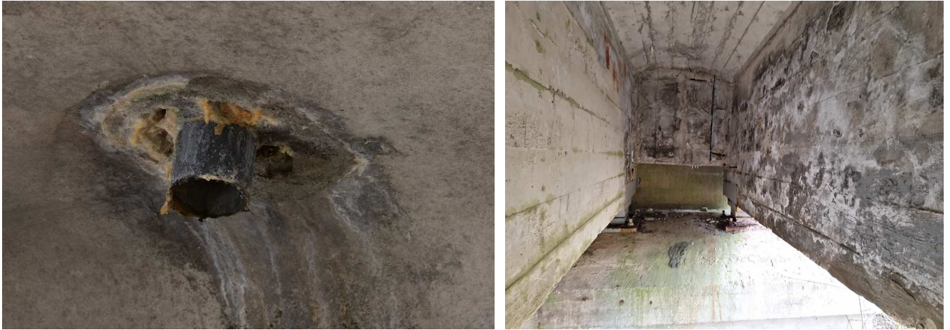
7 pav. Išplauti cementinio akmens elementai nusėdę baltų dėmių bei stalaktitų pavidalu
