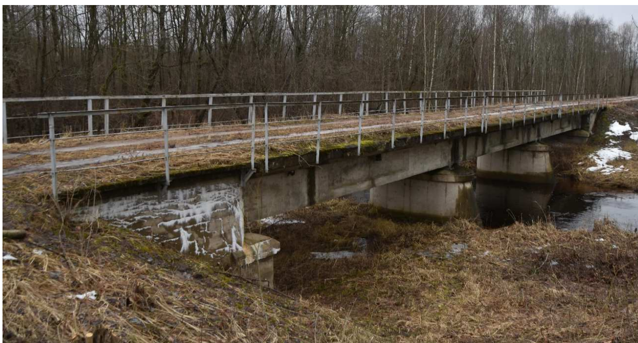
2 pav. Tiltu Panevėžio GS kelio Nr. 42 6+264 km fasadinis vaizdas
