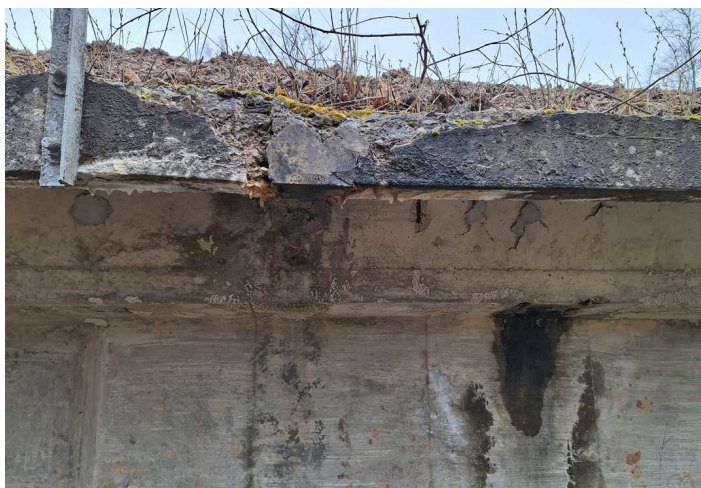
4 pav. Atšokęs apsauginis betono sluoksnis
