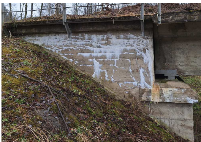
11 pav. Betono paviršiuje matomi išplauti cementinio akmens elementai
