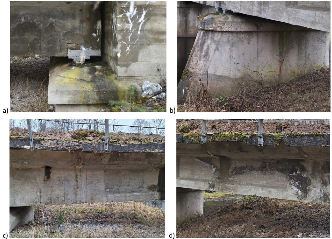
2.18 pav. Betono bandymo vietas: a) bandymo taškas Nr. 1; b) bandymo taškas Nr. 2; c) bandymo taškas Nr. 3; d) bandymo taškas Nr. 4
