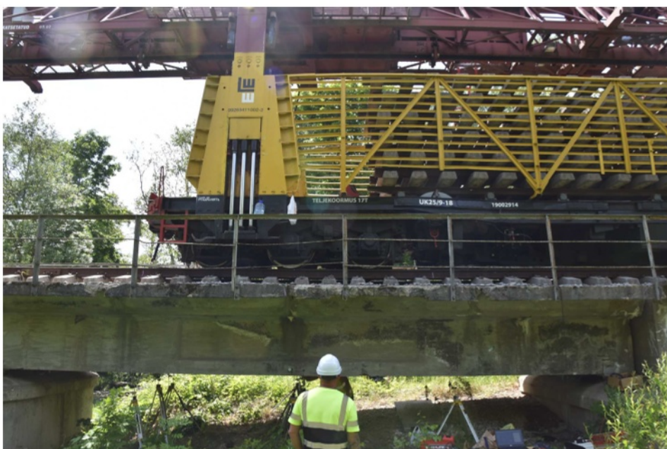
1.4 pav. Statiųjų bandymų eiga: Kelio klotuvus II padėtyje
