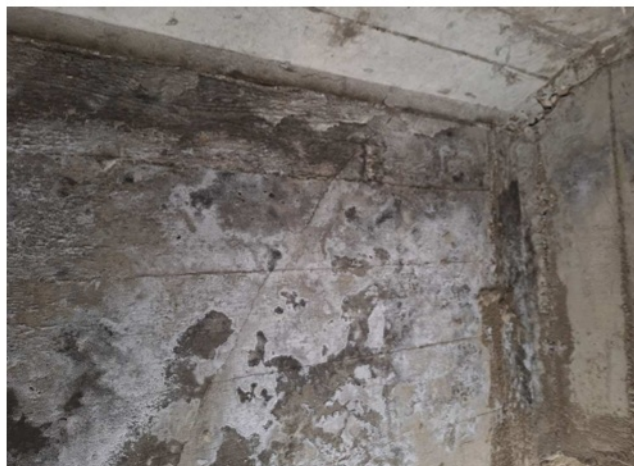
2.6 pav. Įstriži plyšiai perdangos sijose
