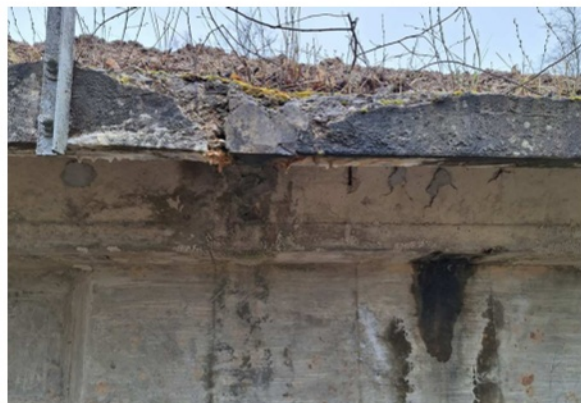
2.2 pav. Atšokęs apsauginis betono sluoksnis
