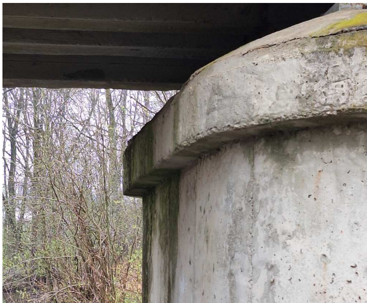
12 pav. Nuolat drėkinami taurų paviršiai ir vandens pratakos, apkerpėjęs betono paviršius
