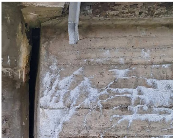
2.11 pav. Plyšiai taurų sparnų konstrukcijose
