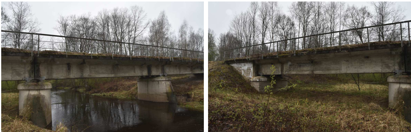
14 pav. Patiltės šlaitų būklė gera
