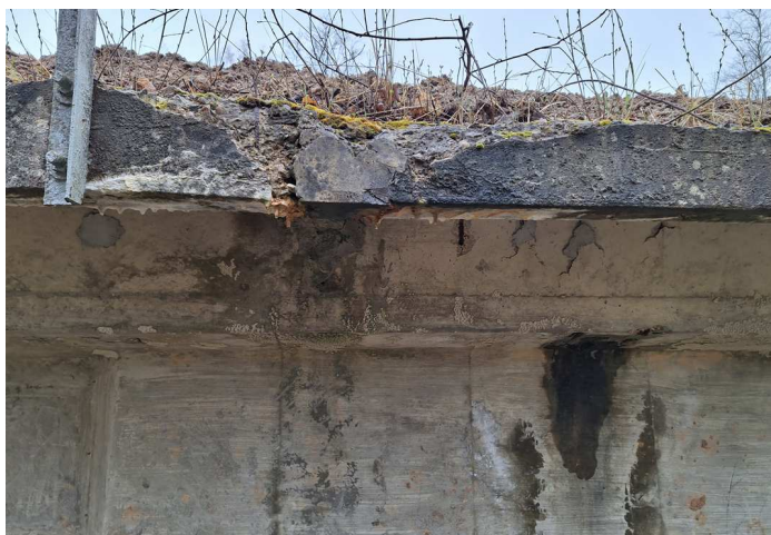
4 pav. Atšokęs apsauginis betono sluoksnis
