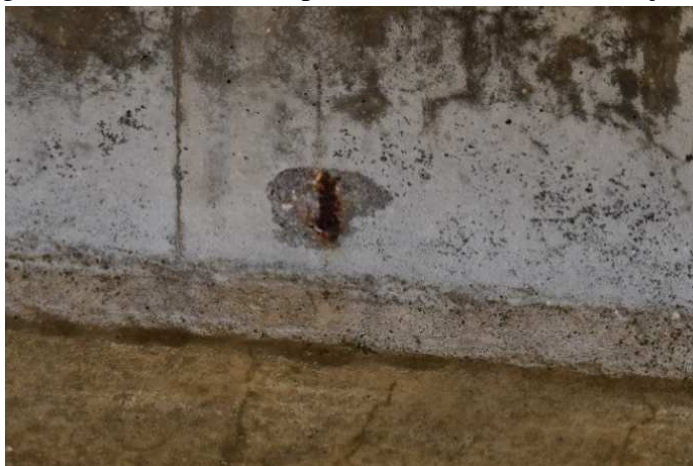
5 pav. Koroduojanti armatūra
