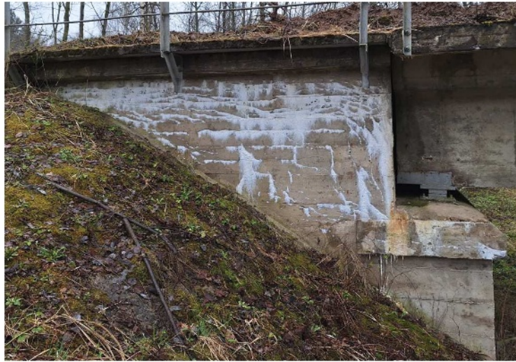
2.9 pav. Betono paviršiuje matomi išplauti cementinio akmens elementai
