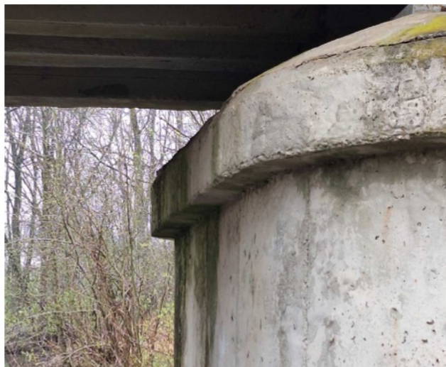
2.10 pav. Nuolat drėkinami taurų paviršiai ir vandens pratakos, apkerpėjęs betono paviršius
