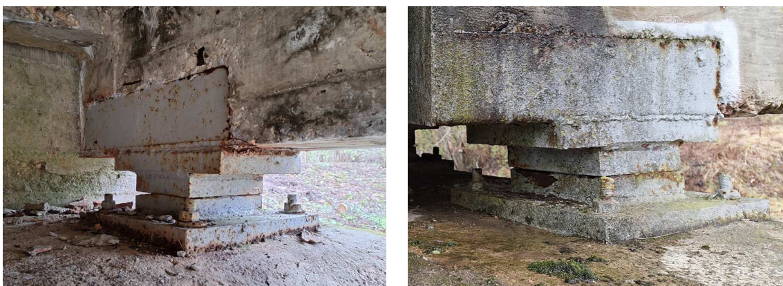
10 pav. Nuo atraminių guolių paviršių atšokusi apsauginė danga, pastebėti korozijos židiniai
