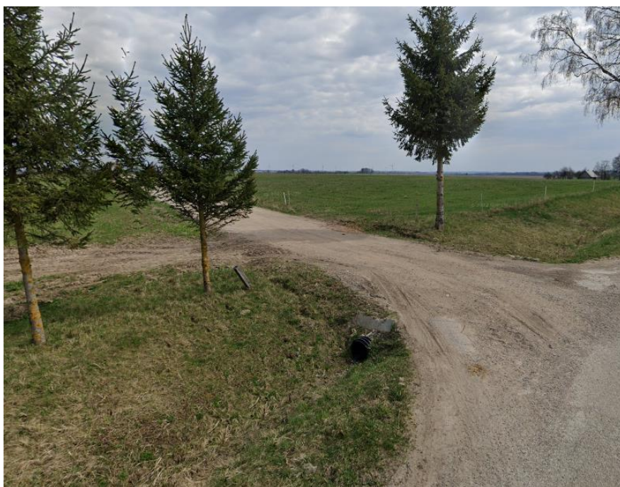
3 pav. Kelio nuovaža PK 95+40
