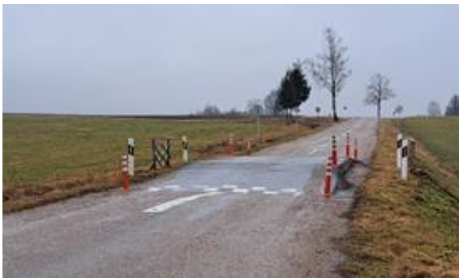
3 pav. Esama kelio ruožo būklė
