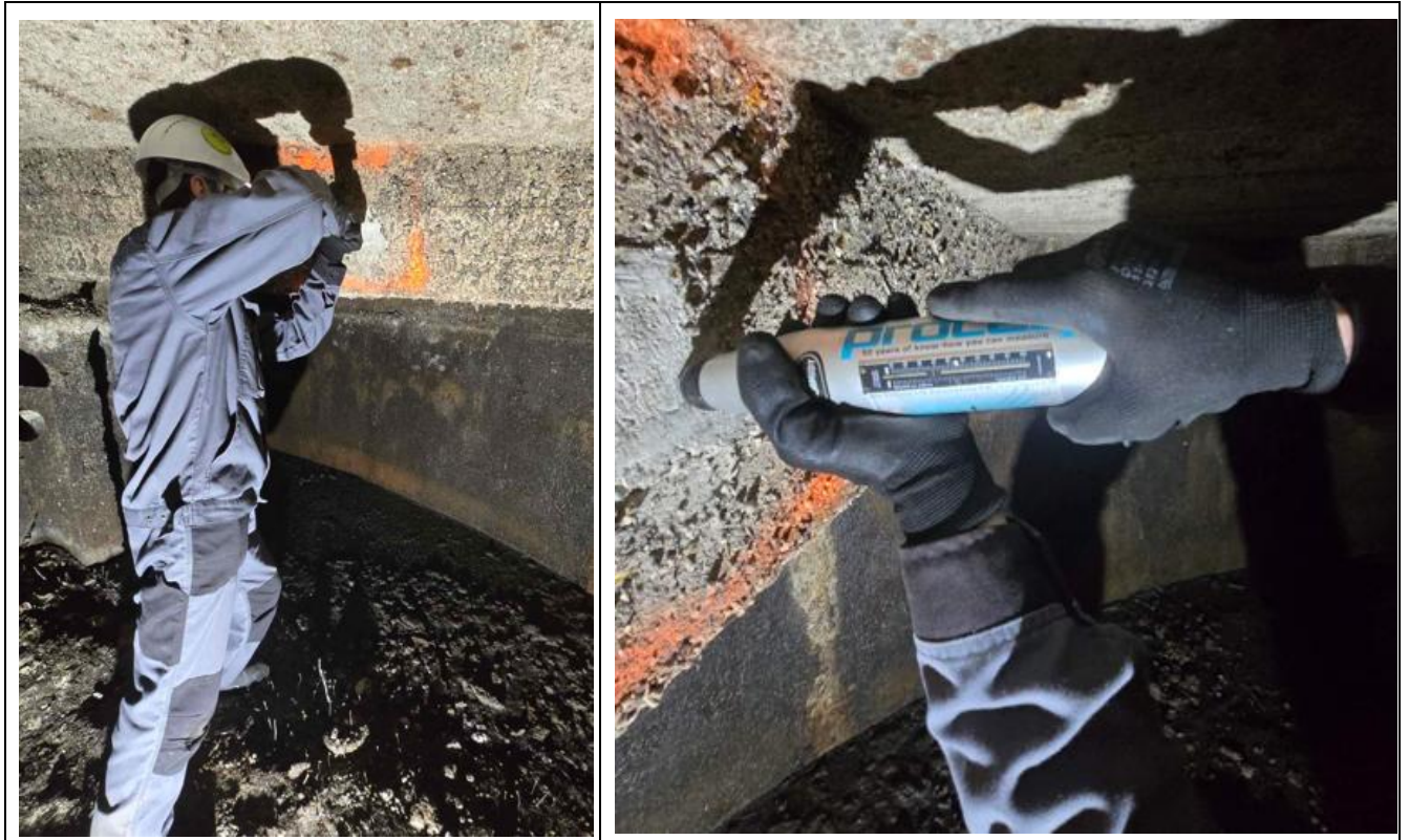
Pav. 6.5 betono stiprio testas Šmidto plaktuku
