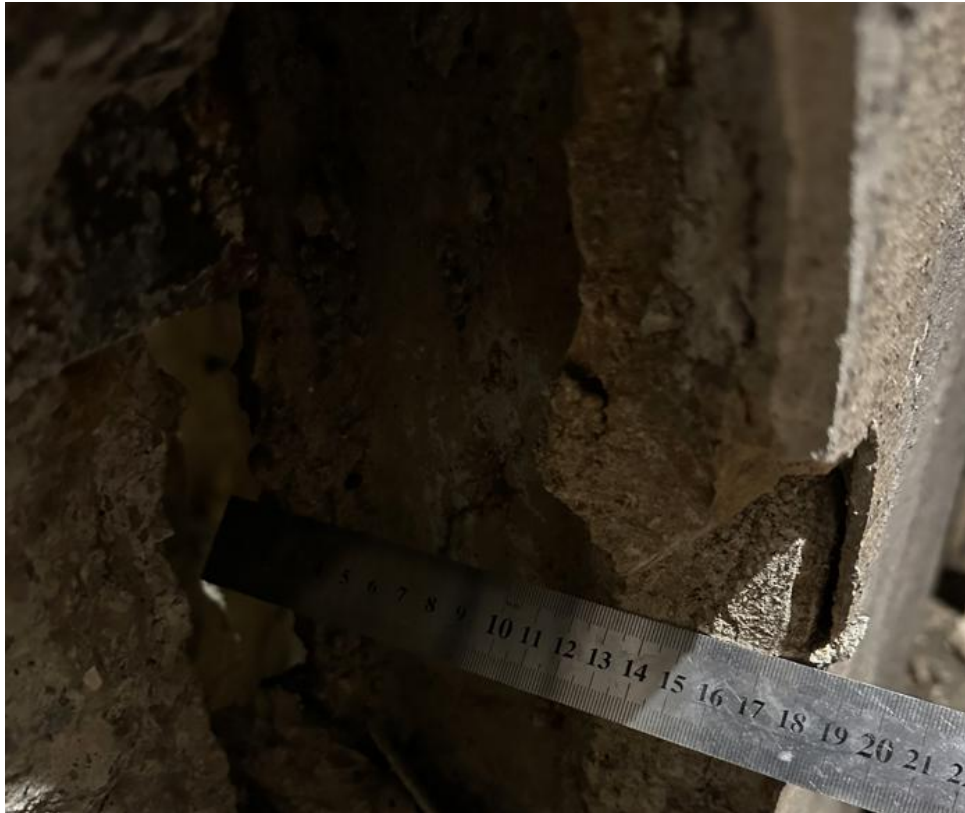
Pav. 7.18 Pertvaros plokščių prasislinkimas
