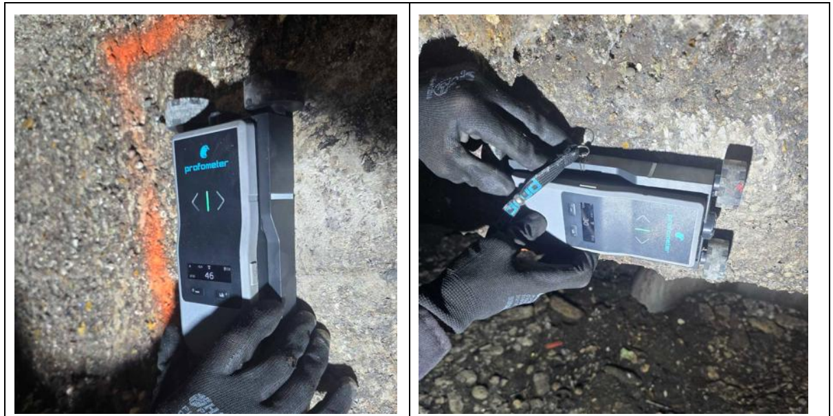
Pav. 6.10 armatūros ir jos apsauginio betono sluoksnio storio nustatymas
