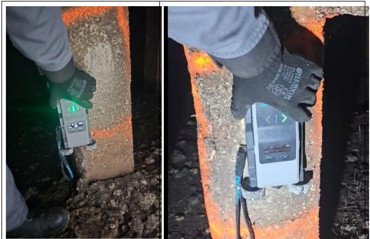
Pav. 6.8 armatūros ir jos apsauginio betono sluoksnio storio nustatymas
