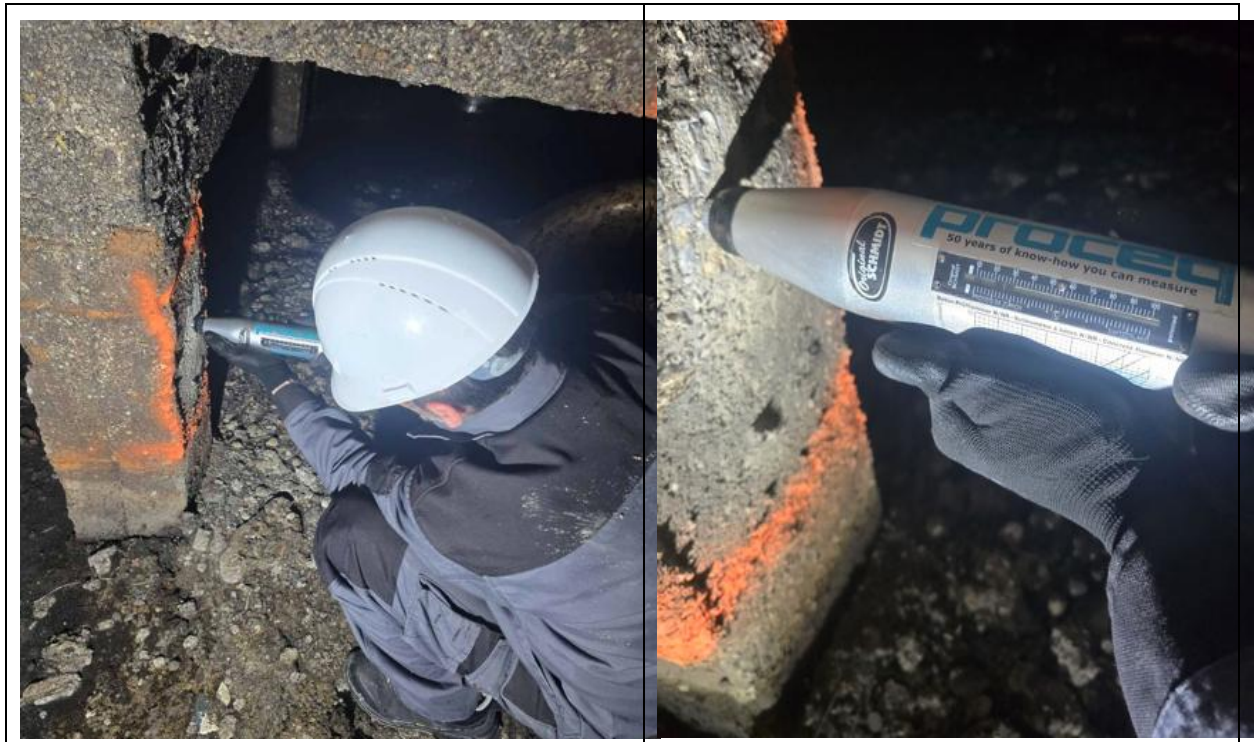
Pav. 6.7 betono stiprio testas Šmidto plaktuku
