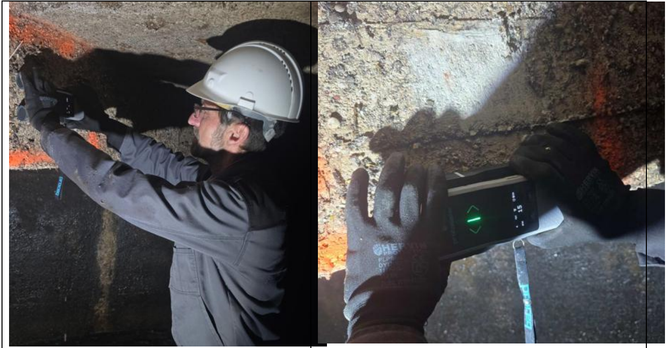
Pav. 6.6 armatūros ir jos apsauginio betono sluoksnio storio nustatymas
