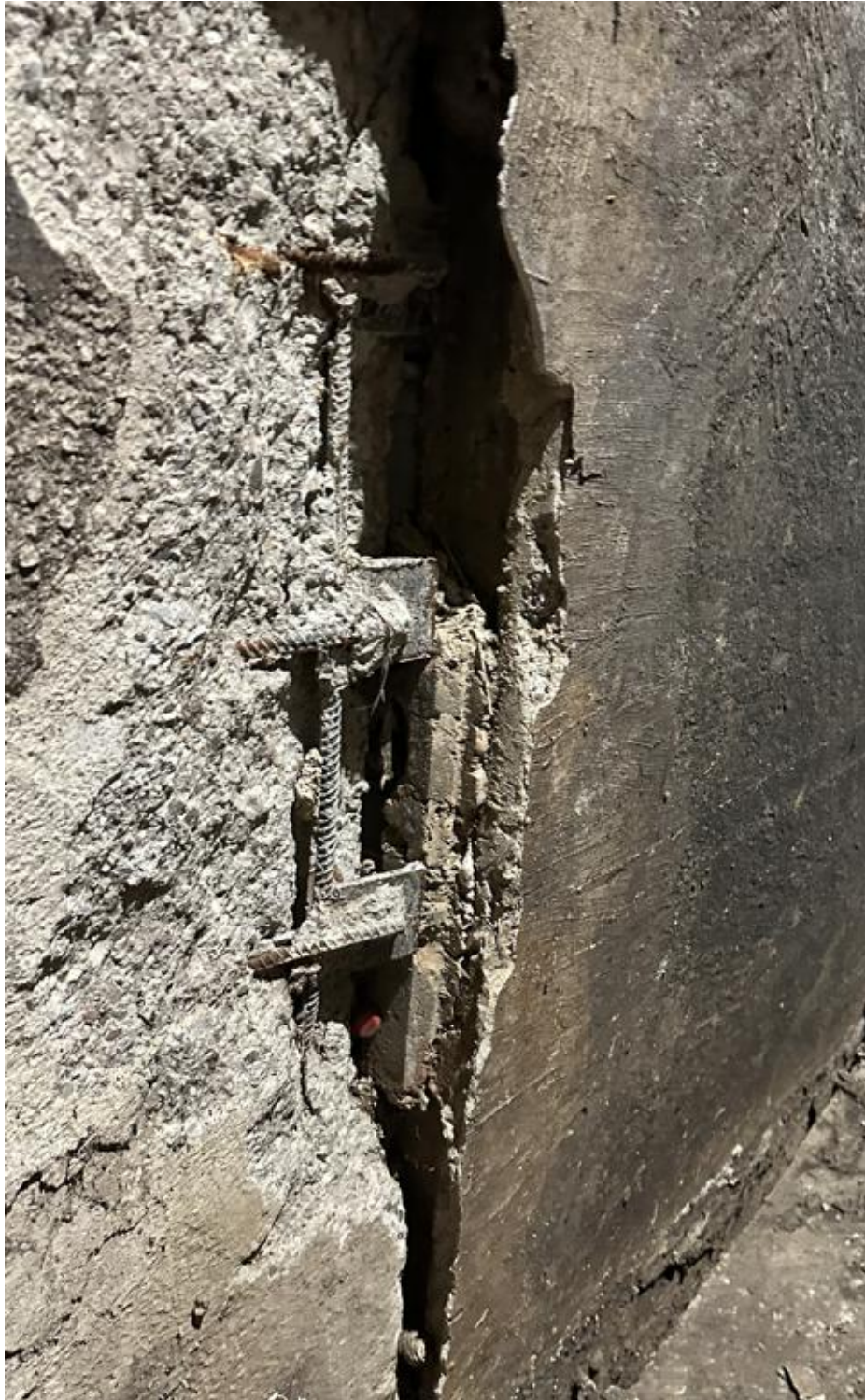
Pav. 7.15 Jungties/spynos atitrūkimas, vaizdas iš „šlapiosios“ dalies pusės
