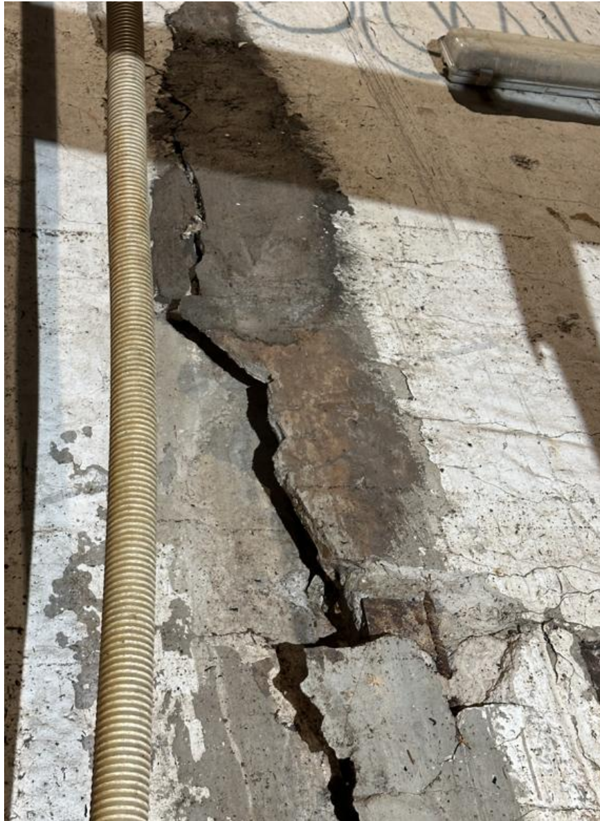
Pav. 7.16 Jungties/spynos atitrūkimas. Vaizdas iš „sausosios“ dalies pusės
