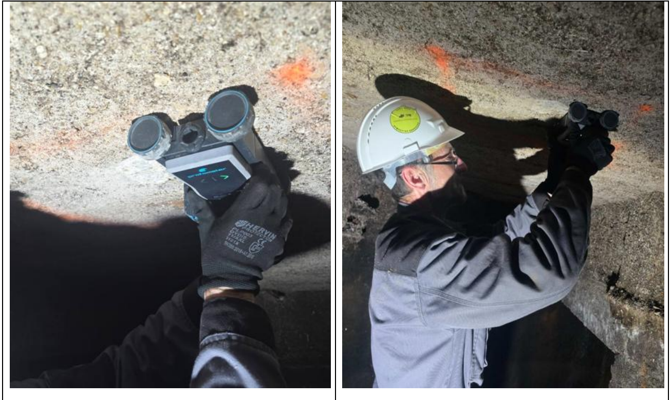
Pav. 6.4 armatūros ir jos apsauginio betono sluoksnio storio nustatymas
