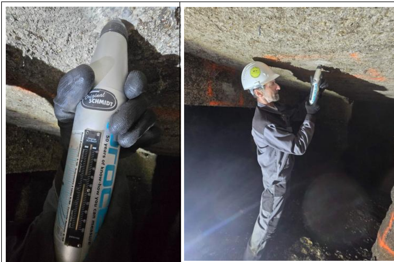
Pav. 6.3 betono stiprio testas Šmidto plaktuku
