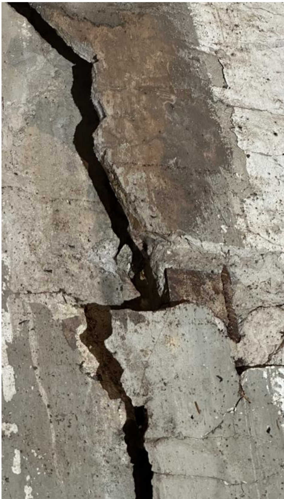
Pav.7.21 Pertvaros plokščių lūžiai
