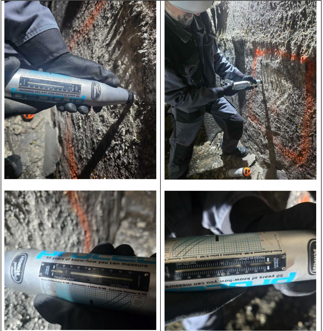
Pav. 6.1 betono stiprio testas Šmidto plaktuku
