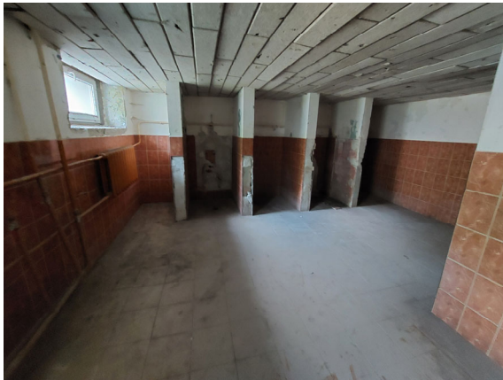
2 pav. Rūšio patalpa R-3
