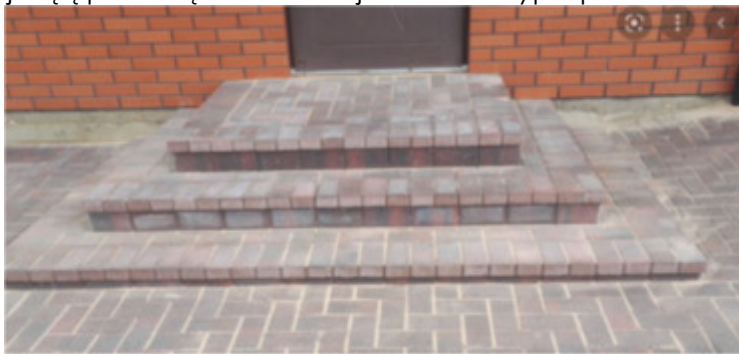
4 pav. pzv.laiptų įrengimui
