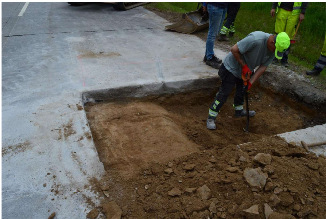
Plyšiai formuojasi ten, kur betono plokštė remiasi į skirtingo stiprio pagrindo sluoksnį.
