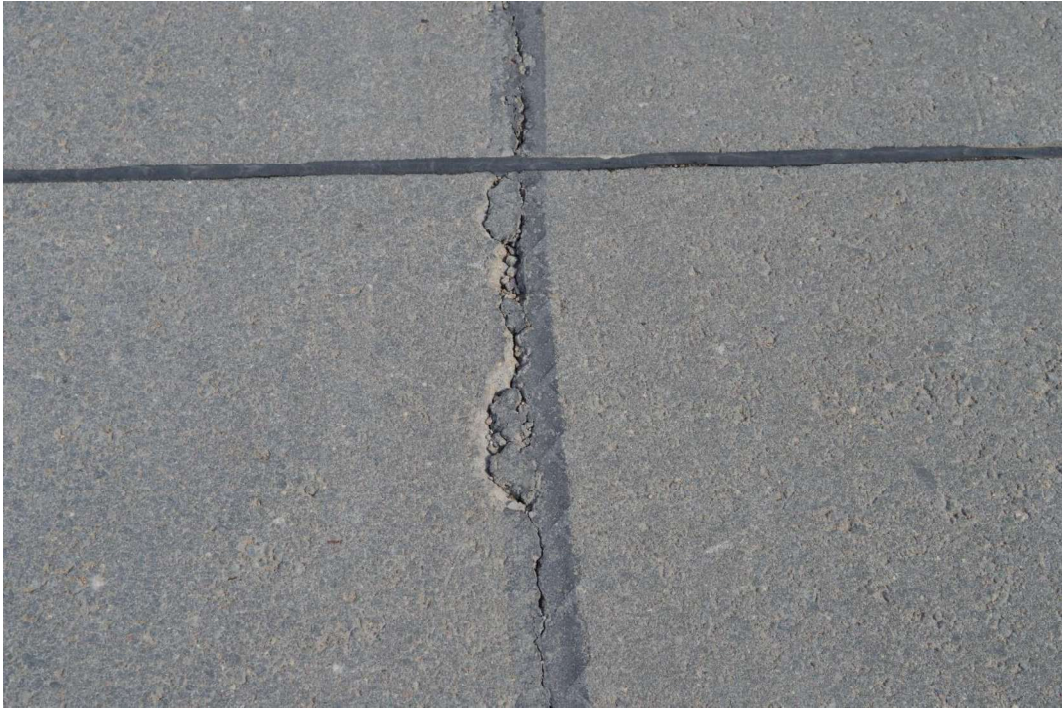
Trūkusi remontuota siūlė. Toliau vyksta pagrindo deformacijos.
