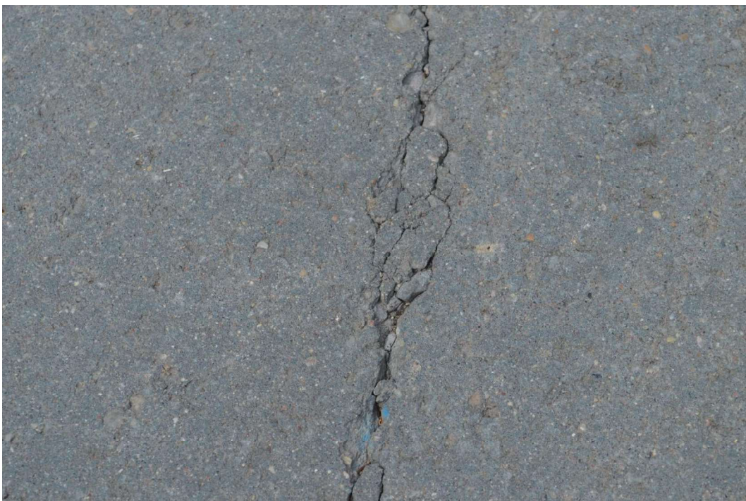
Betono irimas plyšio zonoje.
