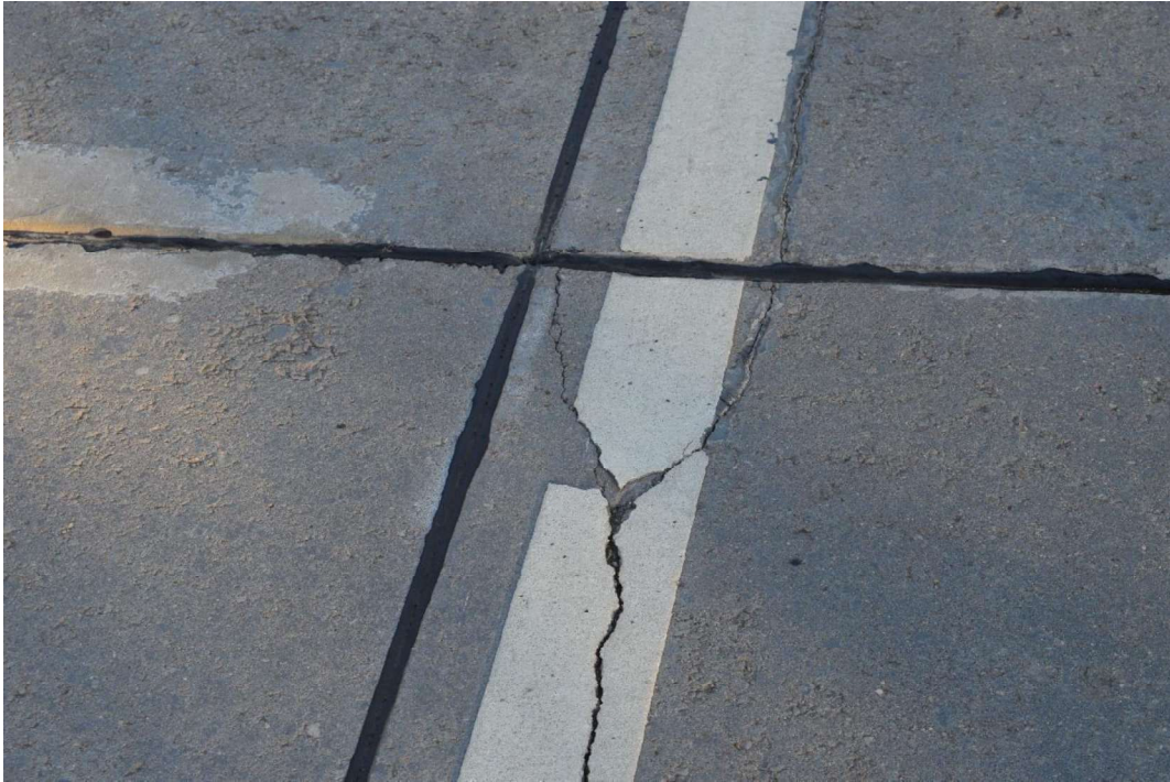
Formuojasi plyšių tinklas betono plokštėje.
