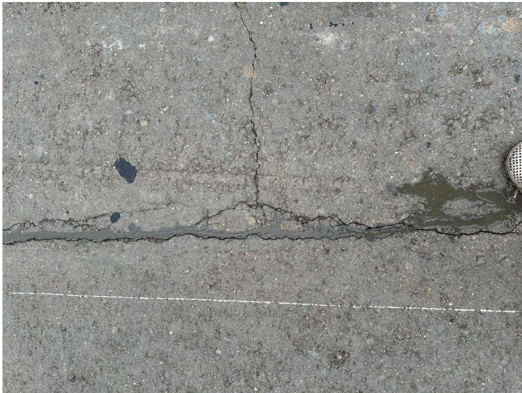
Remontuotų zonų pleišėjimas, betono irimas plyšių zonose.
