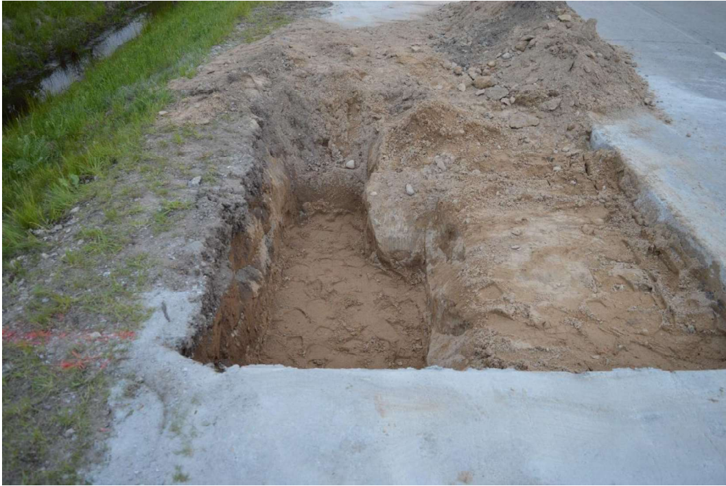
Skirtingų stiprių stabilizuotas pagrindo sluoksnis.
