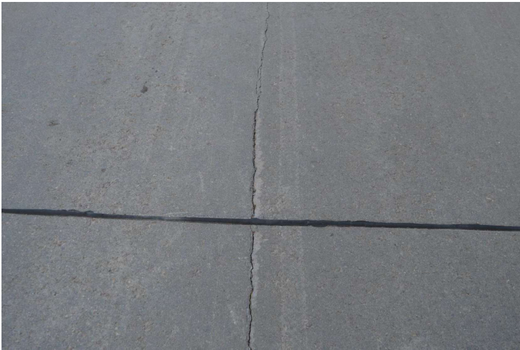
Vyksta betono irimas atsiradusiose betono dangos plyšiuose.
