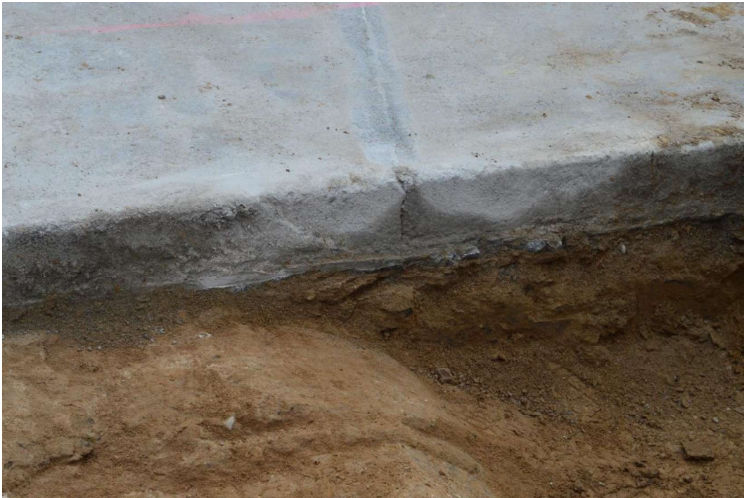
Skirtingų stiprių stabilizuotas pagrindo sluoksnis.
