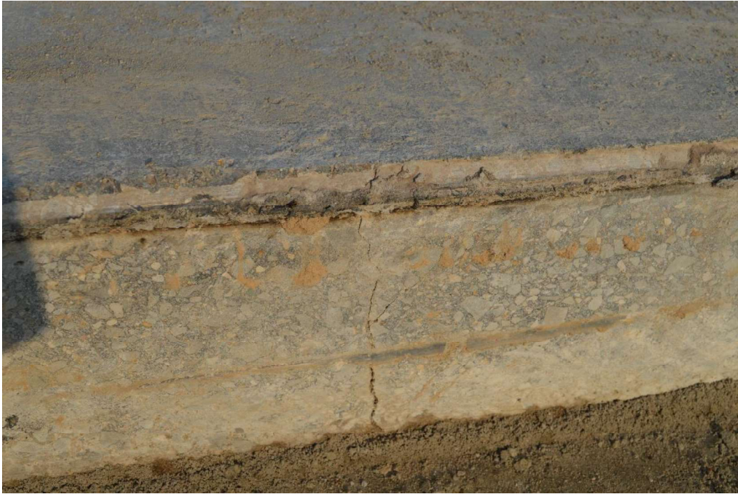
Plyšys platėjantis į apačią. Tokios formos plyšiai formuojasi netolygiai sėdant pagrindams.
