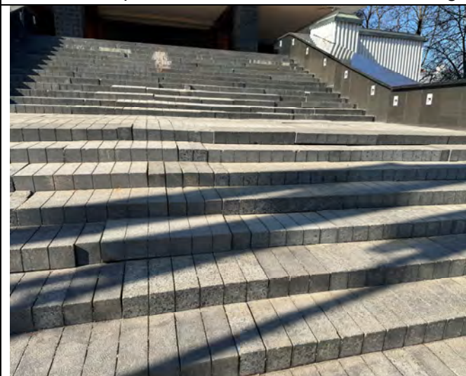
Paradinių laiptų fragmentas. Užfiksuotos iškilbusios, susmegusios laiptatakių ir laiptų aikštelės granito trinkelės
