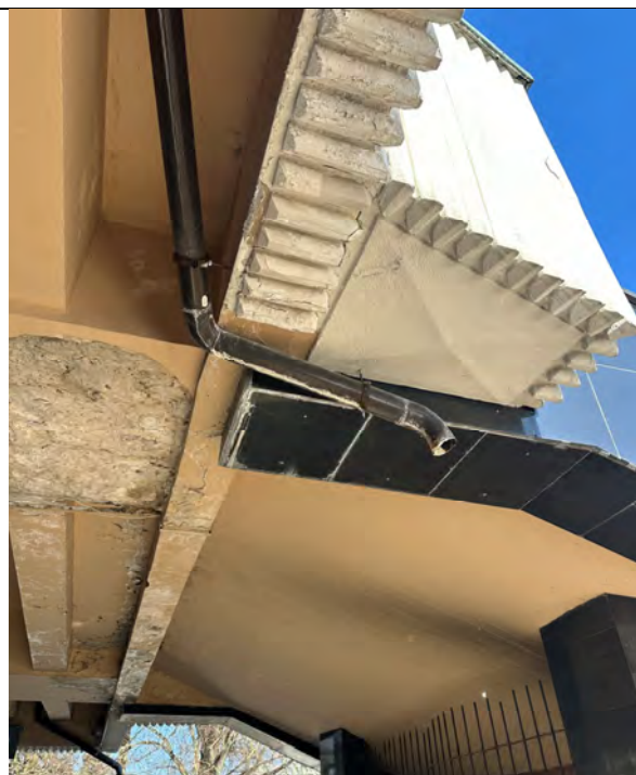
Galerijos perdangos fragmentas ties paradiniais laiptais. Užfiksuoti drėgmės įtakoti perdangos tinko pažeidimai, išvesti neestetiški išoriniai lietvamzdžiai abipus laiptų, matosi autentiški šviestuvai, kuriems reikalinga restauracija
