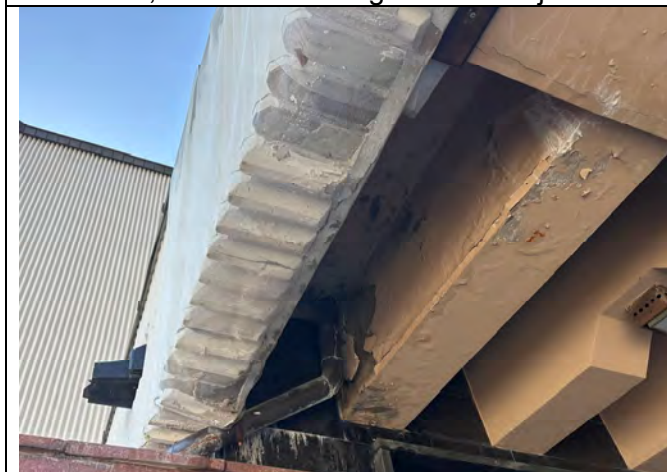
Galerijos atitvaros fragmentas. Užfiksuotas vėlesnių remontų metu įrengtas išorinis lietvamzdis
