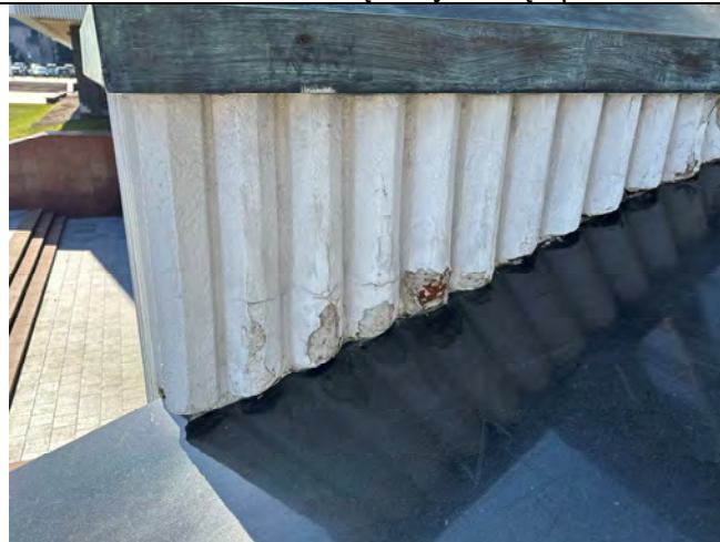
Paradinių laiptų fragmentas. Užfiksuotas pažeistas profiliuotas dekoratyvus tinkas
