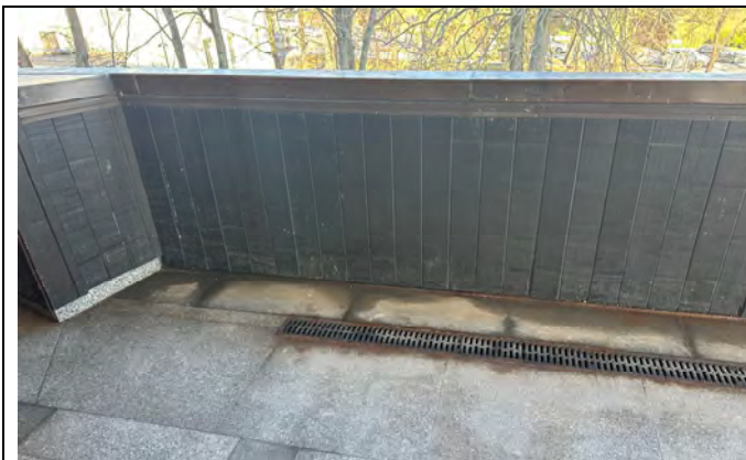
Galerijos fragmentas. Užfiksuotas išorinis latakas, granito plokščių danga ir medinių dailylenčių apdaila (vanduo kaupiasi ties išorine atitvara, o ne subėga į lataką- neteisingai įrengti nuolydžiai)
