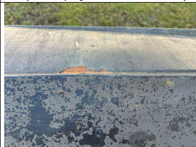
Galerijos atitvarų apskardinimo fragmentai. Užfiksuoti paviršiaus pažeidimai
