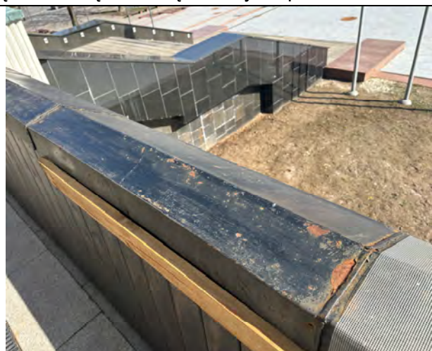
Galerijos atitvarų apskardinimo fragmentai. Užfiksuoti paviršiaus pažeidimai
