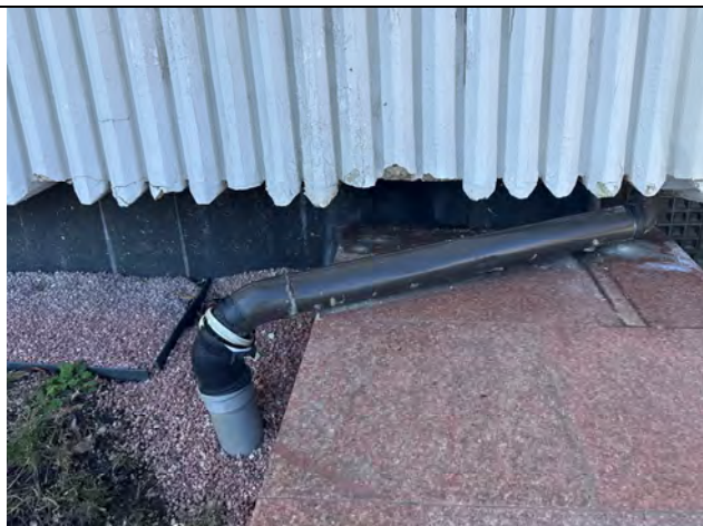
Galerijos atitvaros fragmentas. Užfiksuotas vėlesnių remontų metu įrengtas išorinis lietvamzdis
