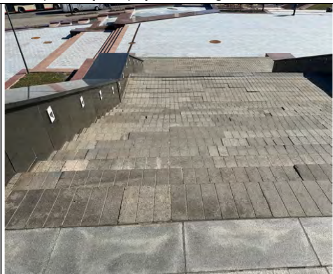
Paradinių laiptų fragmentas. Užfiksuotos iškilbusios, susmegusios laiptatakių ir laiptų aikštelės granito trinkelės
