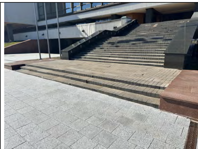
Paradiniai laiptai. Užfiksuotos iškilbusios, susmegusios laiptatakių ir laiptų aikštelės granito trinkelės
