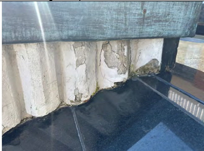
Paradinių laiptų fragmentas. Užfiksuotas pažeistas profiliuotas dekoratyvus tinkas
