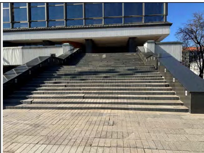
Paradiniai laiptai. Užfiksuotos iškilbusios, susmegusios laiptatakių ir laiptų aikštelės granito trinkelės
