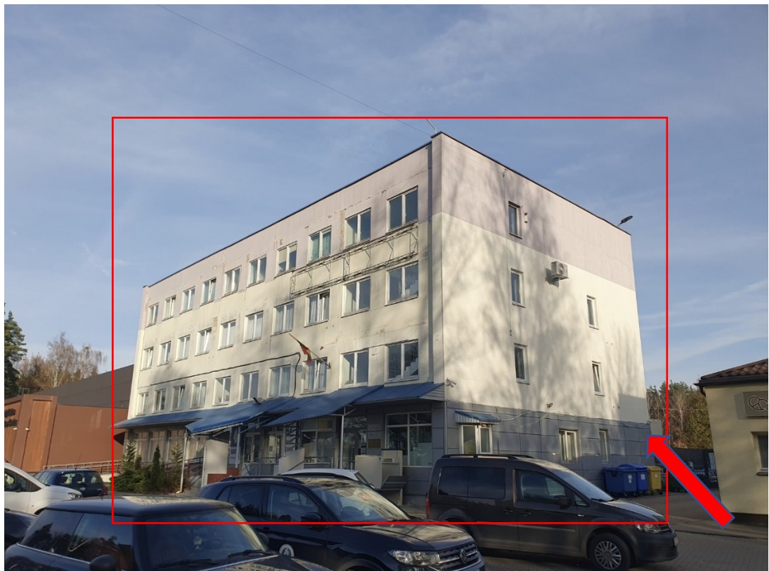
Fotonuotrauka Nr. 2 Remontuojamas Administracinis pastatas (unikalus Nr. 5197-5008-3020), S. Daukanto g. 19, Kazlų Rūdoje, pažymėtas raudonu kontūru. Vaizdas iš pietvakarinės pusės nuo S. Daukanto gatvės.
