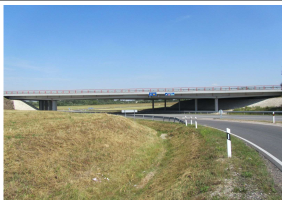
1.2 pav. Viaduko bendras vaizdas žiūrint nuo Klaipėdos pusės
