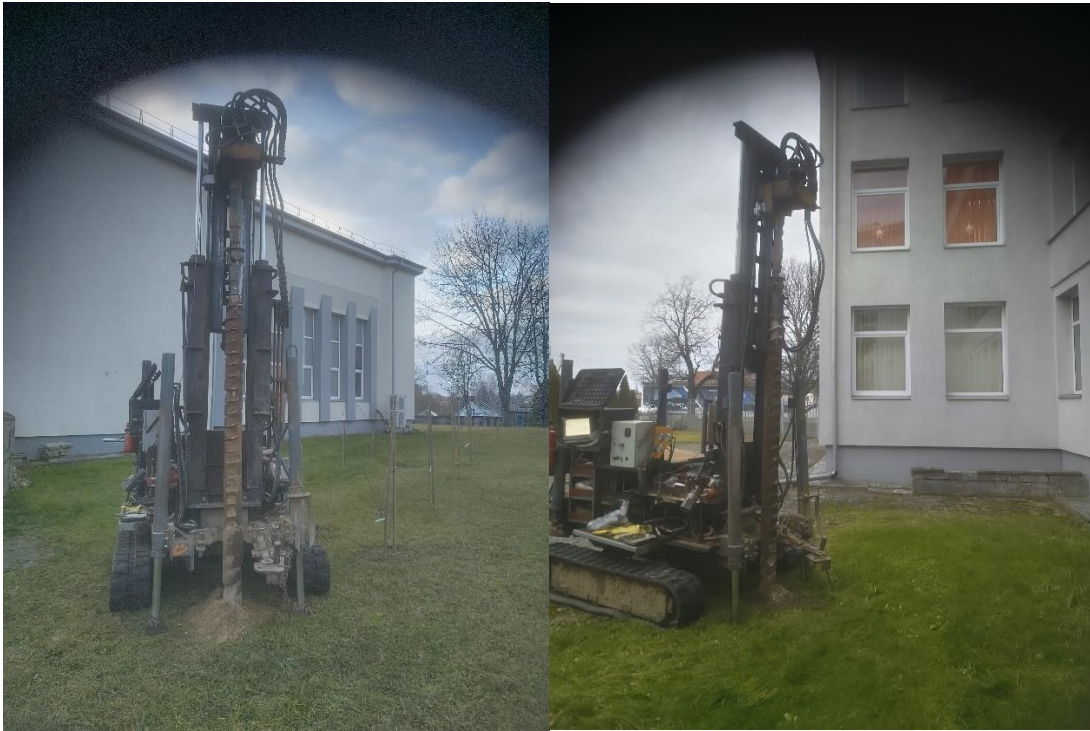
1-2 pav. Lauko darbai.
