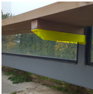
Suolą tvirtinti tik prie šoninių sienelių, padarant skersines atramas bei atsisakant tvirtinimo prie stiklo plokštumos. .
