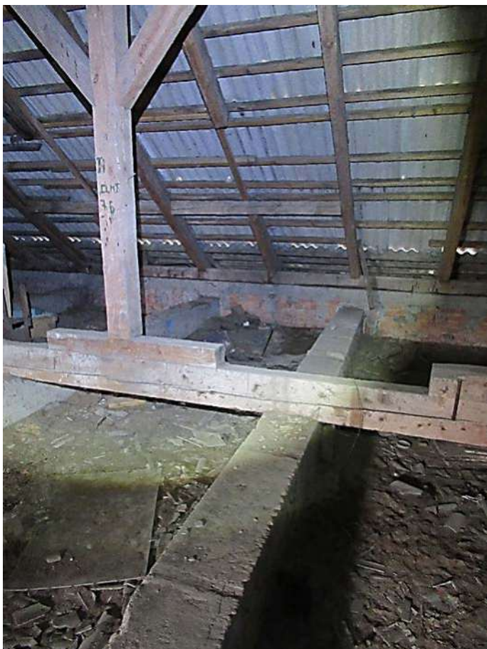
Nuotrauka Nr. 53. Pastogės fragmentas tarp ašių “4-8” ir “H-J”. Ant tarpaukštinės perdangos sijomis į viršų įrengta stogo laikanti konstrukcija, ilginiai ant kurių remiasi rėmai. Perdangos tarpatramiai užpildyti smėlio-statybinio laužo užpildu. Gegnių žingnis 0,9 m ant jų grebėstai kas 30 cm ir asbecementiniai lakštai.
