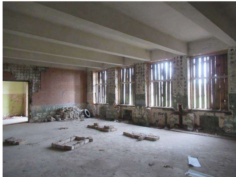
Nuotrauka Nr. 30. Vidaus patalpų fragmentas pirmo aukšto tarp ašių „3-6“ ir „A-D“. Buvusi valgyklos patalpa. Tarpaukštinė perdanga monolitinė su sijomis į apačią. Langų sąramos monolitinės sijų apačios lygyje.
