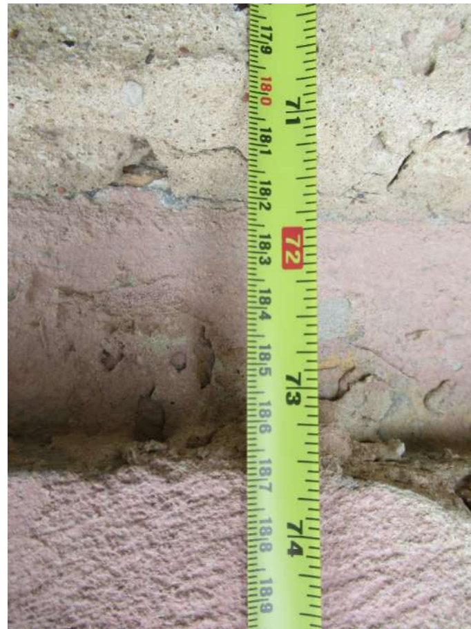
Nuotrauka Nr. 74. Kasinys Nr. 1. Pastato pamatai juostiniai betoniniai. Iki cokolio nustatytas aukštis ~180 cm
