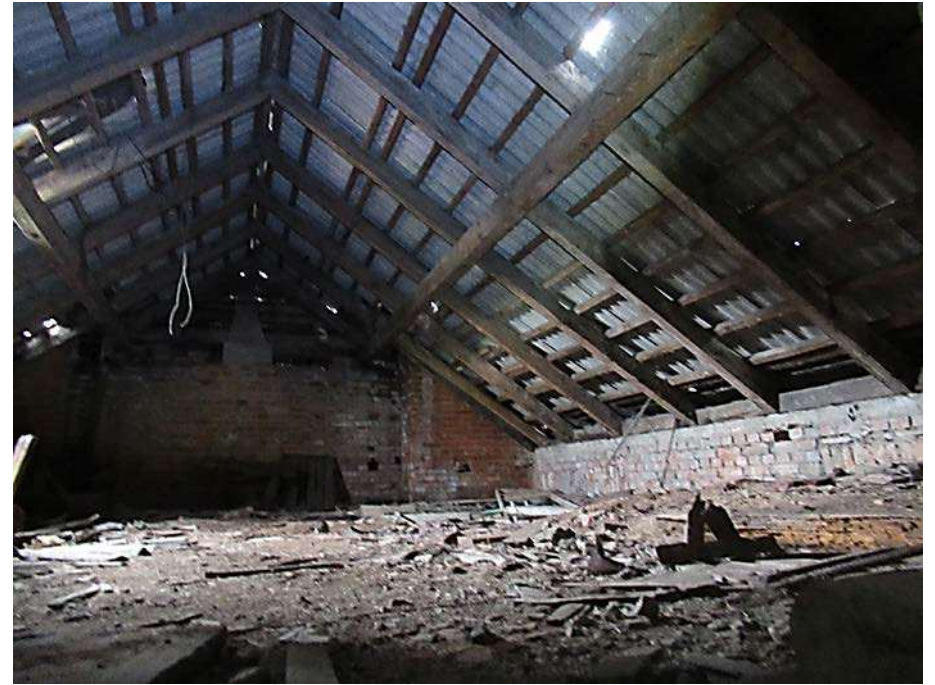
Nuotrauka Nr. 56. Pastogės fragmentas tarp ašių “5-8” ir “E-H”. Stogo laikančios konstrukcijos remiasi į išilgines laikančias sienas, pakeltas ~0,5m, ant jų įrengta monolitinė juosta ir mūrtašis. Gegnių žingnis 0,9m stogo danga asbestcemento lakštai. Konstrukcija remiasi ant ilginių atremtų į skersines mūro sienas. Kairėje pusėje įrengtas įstiklintas švieslangis.
