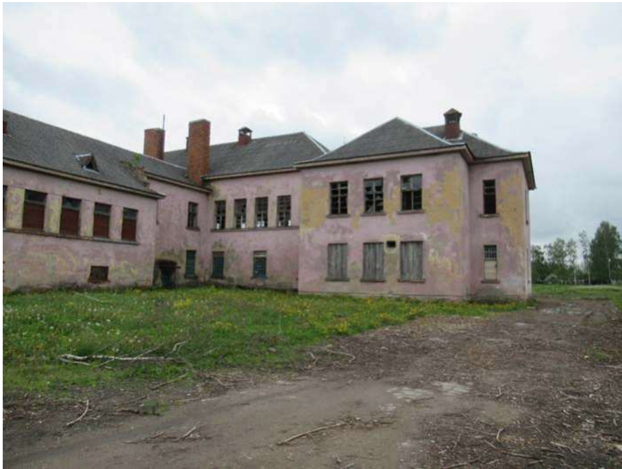
Nuotrauka Nr. 1. Pastato fasado fragmentas tarp ašių „1-5“ ir „E-J“. Pastatas 2-jų aukštų, sienos plytų mūro, tinkuotos iš išorės, dažytos. Stogo forma – daugiašlaitės (dvišlaitė valminė ir šlaitinė), danga – banguotų asbescemenčio plokštės, apskardinti sujungimai. Kaminai - mūriniai netinkuoti iš lauko. Lietaus nuvedimo sistema dalinai neorganizuota. Cokolis tinkuotas.
