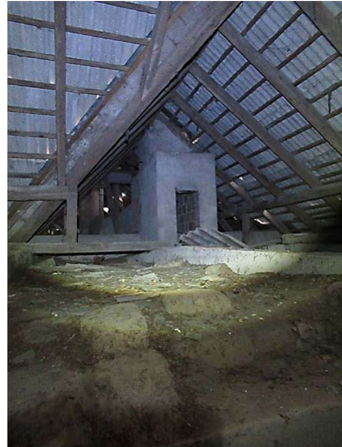
Nuotrauka Nr. 46. Neeksploatuojamos pastogės fragmentas tarp ašių "10-12" ir "A-G". Matosi stogo laikančioji konstrukcija. Stogo danga asbecementinių lakštų tvirtintų prie grebėstų 5x5 cm. Dūmtraukiai iki stogo dangos tinkuoti.
