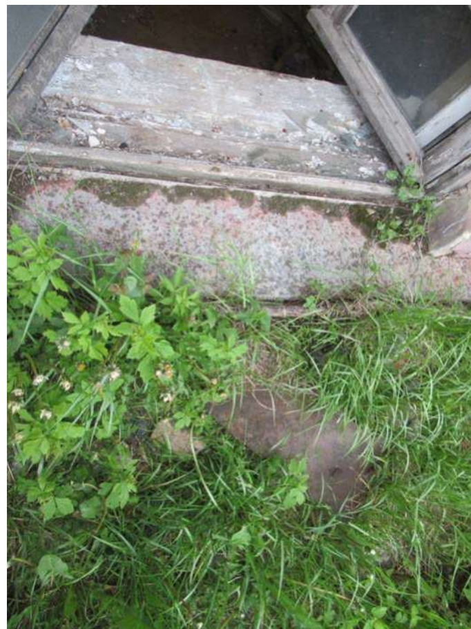
Nuotrauka Nr. 20. I-o aukšto lango rėmo fragmentas iš arti. Langų rėmai mediniai dvivėriai su padalijamais, dvigubi. Langai dviejų dalių, dviejų varčių. Viršutinė dalis nevarstoma, apatinė varstoma su orlaidėmis. Atsidaro į vidų. Vidaus palangė medinė, likę grotų tvirtinimo liekanos. Nuogrinda apaugusi žole iki pastato. Lauko palangė apskardinta, apsamanojusi.
