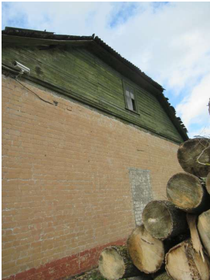
Nuotrauka Nr. 63. Sandėliavimo paskirties pastato fasado fragmentas ašyje "2". Sienos plytų mūro, dažytos dveims spalvoms, pastogės pertvara medinių lentų, remiasi į siją atremtą į išilgines sienas. Į pastogę įrengtas šveislangis, buvusių durų anga užmūryta.
