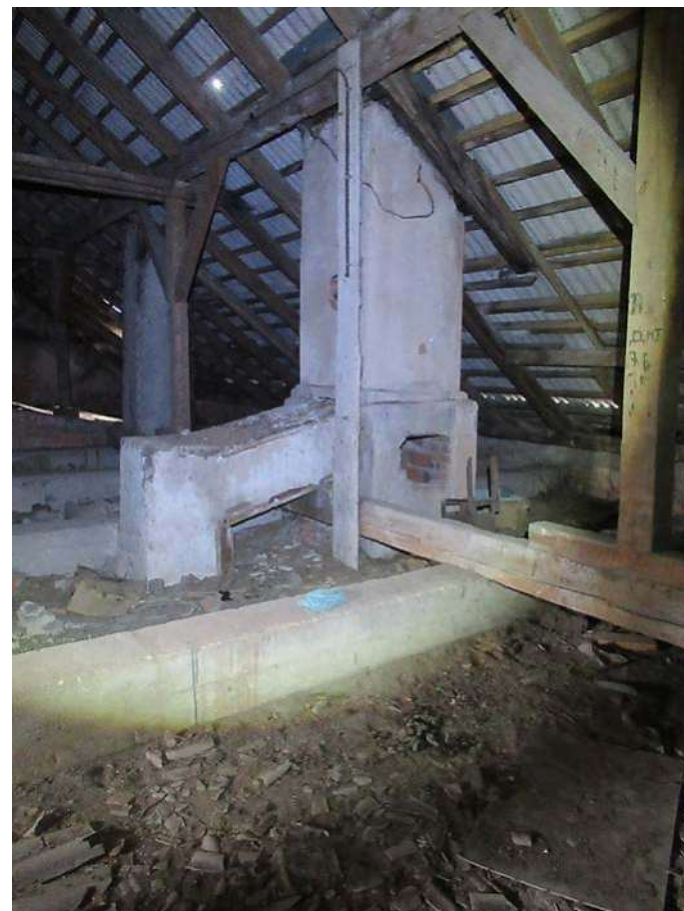
Nuotrauka Nr. 54. Pastogės fragmentas tarp ašių “4-8” ir “H-J”. Ant tarpaukštinės perdangos sijomis į viršų įrengta stogo laikanti konstrukcija, ilginiai ant kurių remiasi rėmai. Perdangos tarpatramiai užpildyti smėlio-statybinio laužo užpildu. Dūmtraukis iki stogo dangos tinkuotas. Matosi ležakas į dūmtraukį.
