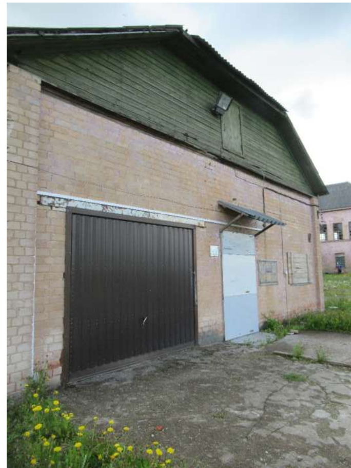
Nuotrauka Nr. 64. Sandėliavimo paskirties pastato fasado fragmentas ašyje "1". Matosi išilginių laikančių sienų kontūras, ant jų atremtos medinės stogo laiknčios konstrukcijų sijos, įrengta neeksploatuojama pastogė. Įrengti stačiakampės formos garažo vartai, virš įrengta metalinė sąrama, dešiniau matosi įrengtas įėjimas į pastatą su stogeliu. Pandusas turi nuolydžio kampa, betonuotas. Į pastogę įrengtos durys. Pastogės pertvara medinių lentų. Lietaus nuvedimo sistema neorganizuota.
