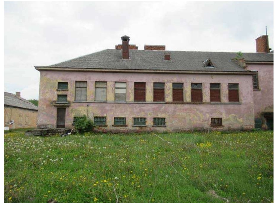
Nuotrauka Nr. 2. Pastato fasado fragmentas tarp ašių „E-J“. Pastatas 2-jų aukštų, sienos plytų mūro, tinkuotos iš išorės, dažytos. Stogo forma – valminė, danga – asbescemento plokštės, apskardinti sujungimai. Kaminai - mūriniai netinkuoti. Lietaus nuvedimo sistema neorganizuota. Cokolis tinkuotas, tinkas erodavęs. Lauko laiptai betoniniai, apkaustyti. Įrengtas stogelis virš įėjimo. Fasado tinkas susidėvėjęs. Įrengtas stoglangis į pastogę.
