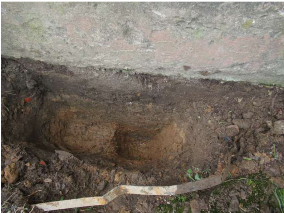
Nuotrauka Nr. 73. Kasinys Nr. 1. Pastato pamatai juostiniai betoniniai. Iki cokolio nustatytas aukštis ~180 cm
