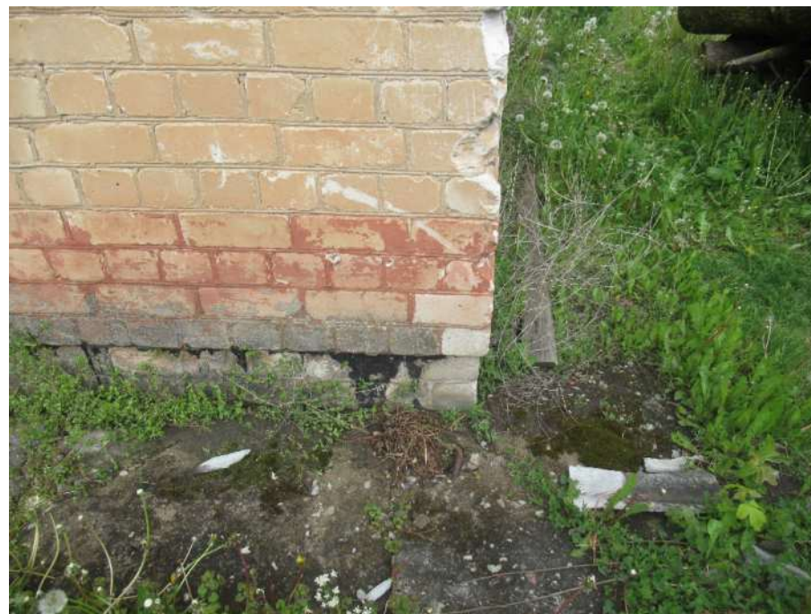
Nuotrauka Nr. 62. Sandėliavimo paskirties pastato fasado fragmentas ašių "A" ir "2" sankirtoje. Pastato sienos plytų mūro, dažytos. Cokolis dviejų plytų aukščio, tarp plytų sienos ir cokolio įrengtas izoliacijos sluoksnis. Virš cokolio dažyta dviems spalvomis. Nuogrinda betoninė visu pastato perimetru. Siūlės - brauktos.
