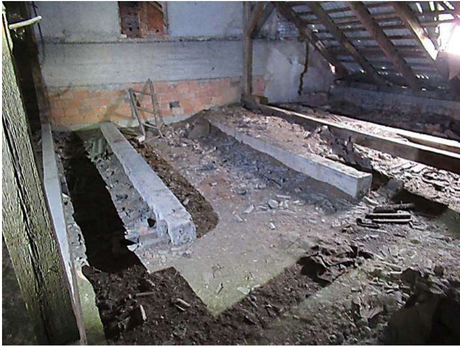
Nuotrauka Nr. 56. Pastogės fragmentas tarp ašių “4-8” ir “I-H”. Šioje vietoje tarpaukštinės perdangos sijos remiasi skersai išilginių sienų.
