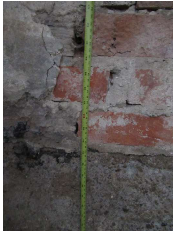
Nuotrauka Nr. 74. Atodanga Nr. 3. Pastato pamatai juostiniai betoniniai. Cokolio nustatytas aukštis ~83 cm.
