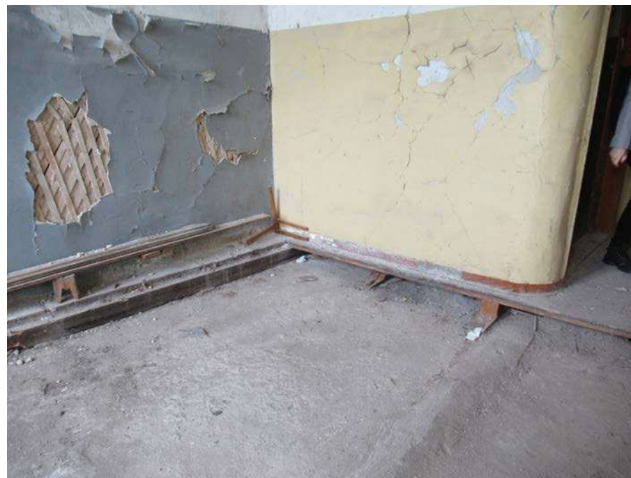
Nuotrauka Nr. 48. Patalpos fragmentas antrame aukšte tarp ašių “10-11” ir “A-E”. Matosi medinės pertvaros tinkuotos ant balanų, dažytos. Grindų konstrukcija ant monolitinės perdangos gulekšniai su ištisu lentų paklotu.
