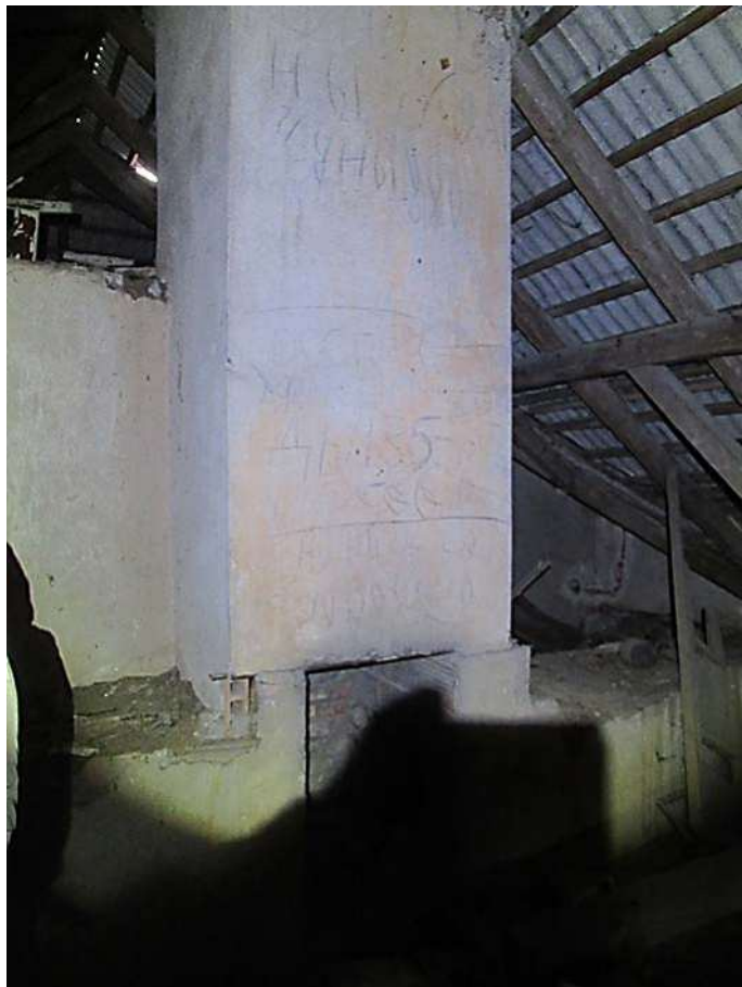
Nuotrauka Nr. 47. Neeksploatuojamos pastogės fragmentas tarp ašių “10-12” ir “A-G”. Matosi stogo laikančioji konstrukcija. Stogo danga asbecementinių lakštų tvirtintų prie grebėstų 5x5 cm. Dūmtraukiai iki stogo dangos tinkuoti.
