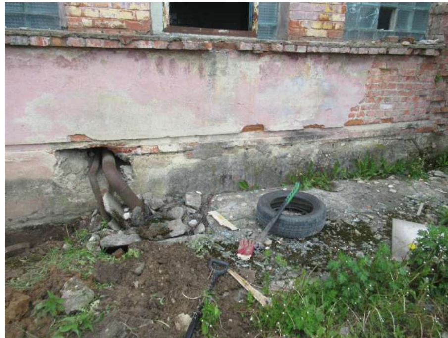
Nuotrauka Nr. 76. Pastato cokolio fragmentas. Matosi g/b cokolio ir plytų mūro sandūroje įrengta izoliacija. Vėliau įrengta anga vamzdžiams. Alsuojanti nuogrinda betoninė. Cokolis atskirtas vagele ~5 cm aukščio. Palangės formuotos pusės plytos ilgio, šioje vietoje neapskardintos. Dešinėje pusėje lietaus vandens padaryti defektai sienų sandūrų vietoje, tinkas nubyrėjęs, matosi raudonų plytų mūras.
