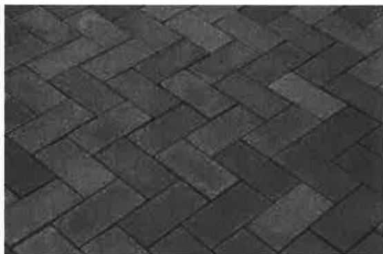
Betoninių trinkelų 20x10x8 klojimo piešinys.
