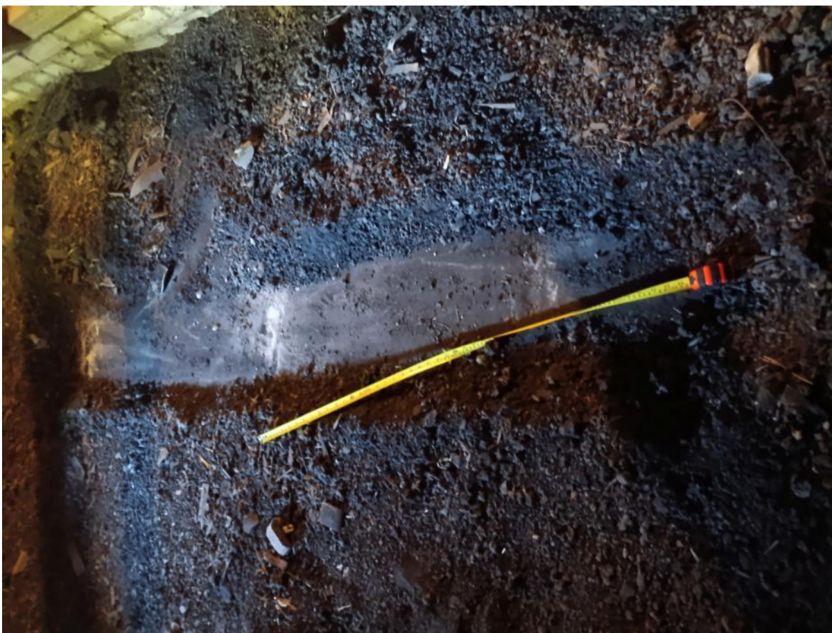
7 pav. Perdangos plokščių paviršius iš palėpės pusės
