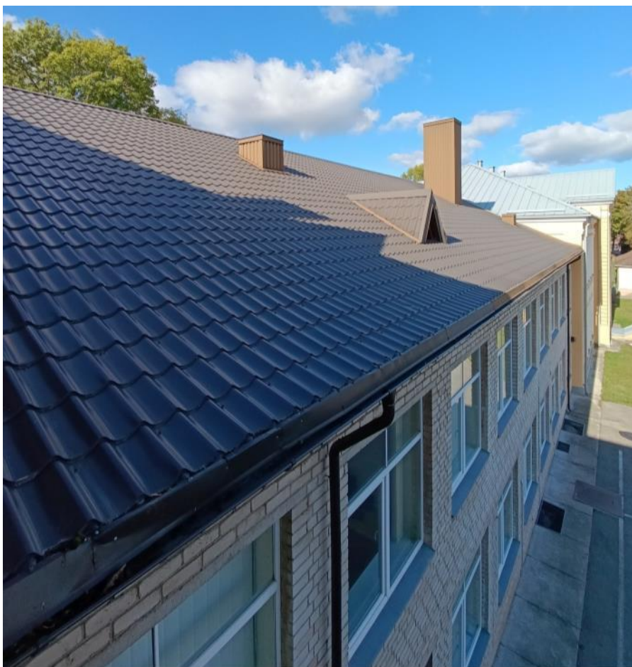
16 pav. 4C3/p dviaukštės dalies stogo vaizdas
