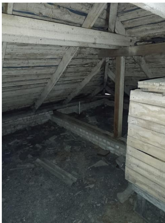
19 pav. 4C3/p triaukštės dalies palėpės vaizdas ties numatoma lifto šachta
