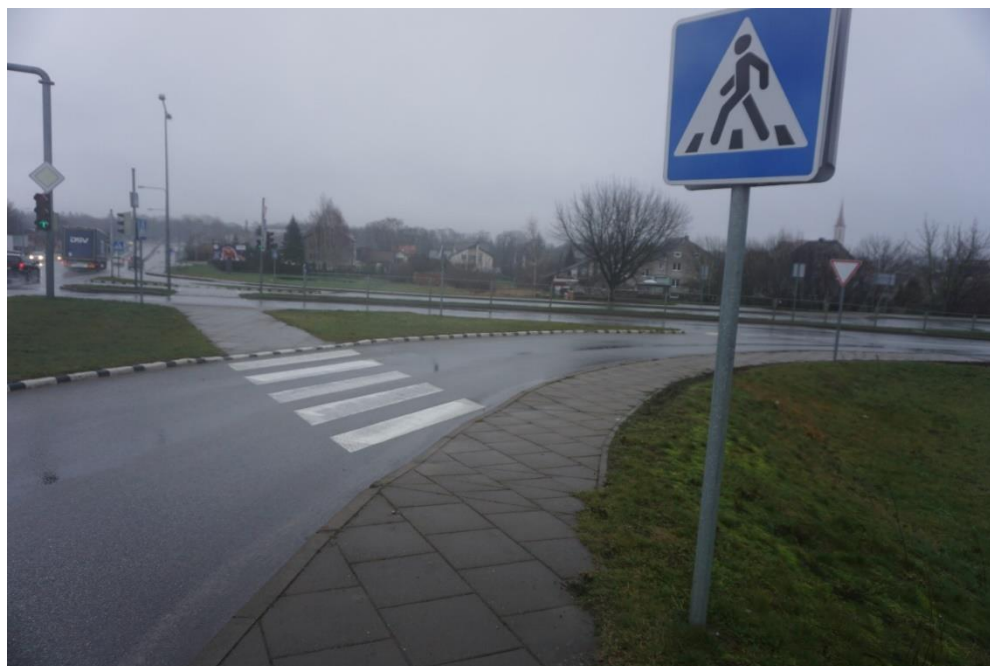
2.4 pav. Pėsčiųjų perėja sankryžoje
