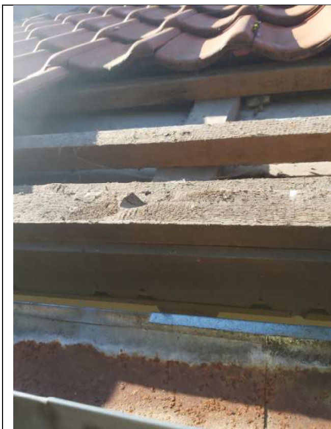
FF_12. Šiaurės rytų fasade
