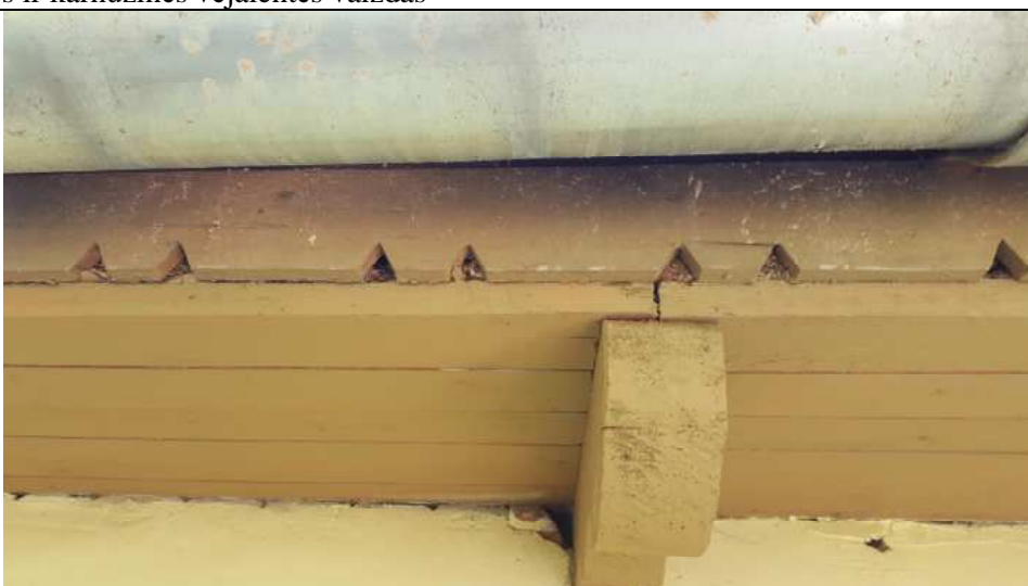
FF_07. Gegnės ir karnuzinės vėjalentės vaizdas
