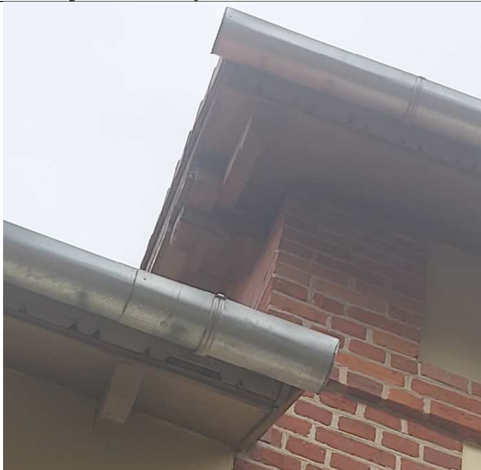
FF_09. Gėgnė ir karnuzinė vėjalentė vaizdas
