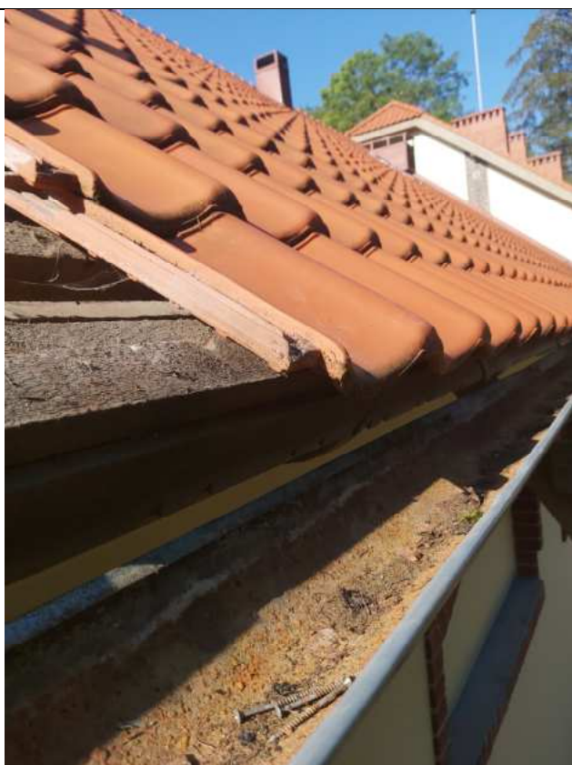
FF_13. Šiaurės rytų fasade
