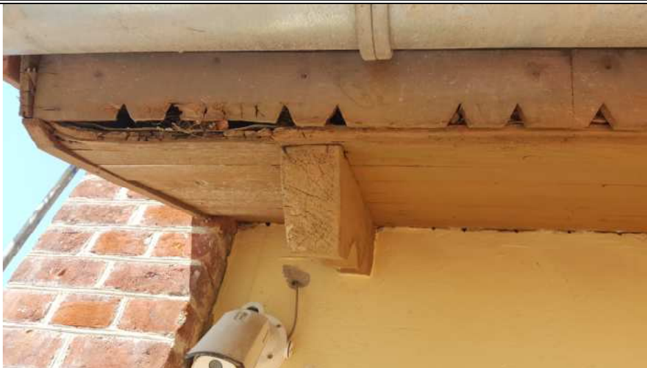
FF_05. Gegnės ir karnuzinės vėjalentės vaizdas
