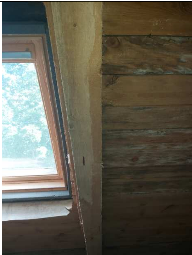
FF 15 - 16. Gegnių ir apkalimo vaisdas pastogėje
