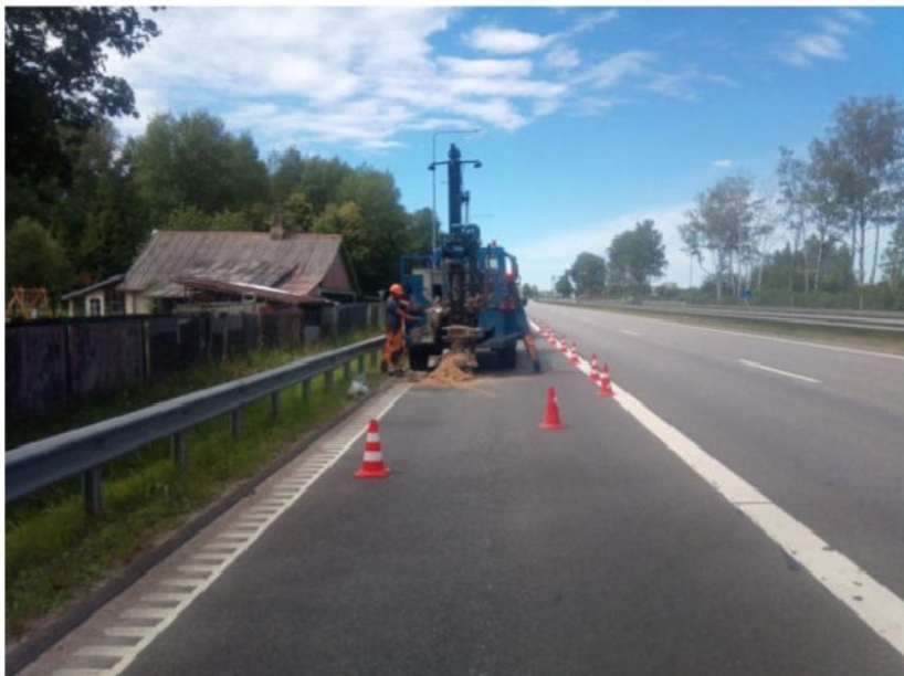
1 pav. Lauko darbai ties gręžiniu Gr.SZ-2
