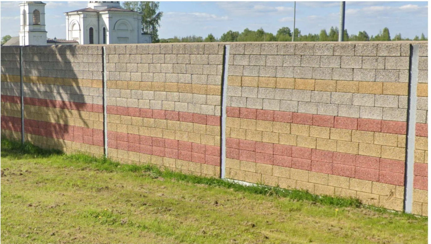
8 pav. Triukšmo sienų vidinė betono ir blokelių apdaila
