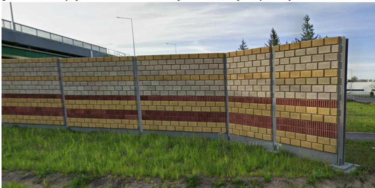
4 pav. Triukšmo sienų išorinė blokelių apdaila
