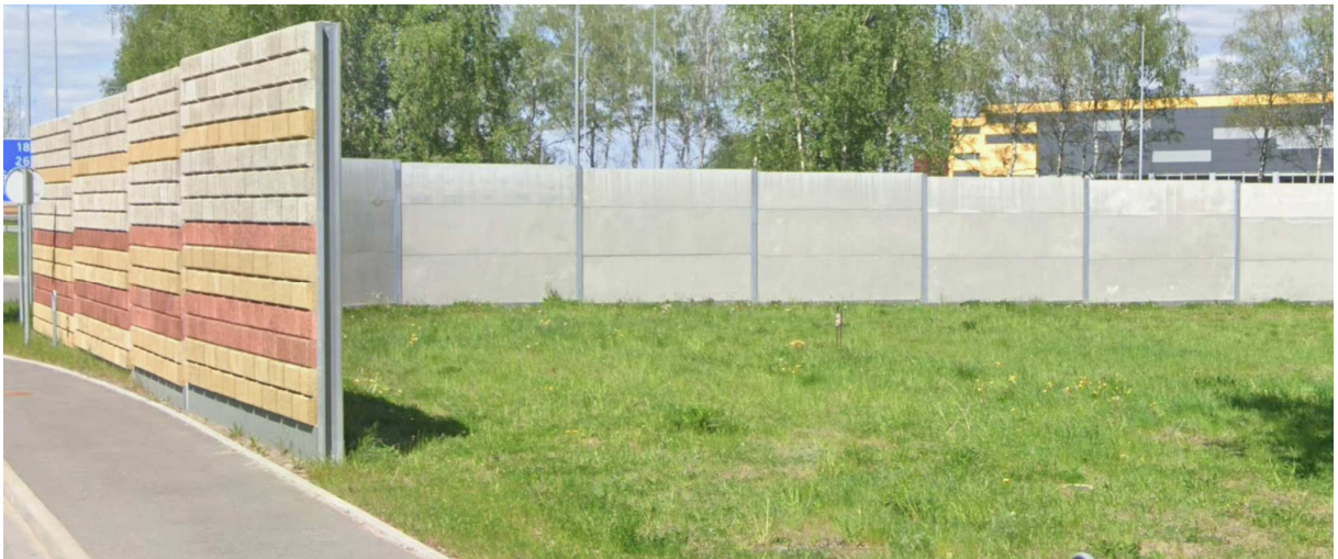
7 pav. Triukšmo sienų vidinė betono ir blokelių apdaila
