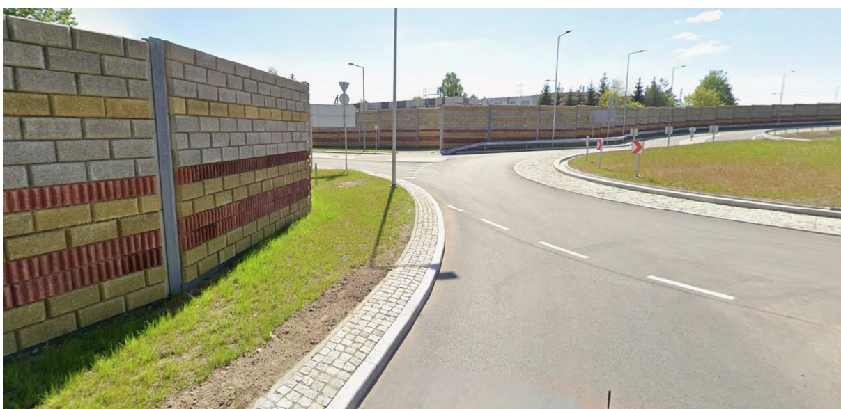
5 pav. Triukšmo sienų išorinė blokelių apdaila
