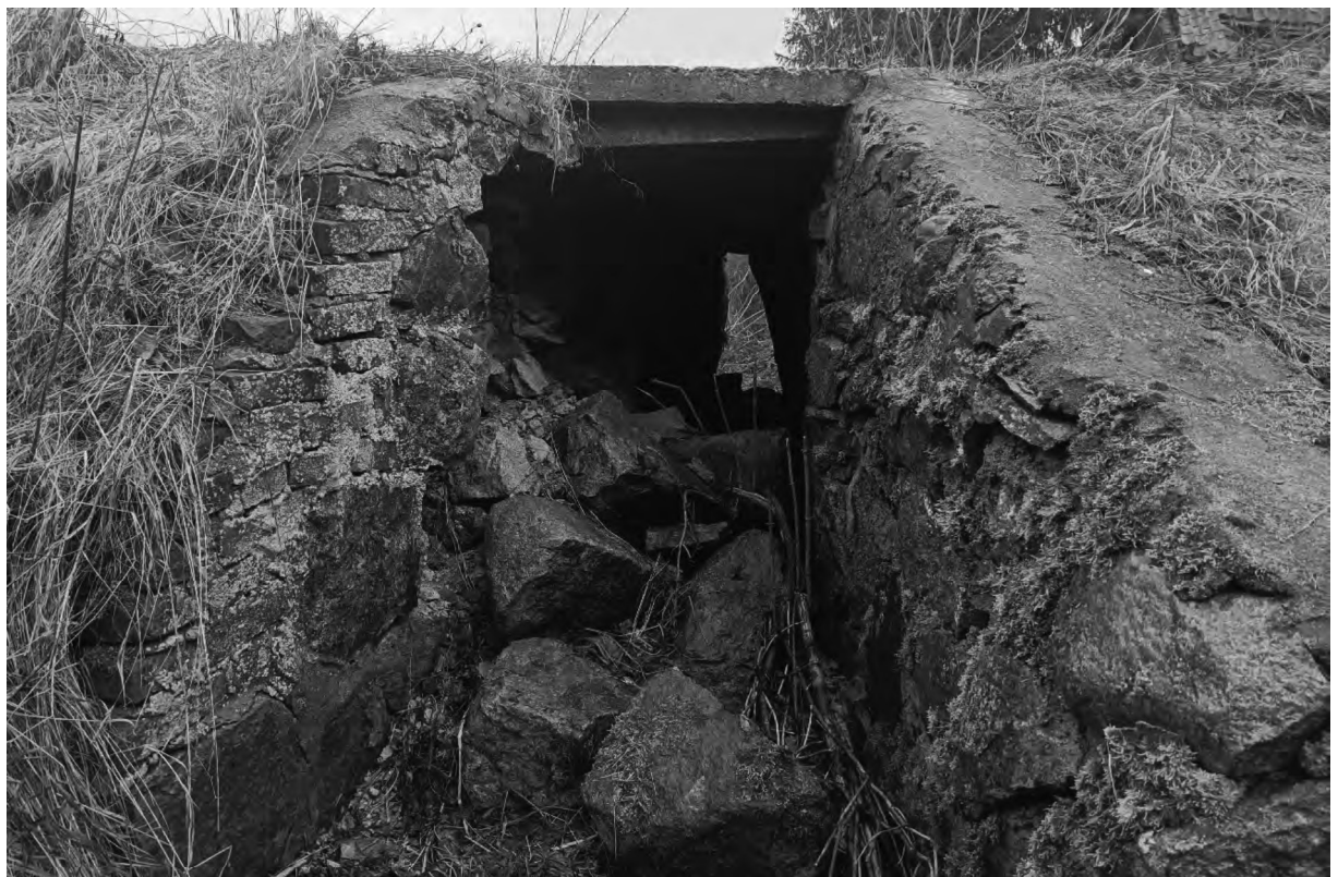
6 pav. Atramų akmens ir plytų mūras sukritęs po tilto perdanga.
