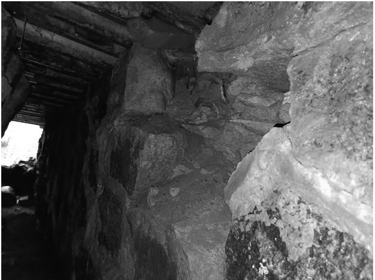
5 pav. Krantinės atramos yra pasvirusios, akmens mūras ištrupėjęs, iškritęs.
