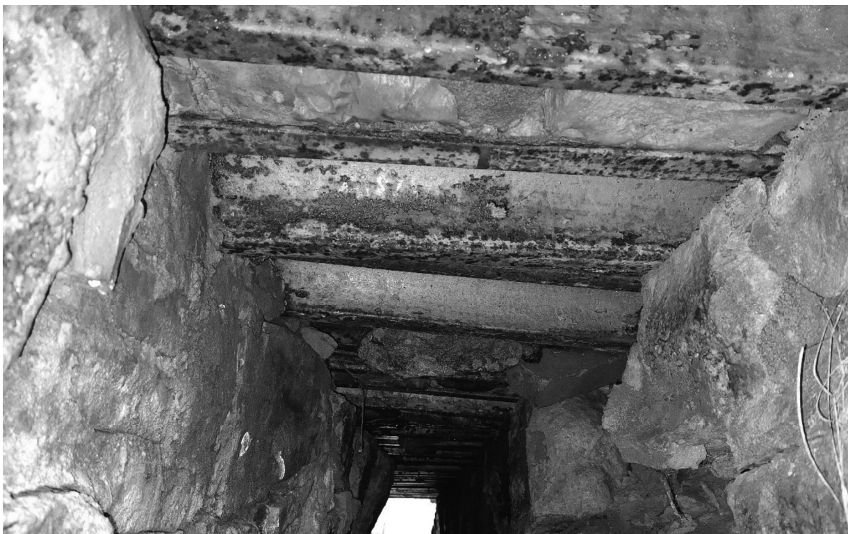
4 pav. Perdangos sijos paveiktos korozijos, užpildas iškritęs.
