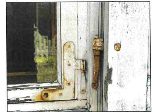
3.1.2 LANGŲ METALINIŲ KAMPUOČIŲ - VYRIŲ IR LANGINIŲ VYRIŲ REMONTAS
