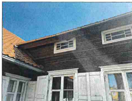
1.1.8 KIEMO FASADO KARNIZO SUFORMUOTO IŠ LENTŲ REMONTAS, LANGŲ PERDAŽYMAS
