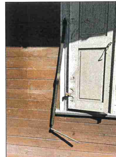
3.1.1 METALINIŲ VYRIŲ IR LANGINIŲ UŽDARYMO METALINIO ELEMENTO REMONTAS
