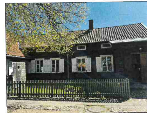
1.1.1* PRIESTATO FASADO IR VERANDOS HORIZONTALAUS LENTŲ APKALIMO REMONTAS
