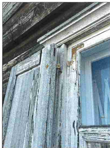
2.1.3 MEDINIŲ FILINGINIŲ LANGINIŲ REMONTAS, 3.1.2 METALINIŲ LANGŲ KAMPUOČIŲ REMONTAS 3.1.1 METALINIŲ LANGINIŲ VYRIŲ REMONTAS
