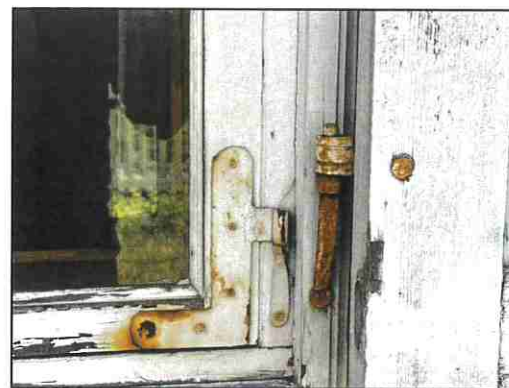
LANGŲ METALINIŲ KAMPUOČIŲ - VYRIŲ IR LANGINIŲ VYRIŲ REMONTAS
