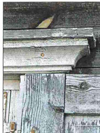
1.1.5 VIRŠ LANGŲ ESAMI MEDINIAI PROFILIUOTI SANDRIKAI
