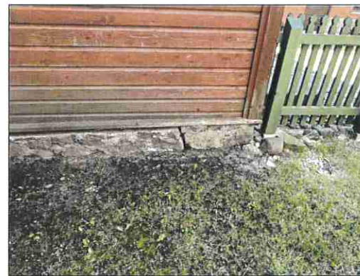
2.1.3 RESTAURUOJAMAS PRIESTATO VERANDOS LAUKO AKMENŲ MŪRO PAMATAS
