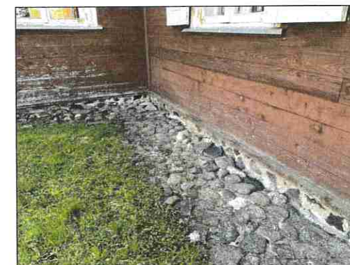
1.1.1 ESAMO LAUKO AKMENŲ MŪRO PAMATO RESTAURAVIMAS
