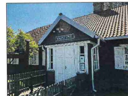
1.1.6 VERANDOS MEDINIO PROFILIUOTO KARNIZO, ESAMO VIRŠ LANGŲ VISU PERIMETRU, REMONTAS
