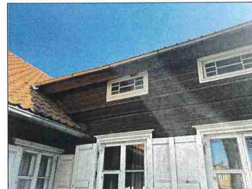
1.1.1* PRIESTATO FASADO HORIZONTALAUS LENTŲ APKALIMO REMONTAS. 2.1.1 LANGŲ REMONTAS
