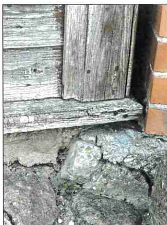
1.1.4 COKOLIO KARNIZINĖS LENTOS IR FASADO 1.1.2 KAMPO VERTIKALUS APLALIMAS LENTOMIS
