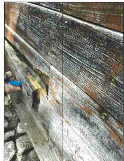
Z-7 ATPLĖŠUS KIEMO FASADO APKALIMO LENTĄ, MATOME KAD SIENOJAI YRA SVEIKI
