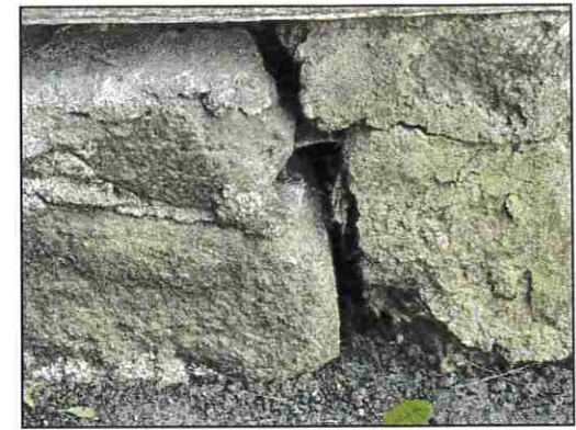
Z-5 PLYŠYS VERANDOS LAUKO AKMENŲ MŪRO PAMATE. VIETOMIS NEGILŪS ĮTRŪKIAI
