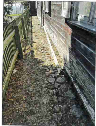
Z-3 PAGRINDINIO PASTATO COKOLIO KARNIZINĖ LENTA - NATITRŪKUSI NUO FASADO. LENTA PAVEIKTA PUVINIO
