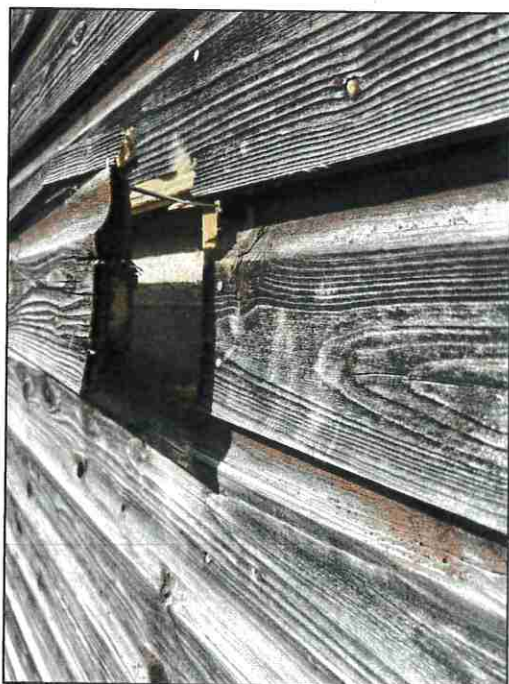
Z-2 ATPLĖŠUS PRIESTATO ŠONINIO FASADO APKALIMO LENTĄ, MATOME KAD SIENŲ SIENOJAI NEPAVEIKTI PUVINIO. PRIESTATO LENTŲ APKALIMAS SKIRIASI NUO PAGRINDINIO PASTATO
