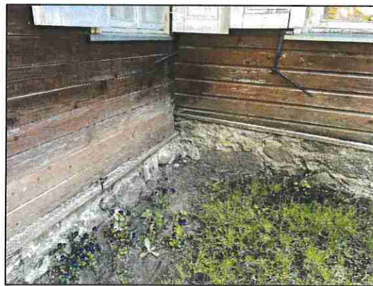
Z-6 PRIESTATO IR VERANDOS LAUKO AKMENŲ MŪRO PAMATE VIETOMIS NEGILŪS ĮTRŪKIAI. REIKALINGA PAMATO RESTAURACIJA
