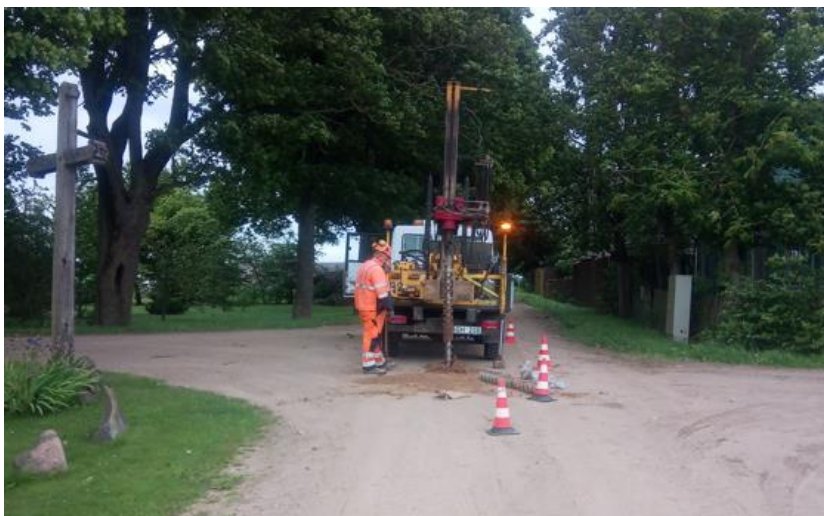
1 pav. Lauko darbai
