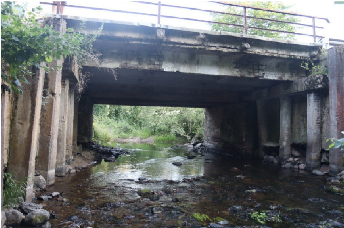
1 pav. Tiltu per Anykštos upę esamas fasadinis vaizdas
