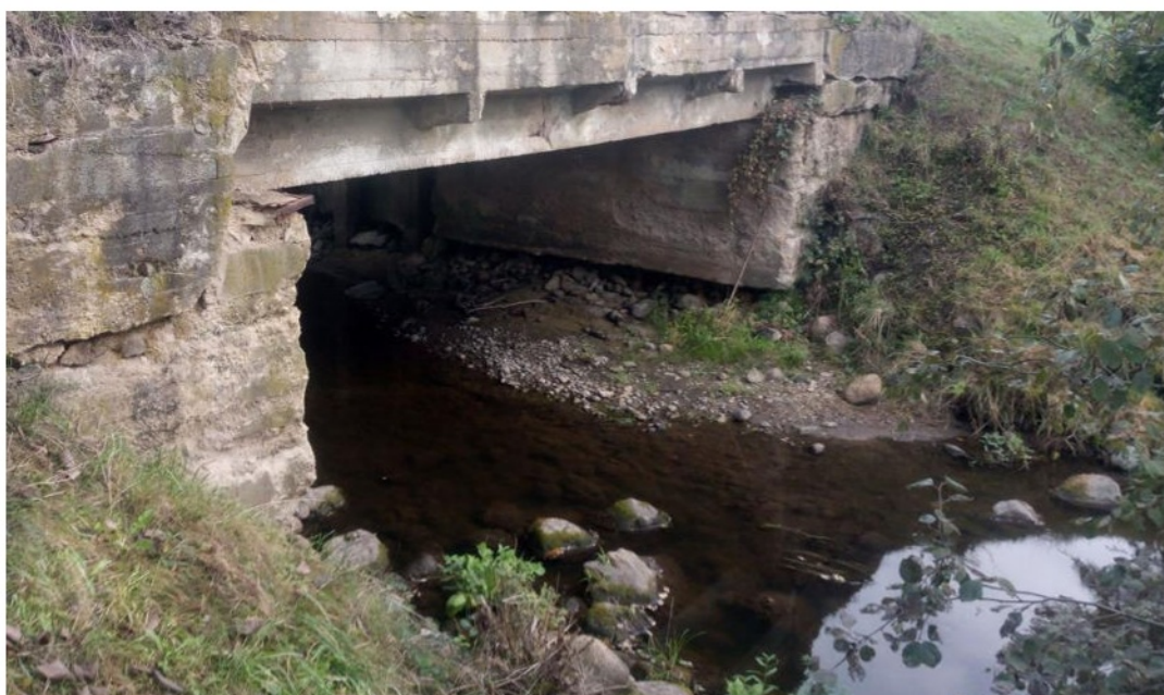
6 pav. Dešinėje nuotraukos pusėje matoma krantų erozija, kairėje gruntai išplauti po tilto konstrukcija
