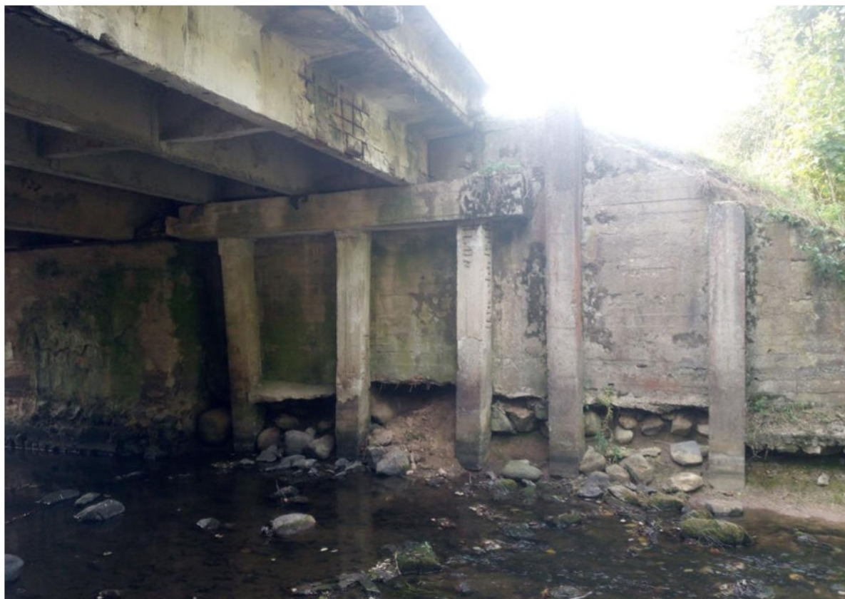
7 pav. Žiūrint skersai upės matomos byrančios tilto konstrukcijos: sija, atraminė sienutė, kolonos
