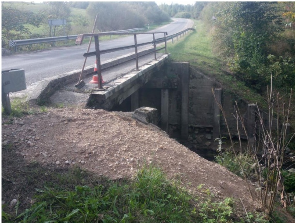
5 pav. Naujai supiltas gruntas šalia tilto
