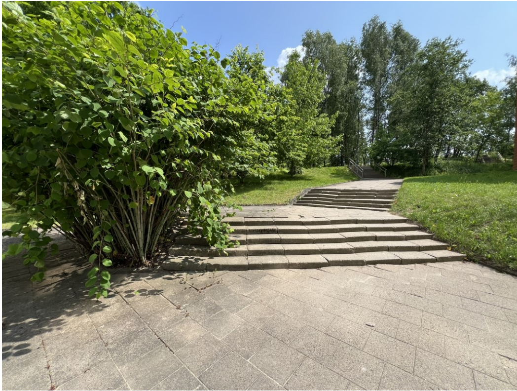
Pav.6. Daugumos laiptų esama būklė gali būti vertinama kaip neatitinkanti objekto prieinamumo reikalavimų, nėra įspėjamųjų paviršių, turėklų, apšvietimo.
