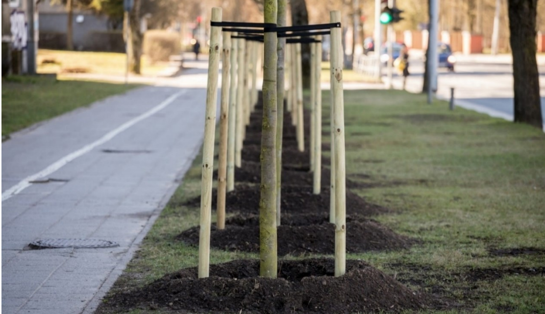
Pasodinus medį iš grunto suformuojamos duobutės medžio laistymui
