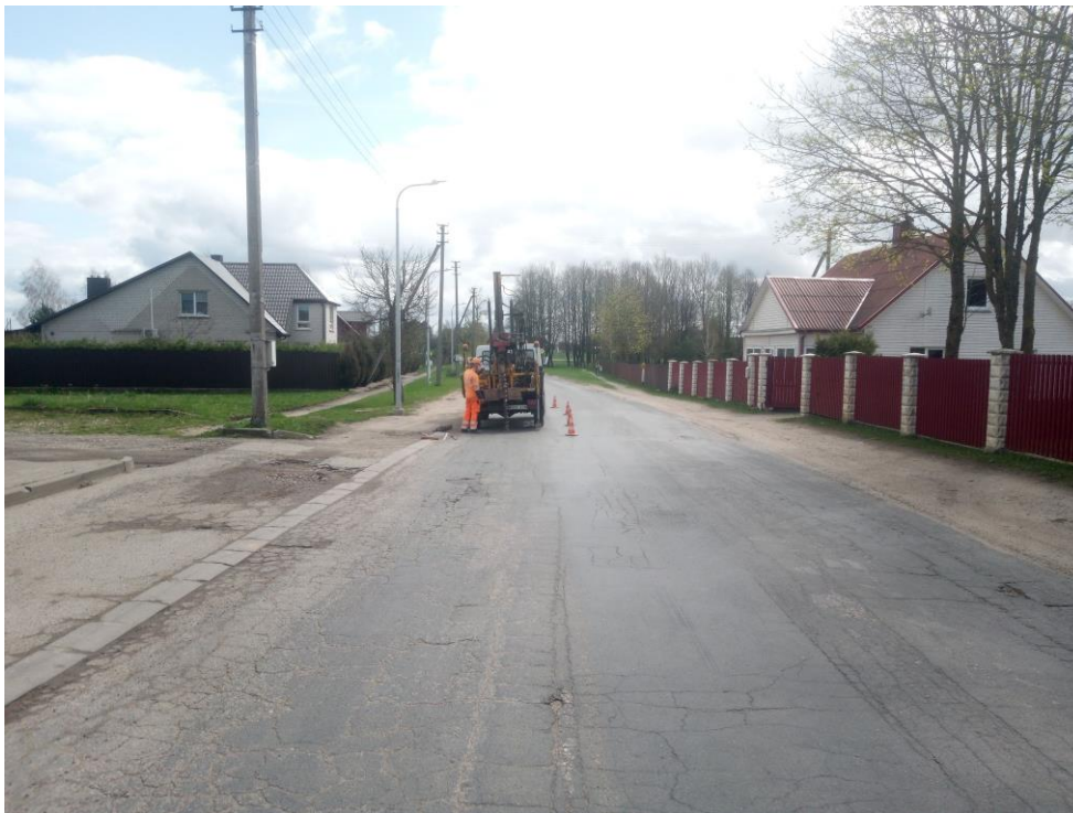
1 pav. Lauko darbai
