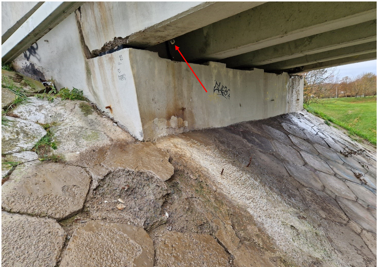
1.9 nuotrauka. Ties V atrama nulaužti nuo hidroizoliacijos nuleidimo vamzdžiai. Iš vamzdžių ištekantis vanduo drėkina V atramos rygelio paviršių, ardo kūgio šlaito sutvirtinimą
