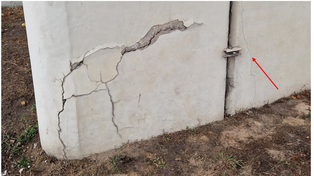
1.21 nuotrauka. II atramos bendras vaizdas žiūrint nuo III atramos. Supleišėjusi II atramos 2 kolonos apačia žemupio pusėje. Lokaliaje vietoje atitrūkęs ir atšokęs apsauginis betono sluoksnis. II atramos 1 kolonos apačioje, žemupio pusėje, atsivėręs išilginis plyšys
