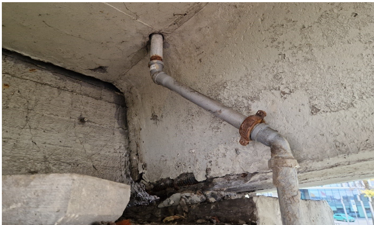
1.11 nuotrauka. Pirmos sijos bendras vaizdas virš I atramos žiūrint nuo žemupio pusės į sijos galą. Sijos gale atšokęs ir nukritęs apsauginis betono sluoksnis, koroduoja į paviršių išlindęs pagrindinės išilginės armatūros strypas
