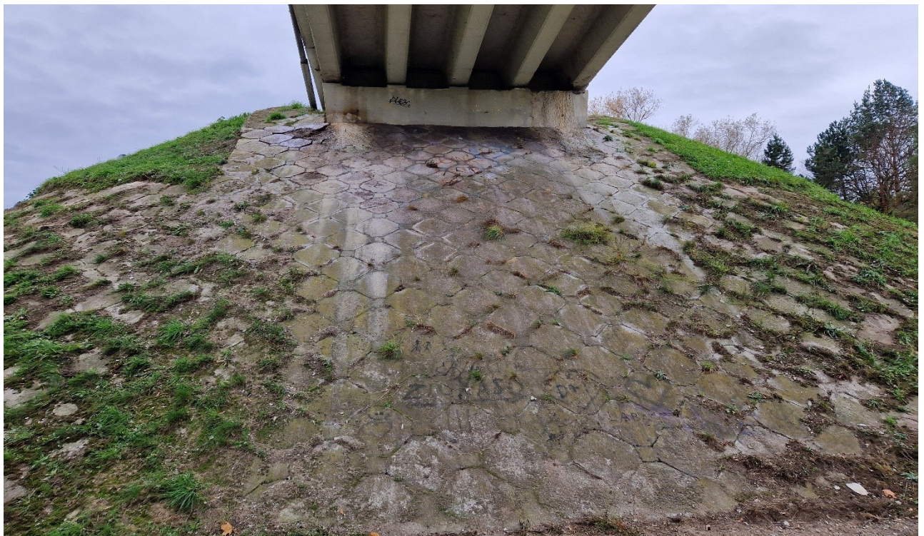
1.25 nuotrauka. Kūgio šlaito bendras vaizdas ties V atrama. Šlaito sutvirtinimą ardo iš šulinėlių nuo hidroizoliacijos ištekantis vanduo ir karbonatiniai produktai
