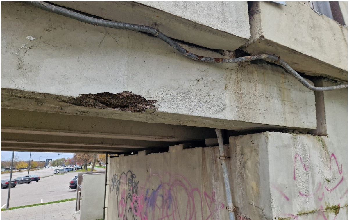
1.13 nuotrauka. Pirmos sijos bendras vaizdas virš I atramos. Apie 1,20 m atstumu nuo sijos galo lokaliaje vietoje atšokęs ir nukritęs apsauginis betono sluoksnis, koroduoja pagrindinė armatūra
