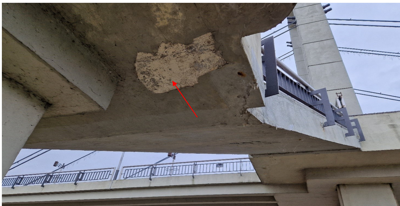
1.29 nuotrauka. Laiptų ties III atrama bendras vaizdas žemupio pusėje. Antros laiptasijos aikštelės apačioje lokaliaje vietoje atšokusi ir nukritusi apsauginė danga
