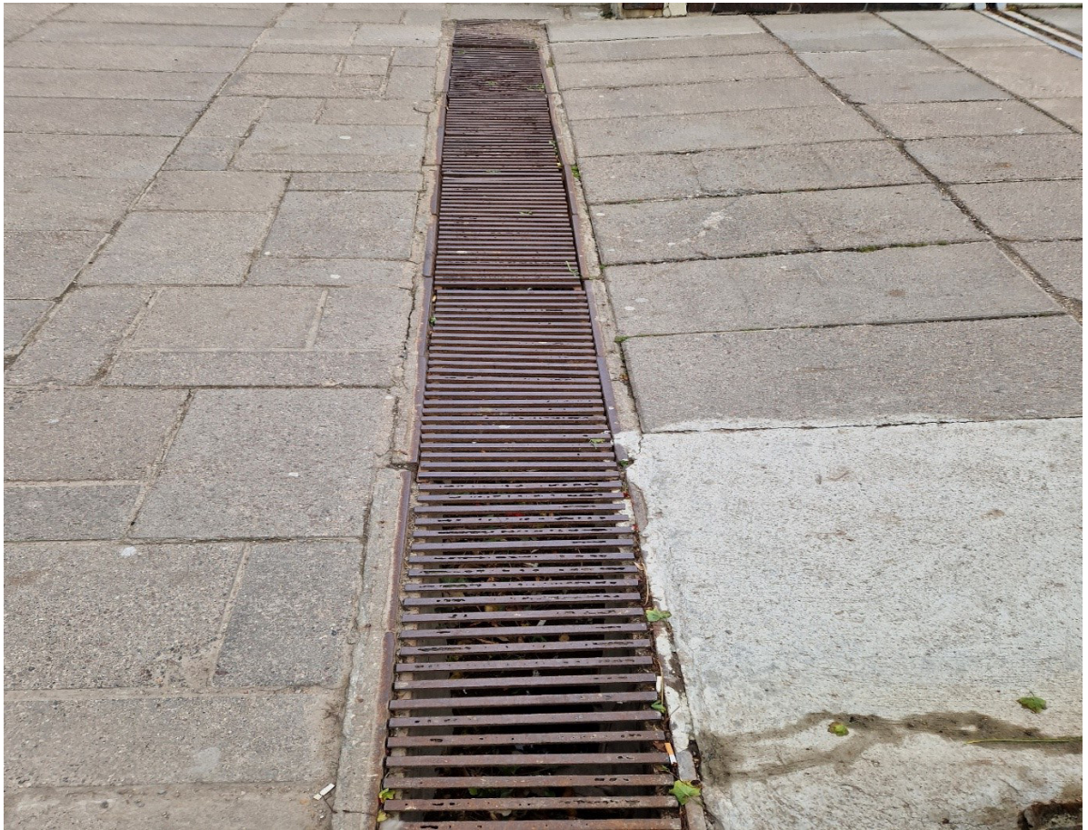
1.24 nuotrauka. Vandens nuvedimo latakas prietiltyje ties I atrama. Latakas užkimštas, jame pilna žemių ir lapų
