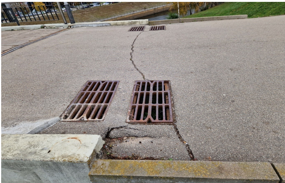
1.23 nuotrauka. Prietilčio dangoje, ties V atrama, atsivėręs skersinis plyšys, danga pasėdusi ir palūžinėjusi palei vandens surinkimo šulinius
