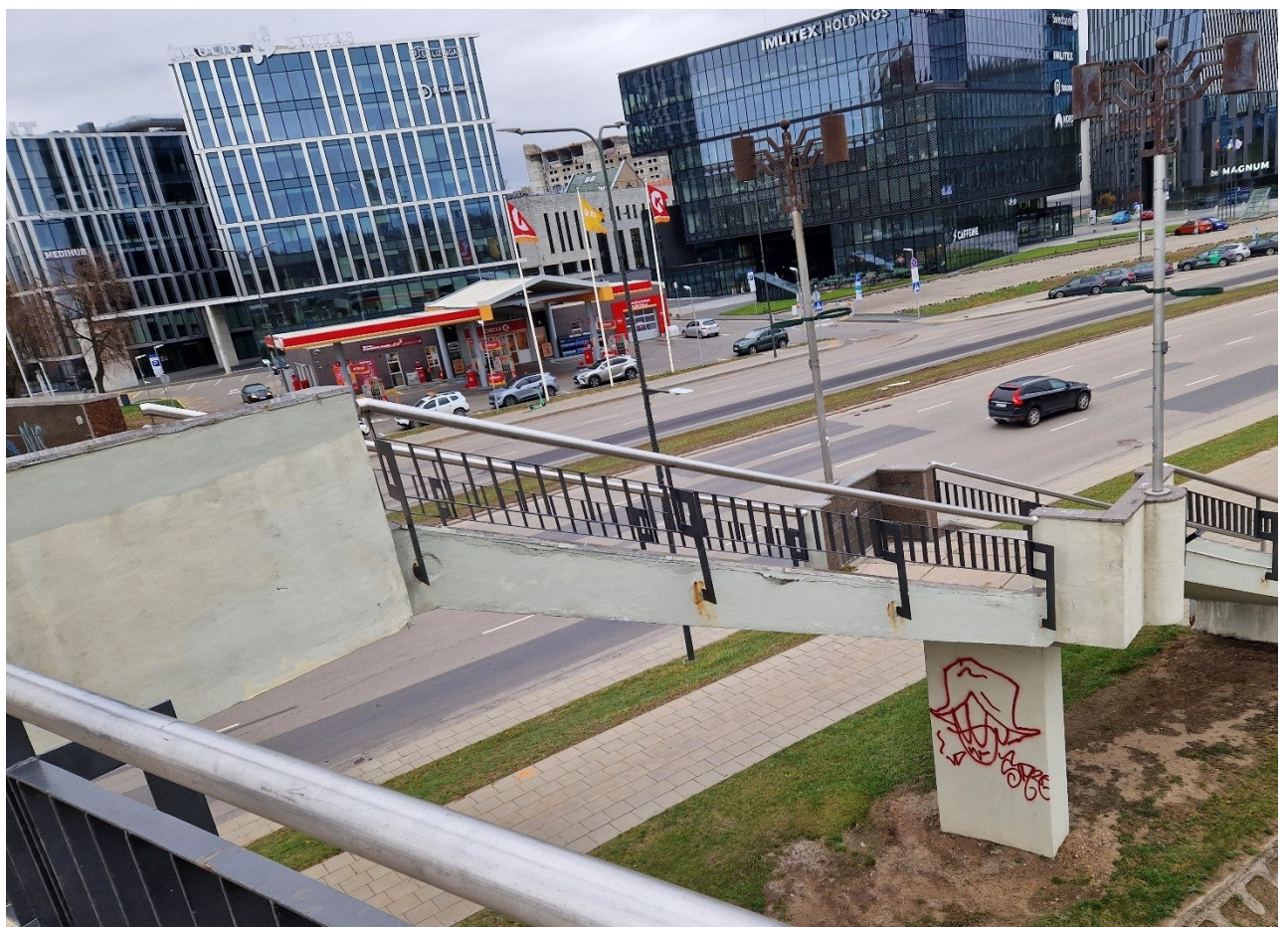
1.30 nuotrauka. Laiptų ties III atrama bendras vaizdas aukštupio pusėje. Laiptasijos šone, palei turėklų apačią, supleišėjusi ir atšokusi apsauginė danga
