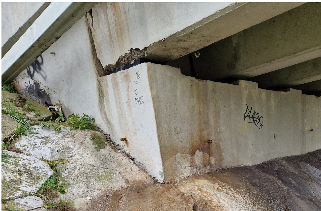
1.14 nuotrauka. Pirmos sijos bendras vaizdas virš V atramos. Sijos gale apie 50 cm atšokęs ir nukritęs apsauginis betono sluoksnis, koroduoja į paviršių išlindę pagalbinės armatūros strypai
