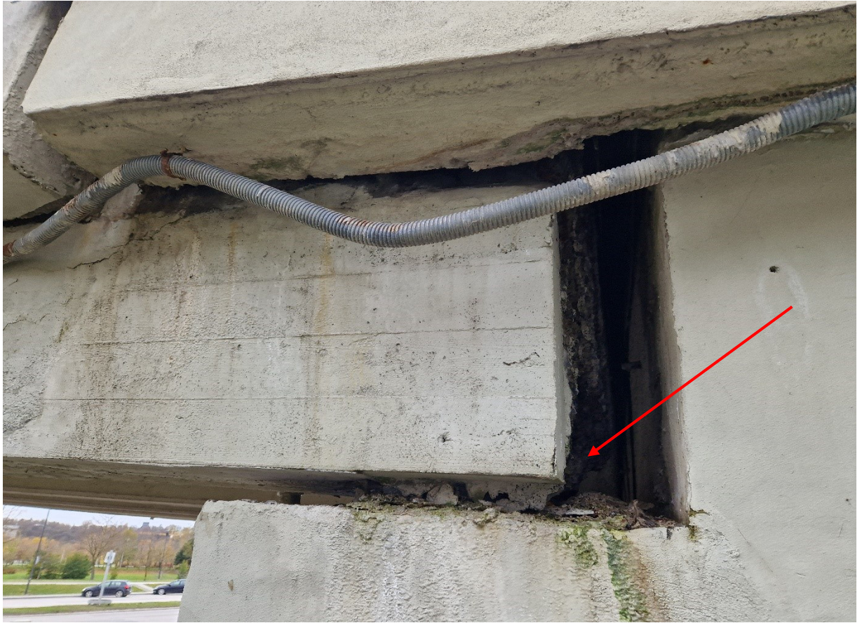
1.12 nuotrauka. Pirmos sijos galas virš I atramos žiūrint nuo aukštupio pusės. Sijos gale atšokęs ir nukritęs apsauginis betono sluoksnis, koroduoja į paviršių išlindę armatūros strypai
