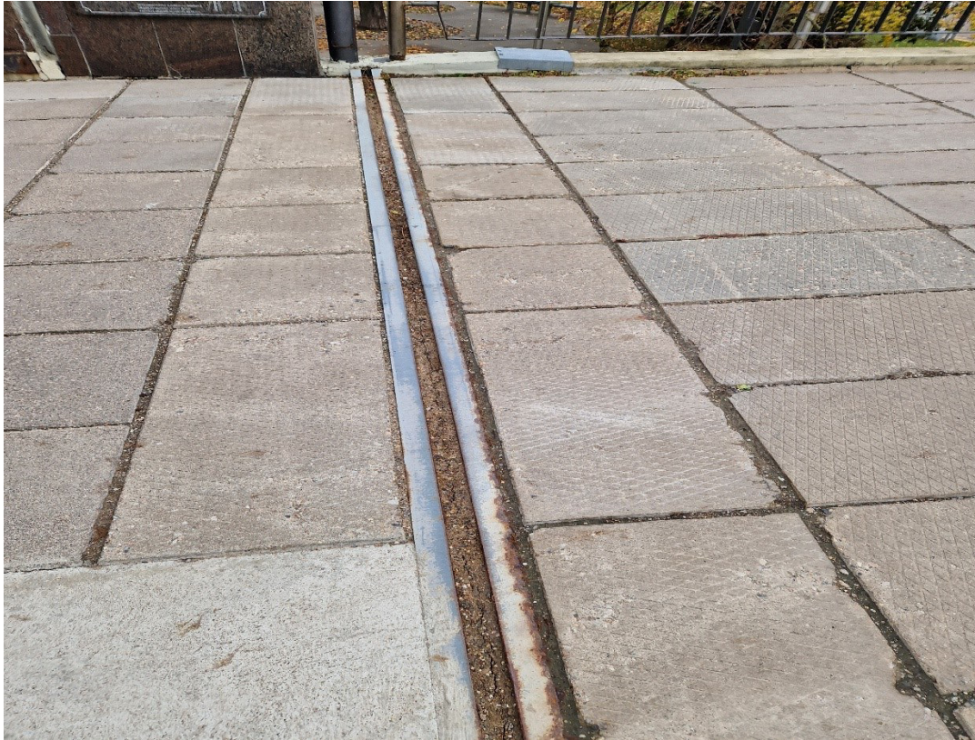
1.6 nuotrauka. Deformacinio pjūvio bendras vaizdas virš I atramos. Pjūvio tarpas prineštas žemių, dėl to suvaržytos statinio deformacijos išilgine kryptimi. Metaliniai profiliai pažeisti korozijos
