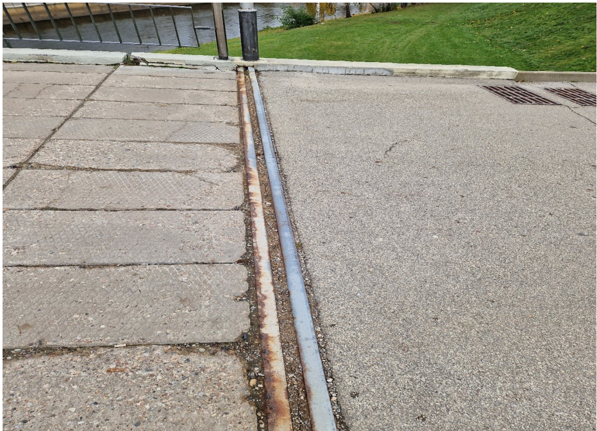
1.7 nuotrauka. Deformacinio pjūvio bendras vaizdas virš V atramos. Pjūvio tarpas prineštas žemių, dėl to suvaržytos statinio deformacijos išilgine kryptimi. Metaliniai profiliai pažeisti korozijos
