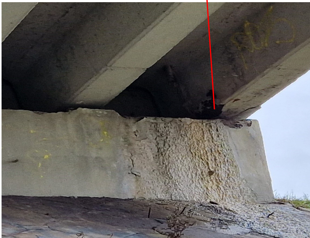
1.15 nuotrauka. Papleišėjęs ketvirtos sijos galas virš V atramos. Sijos gale atšokęs apsauginis betono sluoksnis, koroduoja į paviršių išlindę pagrindinės armatūros strypai
