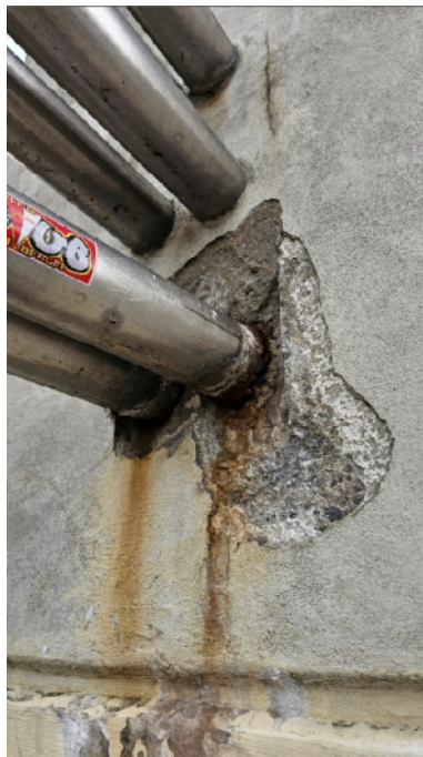
paveikslas 6 Apdailinių vamzdžių pilonuose tvirtinimo pažeidimai
