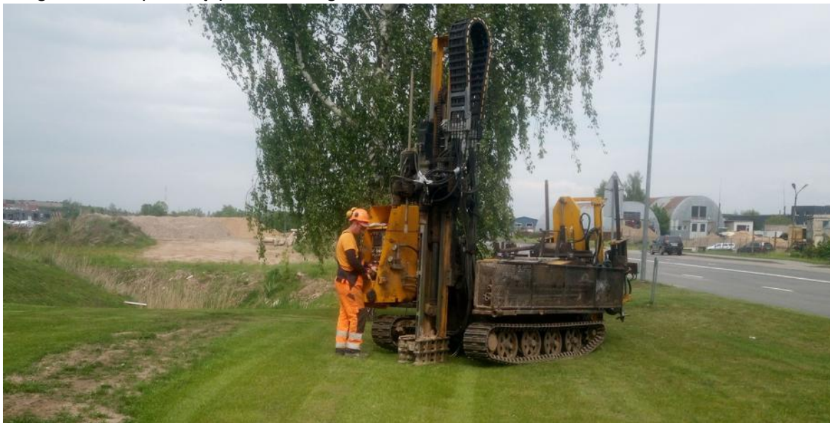
1 pav. Lauko darbai
