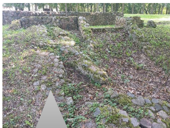
Nr. 05 Kritulių pažeistos ir sunykusios atraminės sienutės šalinamos
