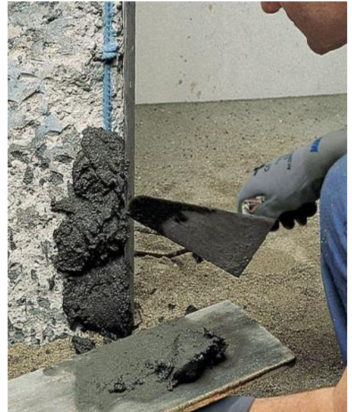
Pav. 3 Tiksotropinio remontinio mišinio MAPEGROUT T60 naudojimas
