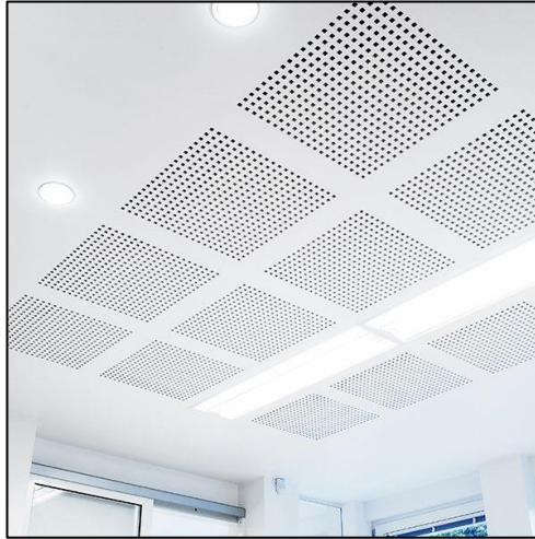
Pav. 18 Perforuotos g/k plokščių lubos
