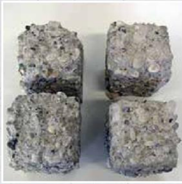
Pav. 5 Betoniniai pavyzdžiai po šildymo-šaldymo ciklų eapdorojus apsauginiu impregnantu.
