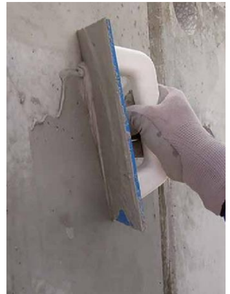
Pav. 4 Glaistymas naudojant PLANITOP FINE FINISH
