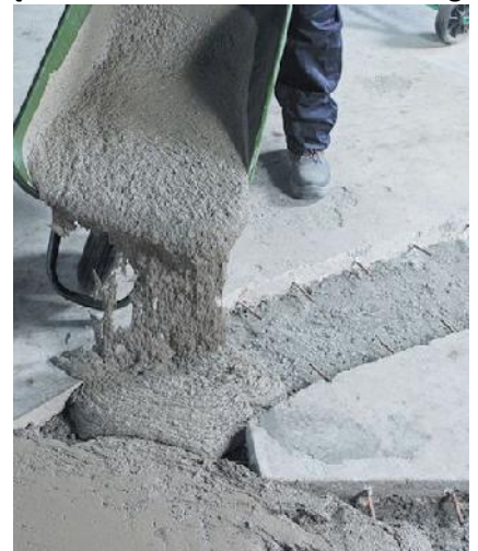
Pav. 2 Liejamo remontinio mišinio MAPEGROUT SV naudojimas
