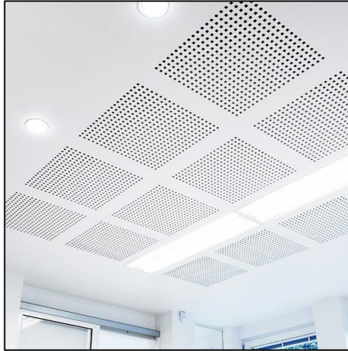
Pav. 18 Perforuotos g/k plokščių lubos
