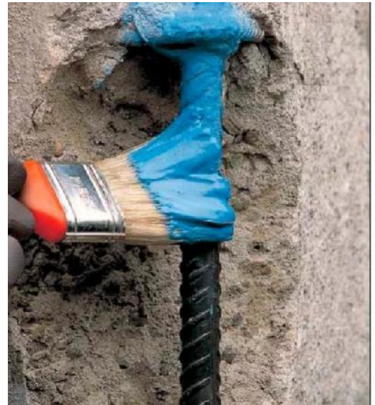
Pav. 1 MAPEFER 1K tepimas ant armatūros
