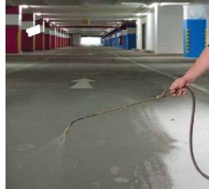
Pav. 7 Impregnanto Planiseal WR 100 dengimas aukšto slėgio beoriu purkštuvu
