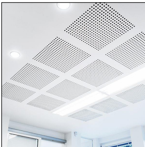
Pav. 18 Perforuotos g/k plokščių lubos
