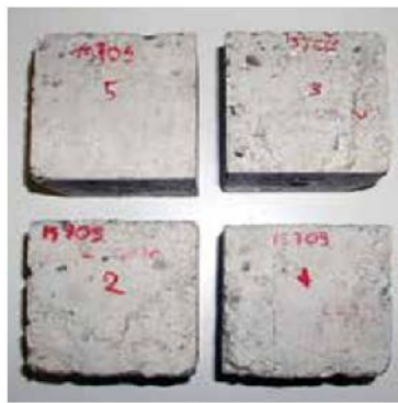
Pav. 6 Betoniniai pavyzdžiai po šildymo-šaldymo ciklų apdorojus apsauginiu impregnantu Planiseal
