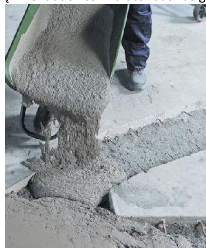
Pav. 2 Liejamo remontinio mišinio MAPEGROUT SV naudojimas
