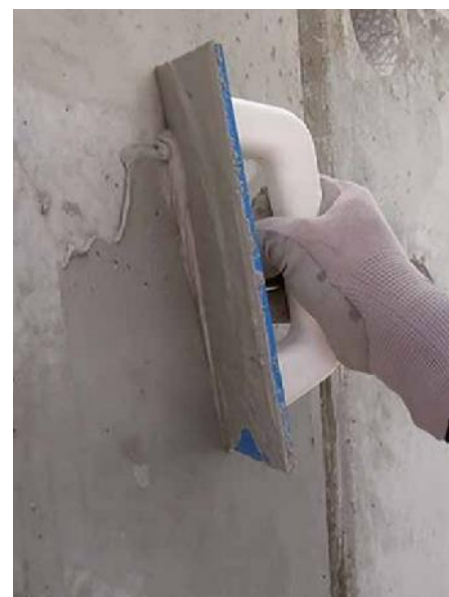
Pav. 4 Glaistymas naudojant PLANITOP FINE FINISH
