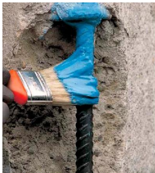
Pav. 1 MAPEFER 1K tepimas ant armatūros
