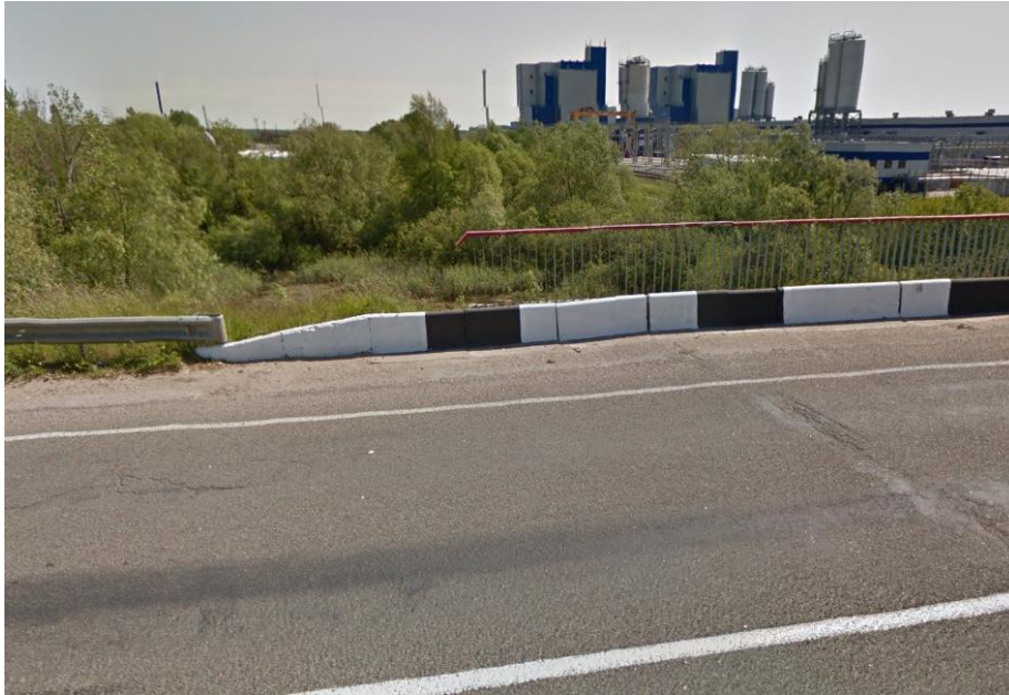
5.3.3. pav. Nedidelio vandens telkinio priartėjančio prie nagrinėjamo kelio ir šalio jo esančio miškelio vaizdas (kelio dešinė pusė)
