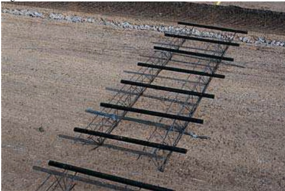
1. pav. Plieniniai sprausteliai užfiksuoti projektinėje padėtyje ties technologiniais deformaciniais pjūviais
