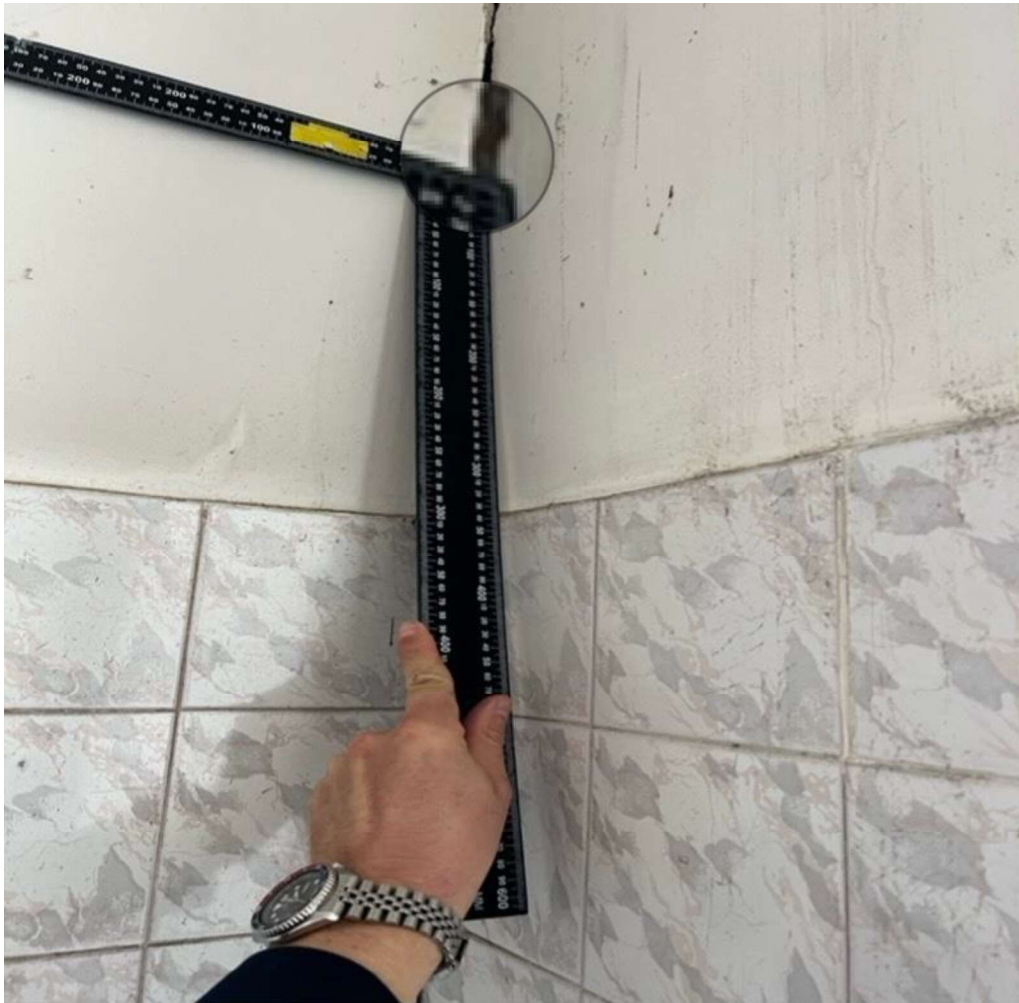
60 pav. Skilimas laikančių sienų kampe, 10 mm
