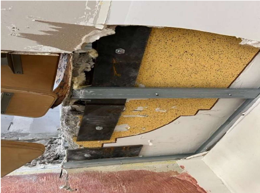
75 pav. Demontuota dalis perdangos plokštės
