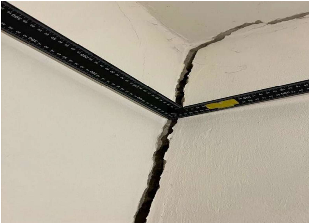
42 pav. Įtrūkio plotis 17 mm
