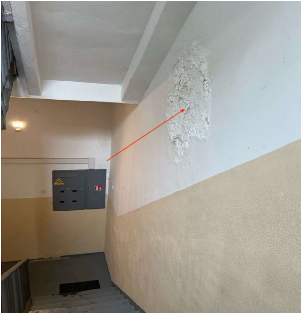
25 pav. Drėgmės paveikta siena bendrojo naudojimo laiptinės patalpoje
