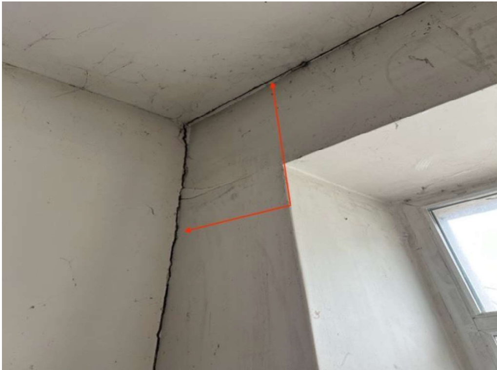
63 pav. Skilimas ties sienos bei lubų susikirtimo vieta. Plyšys laikančiųjų sienų kampe
