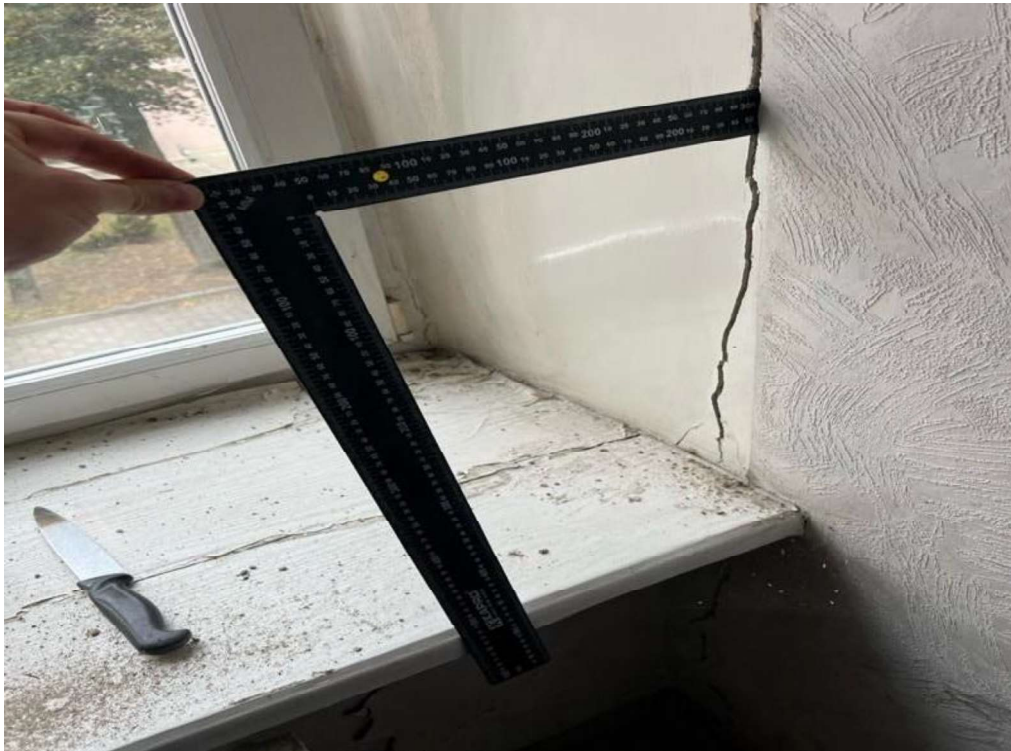
53 pav. Fiksuotas įtrūkio gylis 110 mm
