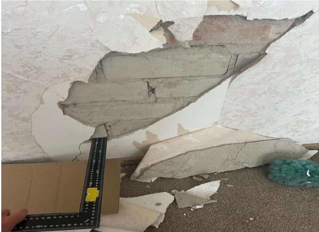
30 pav. Trūkiai, įtrūkio gylis 27 mm
