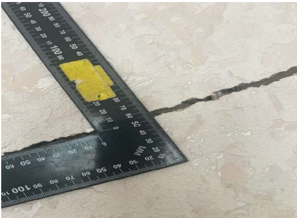
31 pav. Trūkiai, įtrūkio plotis 7 mm
