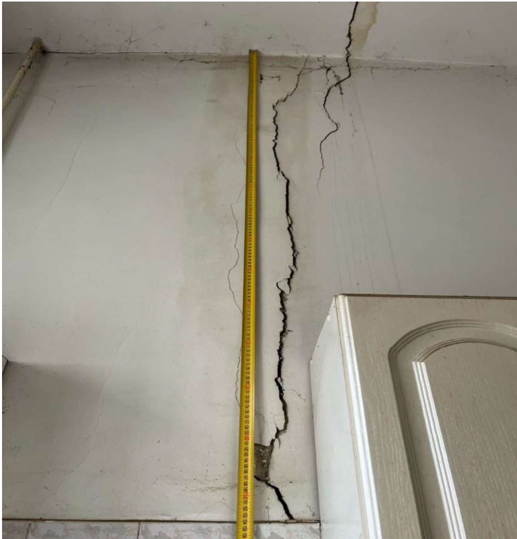
61 pav. Plyšys laikančiojoje sienoje, 154 cm
