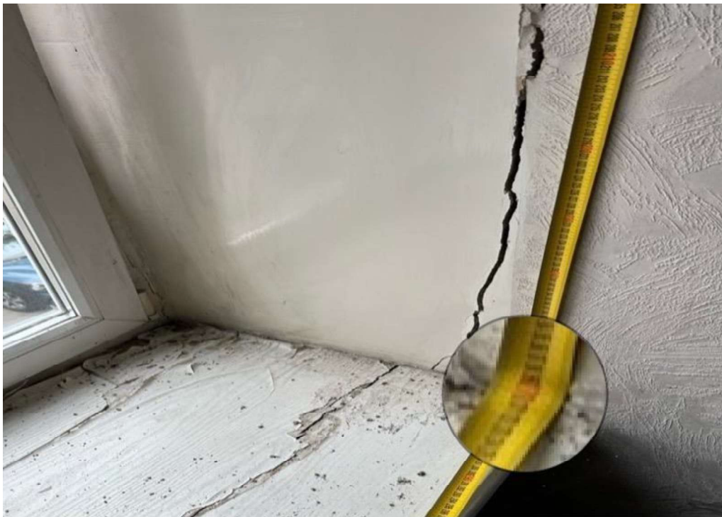
50 pav. Plyšys laikančiojoje sienoje, 270 cm
