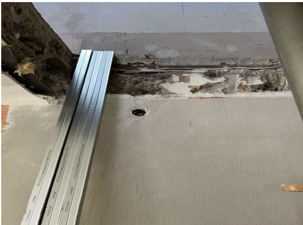
74 pav. Demontuota dalis perdangos plokštės
