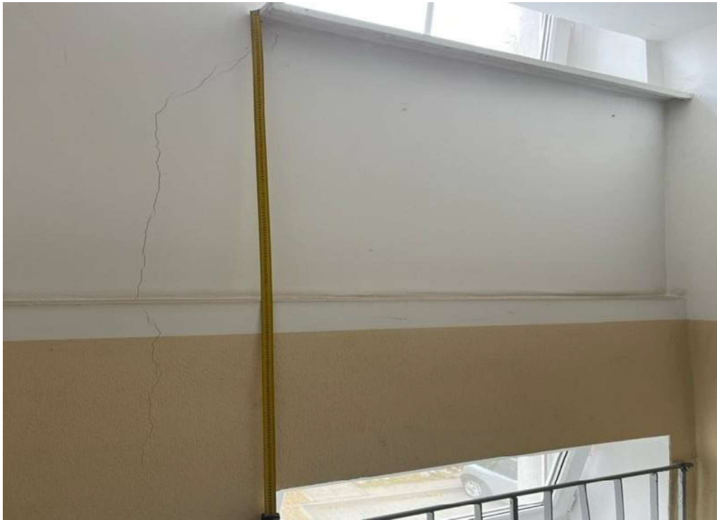
16 pav. Trūkis bendrojo naudojimo laiptinės laukančiojoje sienoje
