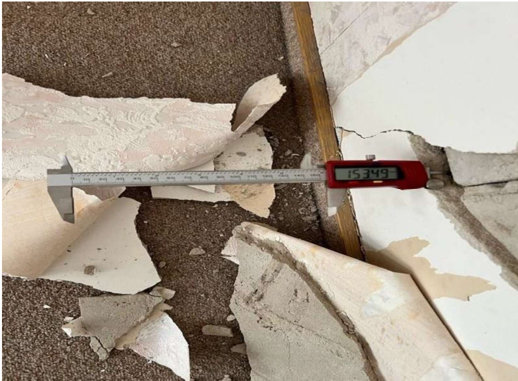
38 pav. Trūkiai ( skilimai ), fiksuotas įtrūkio gylis 153.49 mm
