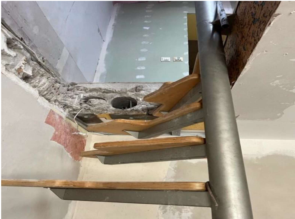
73 pav. Demontuota dalis perdangos plokštės
