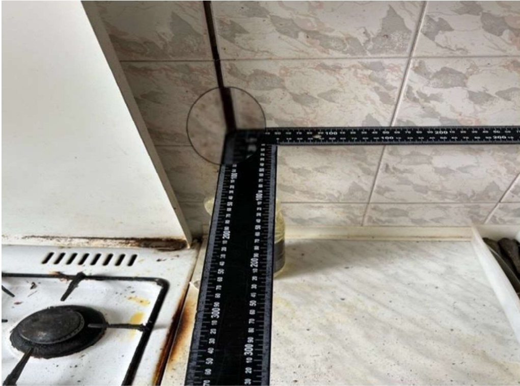
58 pav. 5 mm plyšys laikančiojoje sienoje
