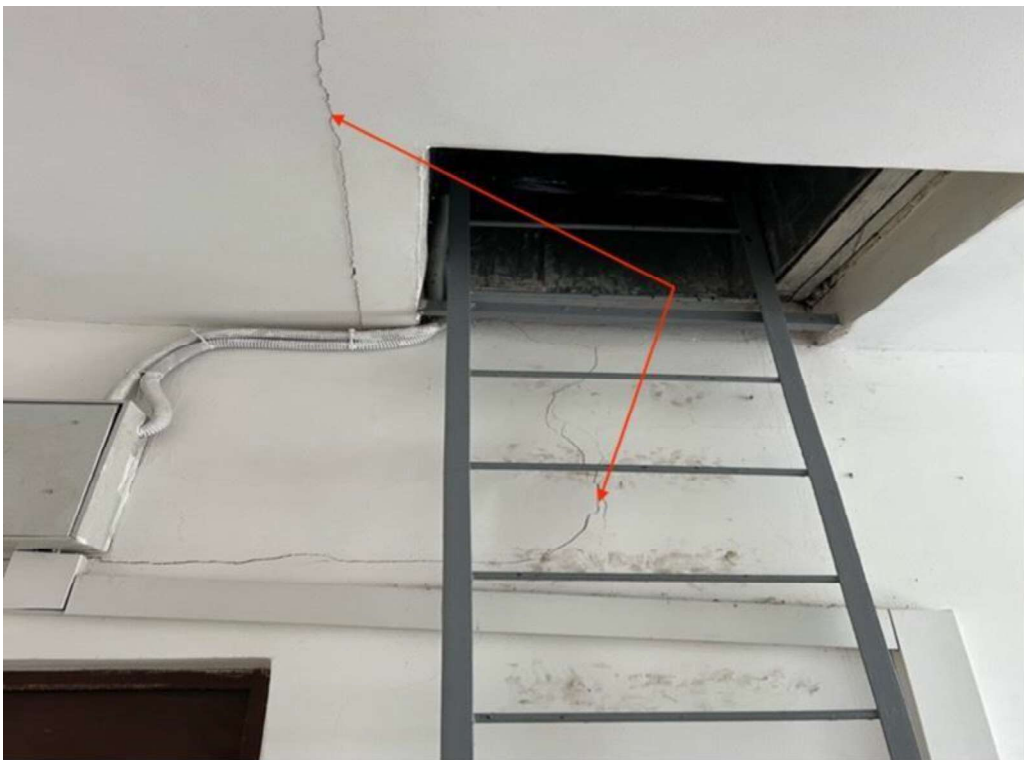
22 pav. Trūčiai ( skilimai ) ant sienos bei lubų
