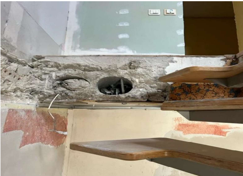
76 pav. Demontuota dalis perdangos plokštės
