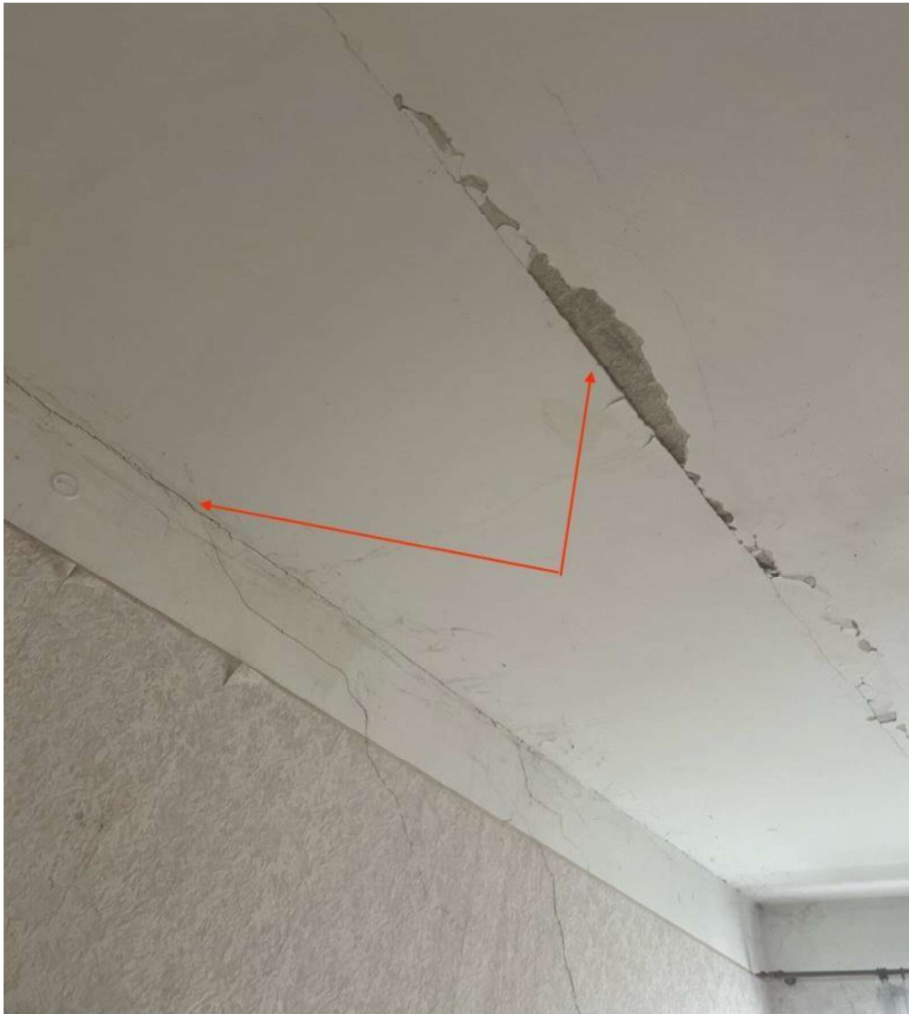
29 pav. Trūkiai ( skilimai ) ant lubų. Skilimas ties sienos bei lubų susikirtimo vieta
