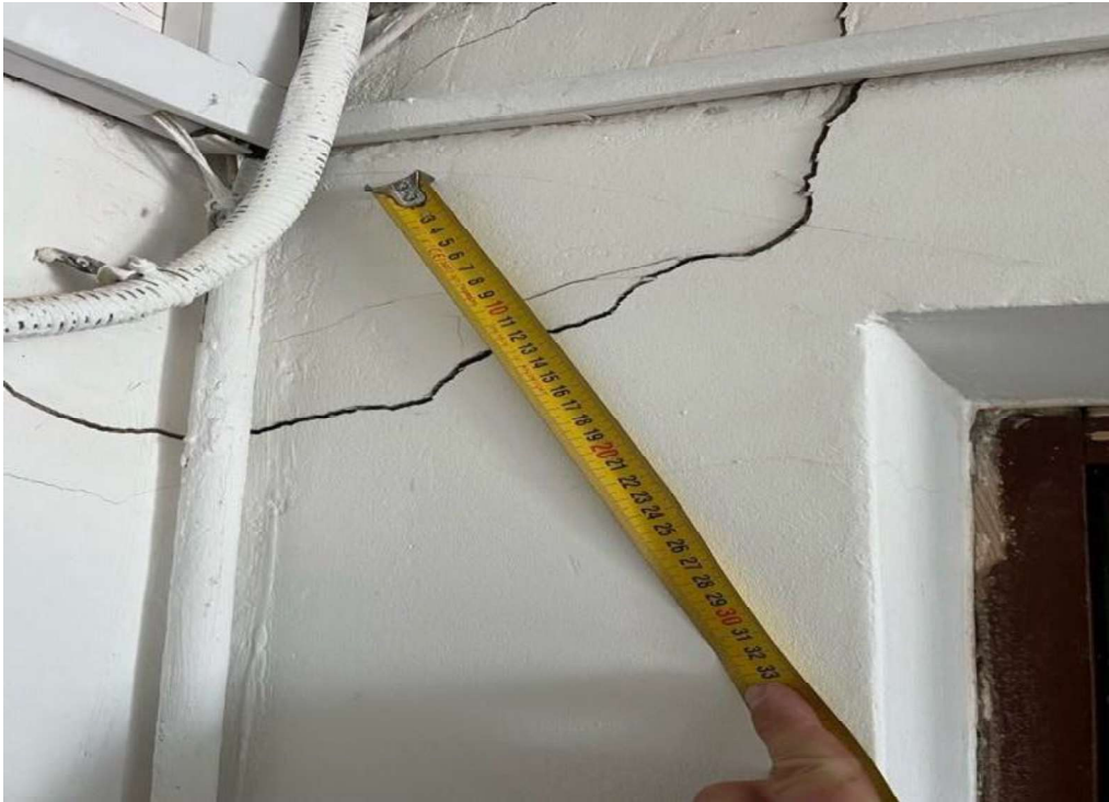
23 pav. 4 mm plyšys laikančiojoje sienoje
