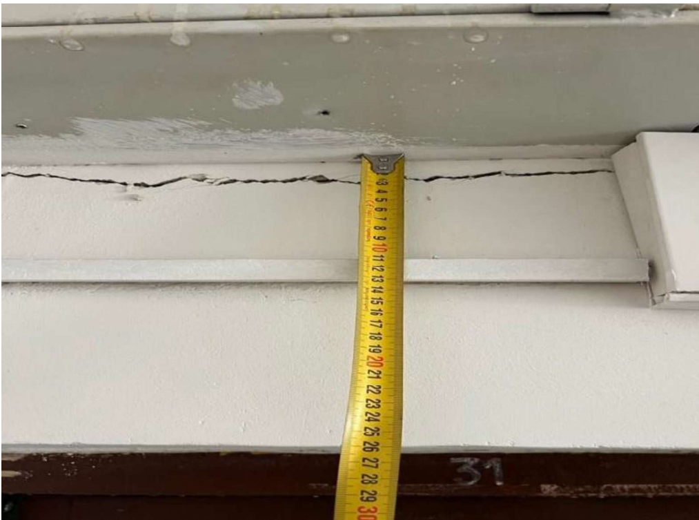
24 pav. 3 mm plyšys laikančiojoje sienoje
