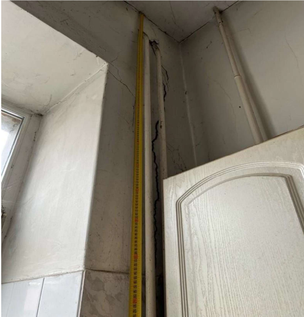
62 pav. Plyšys laikančiojoje sienoje, 154 cm
