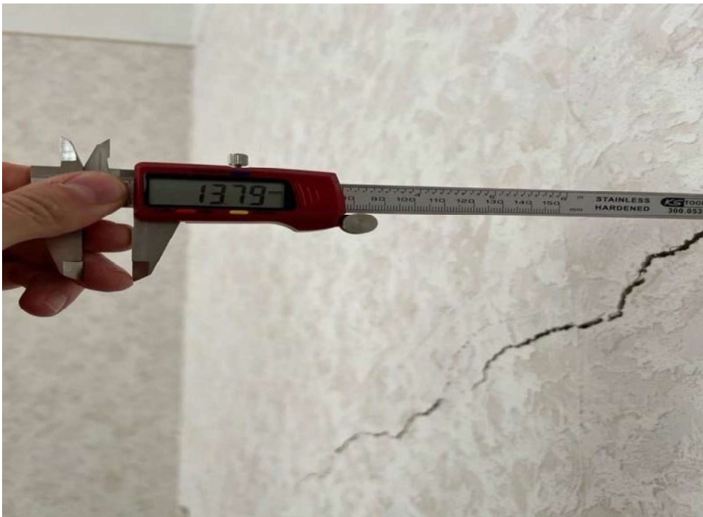
37 pav. Trūkliai ( skilimai ), fiksuotas įtrūkio gylis 13.79 mm
