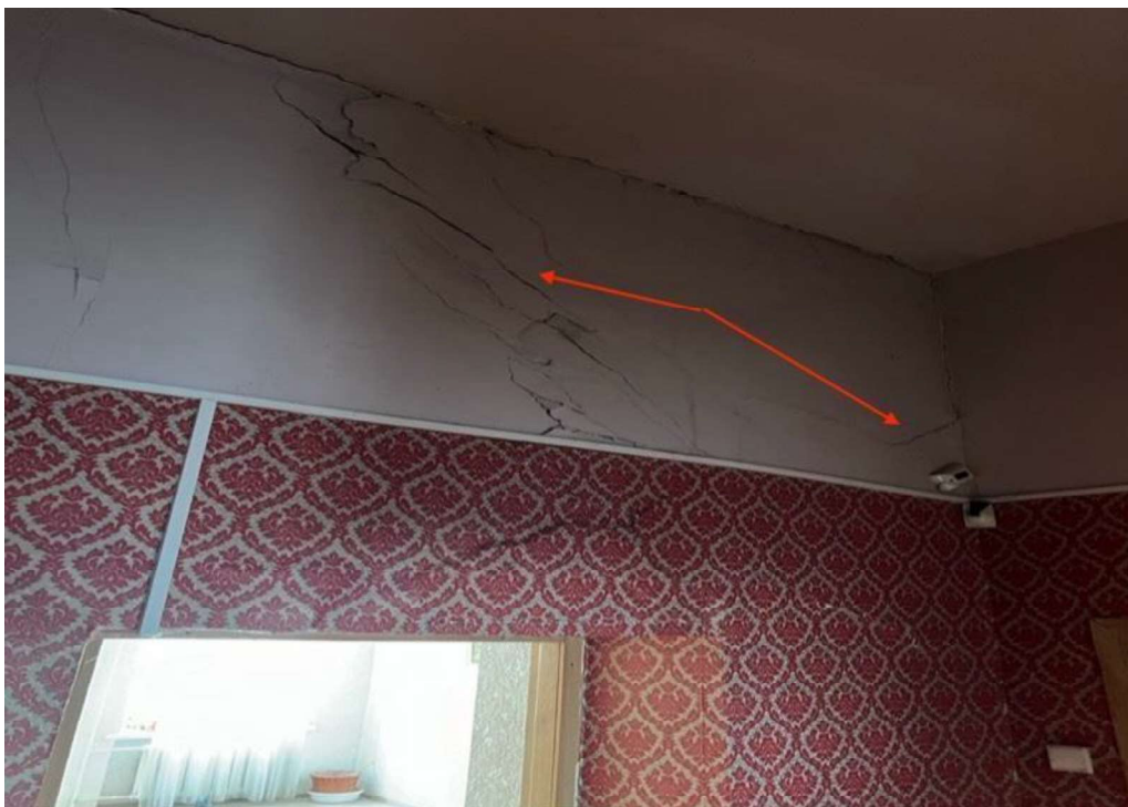
64 pav. Įstrižieji trūkiai laikančiojoje sienoje
