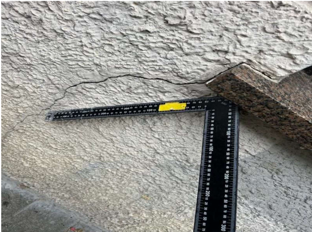
3 pav. Pastato fasado vaizdas iš Vilniaus g. pusės, matomi trūkiai ( skilimai )
