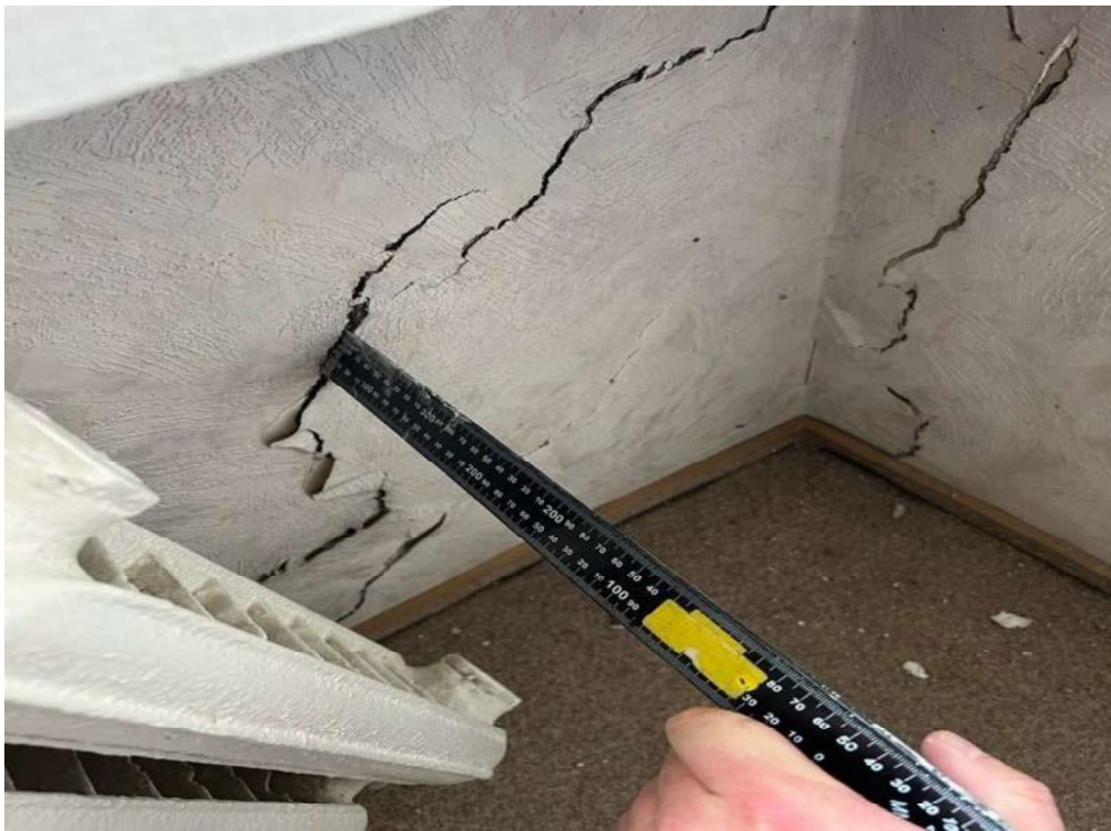
54 pav. Deformacija po langu. Fiksuotas įtrūkio gylis 70 mm
