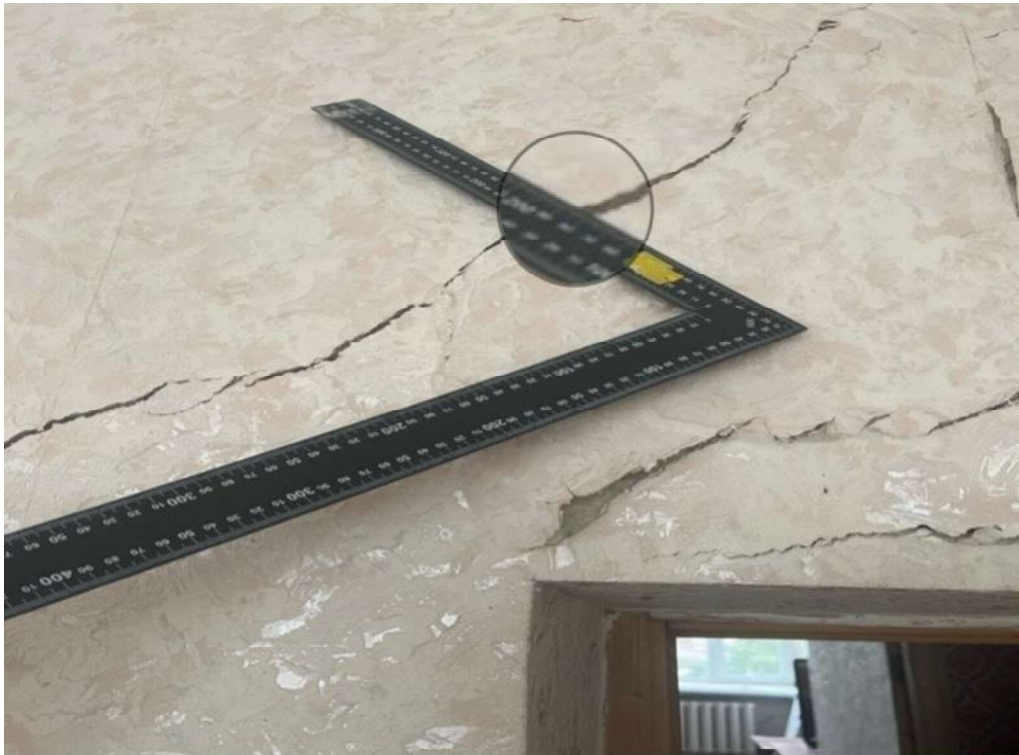
32 pav. Trūčiai, įtrūkio plotis 7 mm
