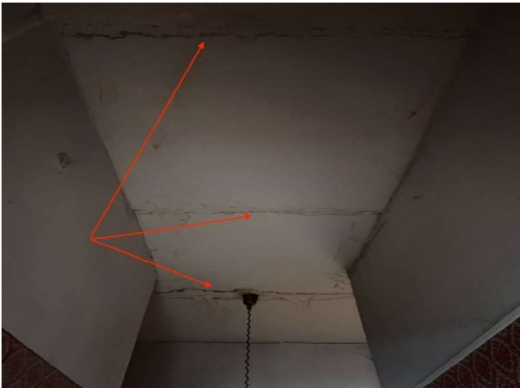
70 pav. Pastebėti daugybiniai perdangos defektai, trūkiai/skilimai
