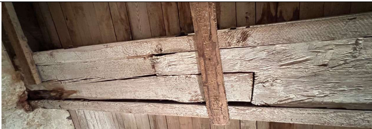
27 pav. Perdangos ištinės sijos pripjautos, sujungtos atitinkančio skerspjūvio sija ties siena, iš šonų sutvirtintos antdėklais
