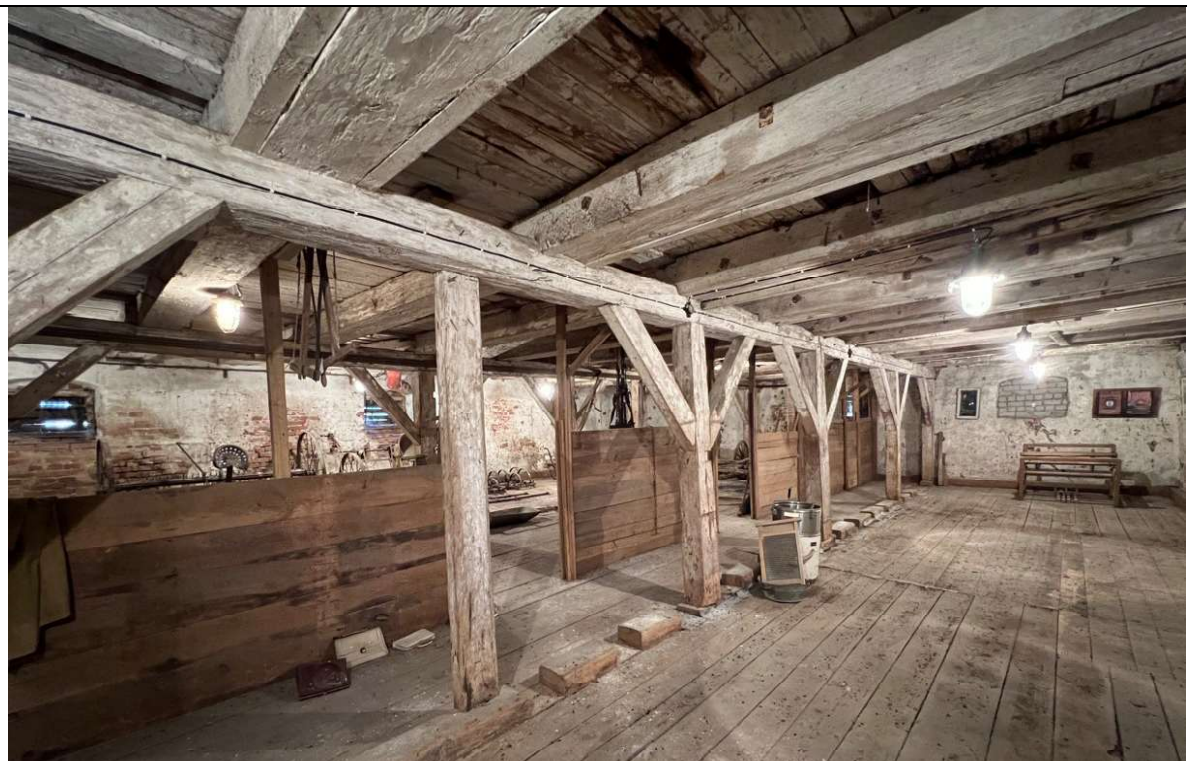
23 pav. Bendrasis pirmo aukšto patalpų vaizdas. Masyvios kolonos su spyriais ir tarpinės kolonos be spyrių, kurių dalis neišlikusi.
