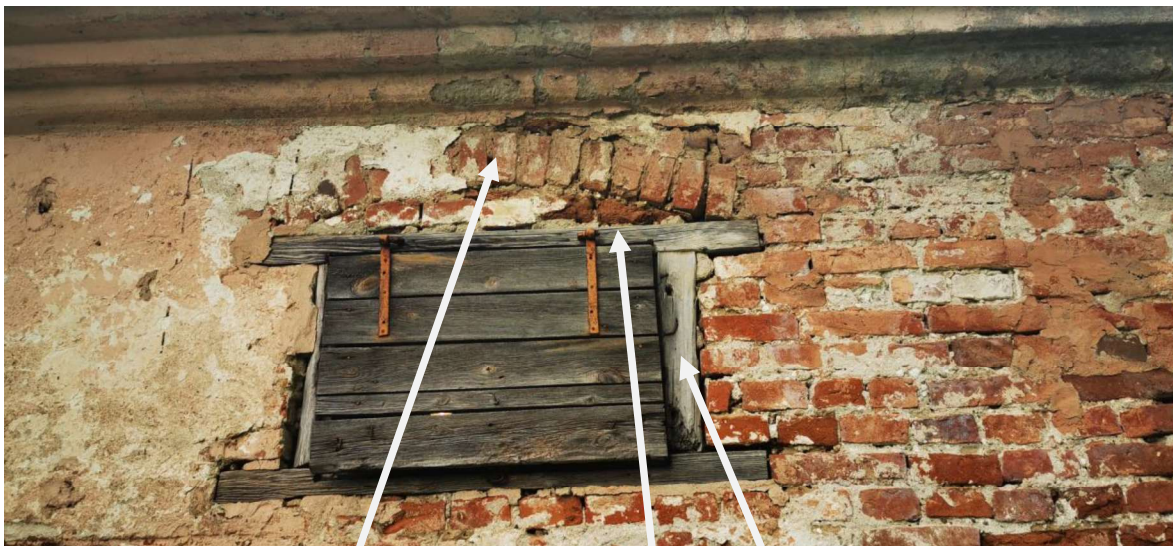
Autentiška segmentinė sąrama XXa. įrengta medinė sąrama ir staktą Užpildas tarp sąramų iš senų plytų nuolaužų, skiedinys su cemento priemaišomis
