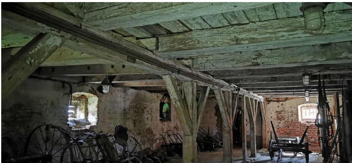
Pirmas aukštas, XVIIIa. sijų – kolonų konstrukcija
