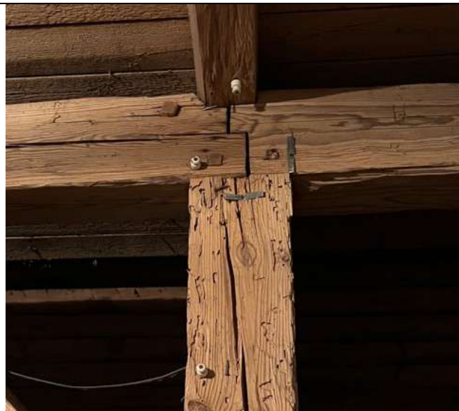
29 pav. Ištinės sijos jungimo mazgas virš pirmo lygio pastogės kolonos
