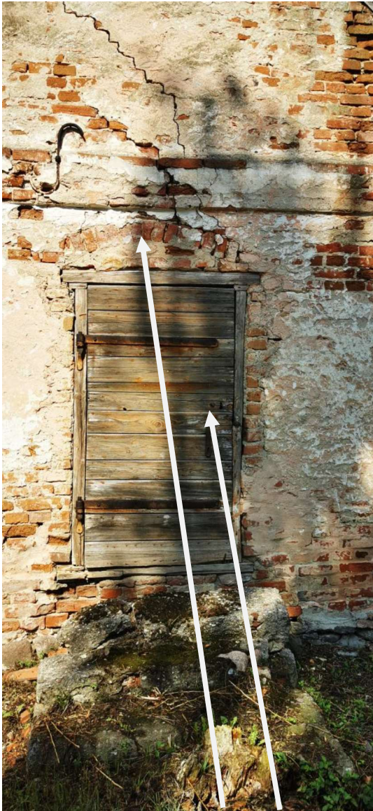
Autentiška segmentinė sąrama, durys įrengtos XXa.
