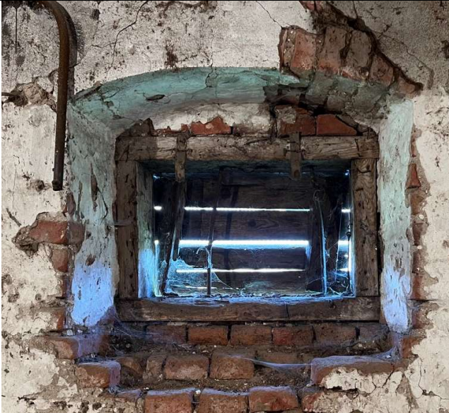
35 pav. Pirmo aukšto patalpų arkinė sąrama ties patalpos vidumi, ties išore įstatytas stačiakampis angos rėmas
