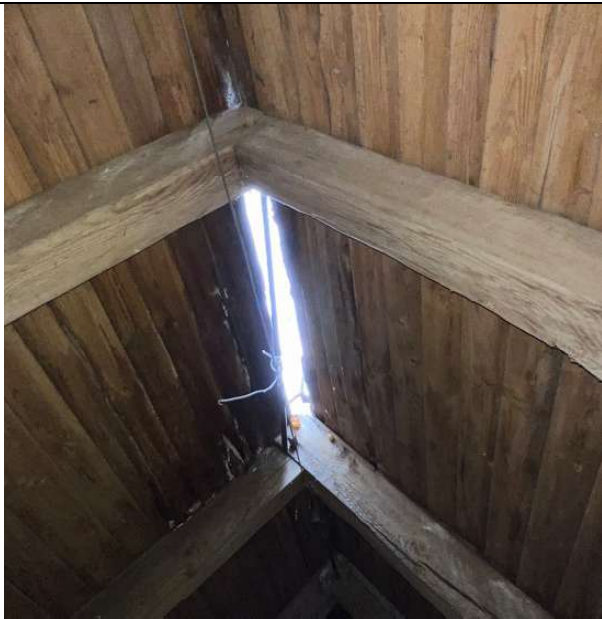
33 pav. Sunykusi kraigo apsauga, lentų paklotas ir gegnių galai veikiami drėgmės
