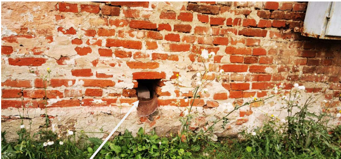
Angos pogrindžio vėdinimui išdėstytos lygiais intervalais ilguosiuose fasaduose
