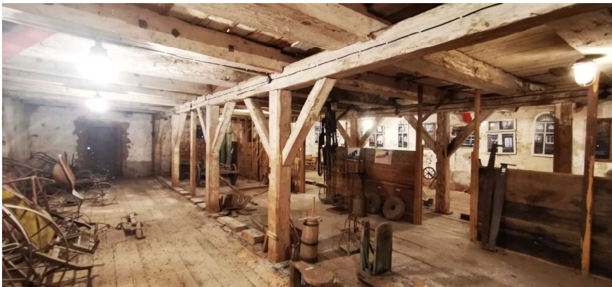
Autentiška medinė sijų kolonų konstrukcija pirmame aukšte
