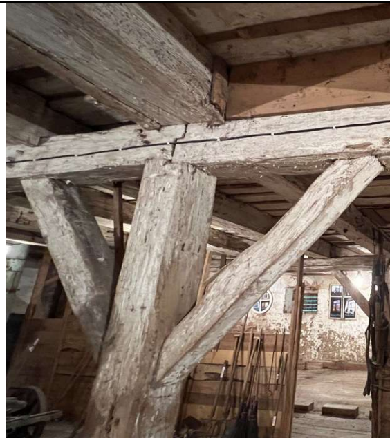
24 pav. Pirmo aukšto išilginės sijos jungimas virš kolonos su spyriais
