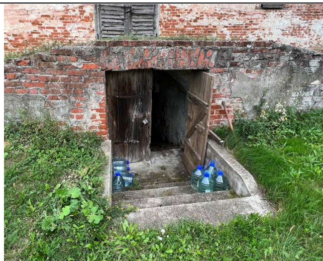
13 pav. Įėjimas į rūšio patalpas, pleištinė įėjimo sąrama
