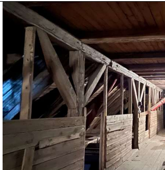
28 pav. Pirmo lygio pastogės kolonos su spyriais ir ištinė sija virš jų
