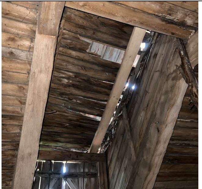
34 pav. Stogelių elementai paveikti atmosferinių kritulių
