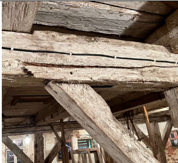
25 pav. Pirmo aukšto išilginė sija patręšusi, skilusi mediena
