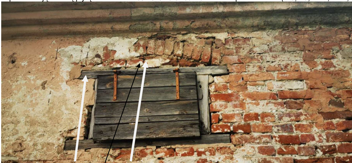
XXa. medinė sąramą XXa. užpildas tarp autentiškos segmentinė sąramos ir medinės sąramos
