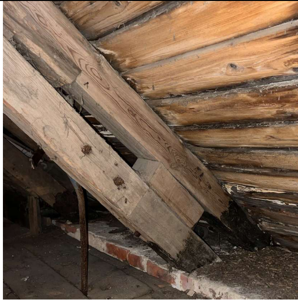
31 pav. Gegnės sujungtos su antgegnėmis virš ištinisų lauko sienų
