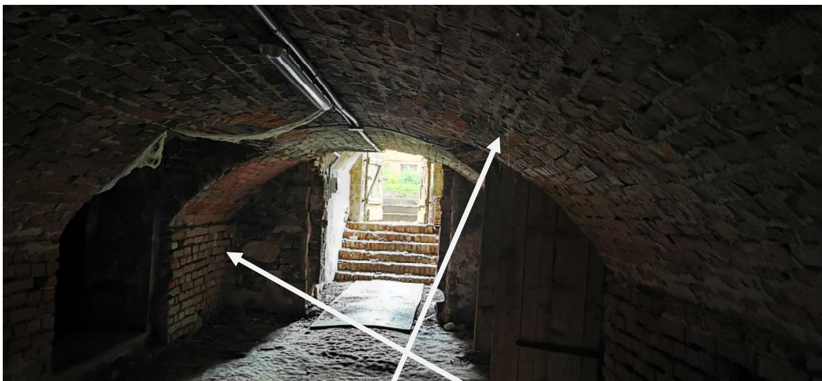
lėjimas į rūsų, autentiškas skliautinis perdenginys, plytų mūro sienos
