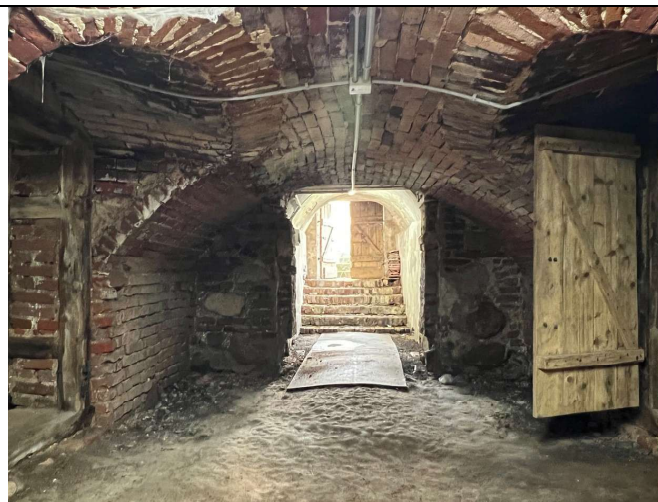
11 pav. Išplatinta anga ties centru išėjimu, sumontuotos naujos surenkamos sąramos
