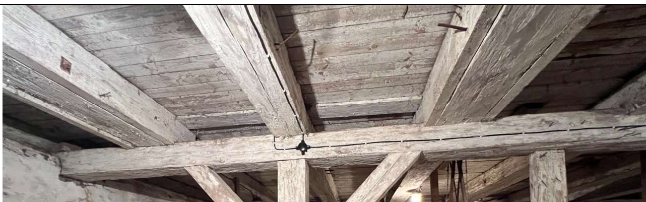
26 pav. Masyvios skersinės vientisos perdangos sijos. Kairiau ir dešiniau matomi stirpinimai antdėklais, vidurinė sija be papildomų antdėklų
