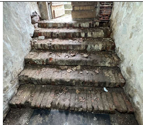
12 pav. Molio plytų rūšio laiptai iš patalpos pusės
