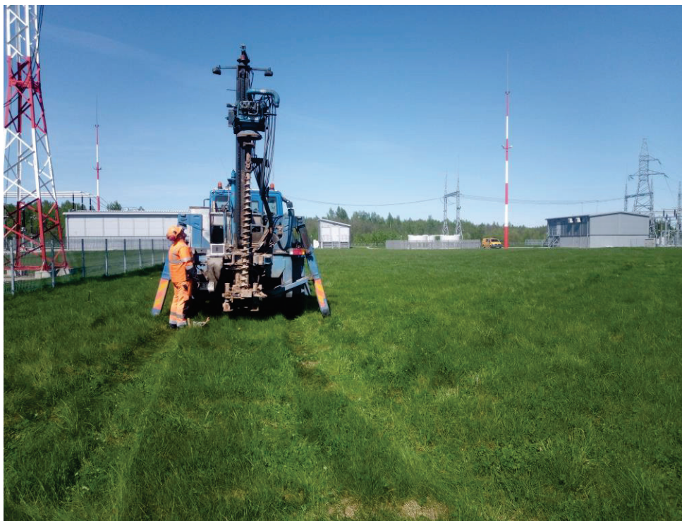
1 pav. Lauko darbai
