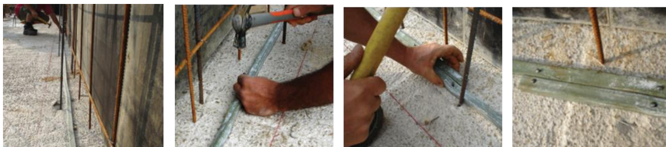
5.4 Paveikslas. Principinė siūlių sandarinimo įrengimo schema
