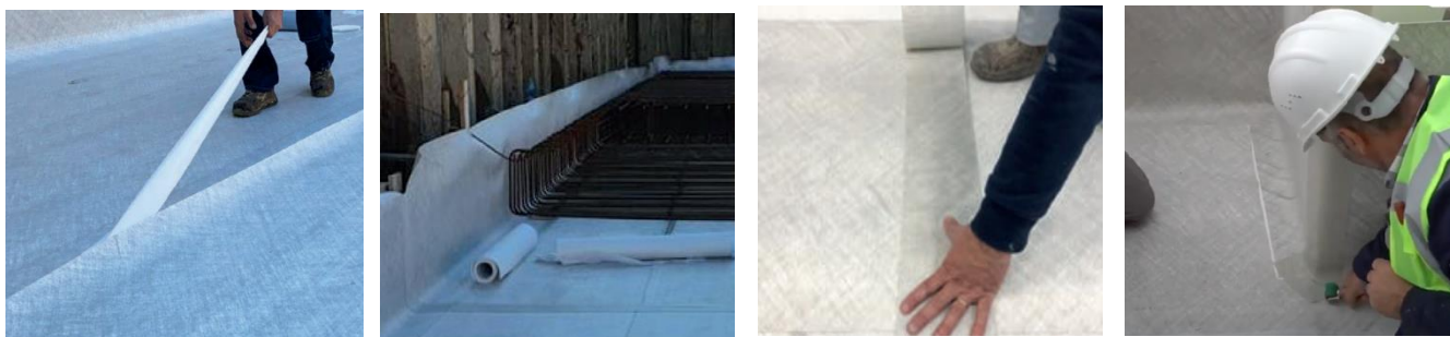
5.2 Paveikslas. Principinė membranos įrengimo schema
