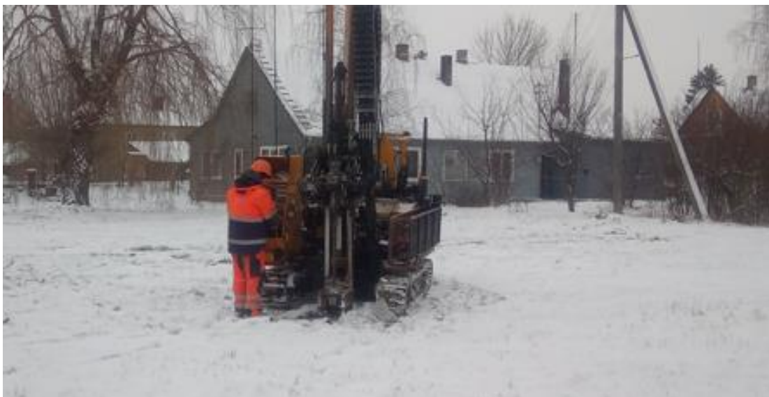
1 pav. Lauko darbai
