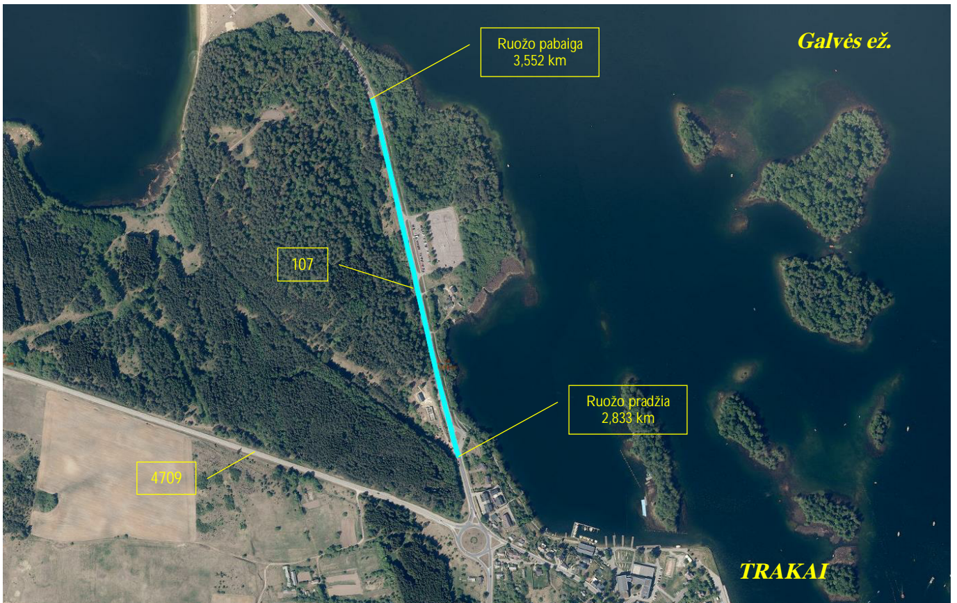
1 pav. Remontuojamo statinio vieta.
