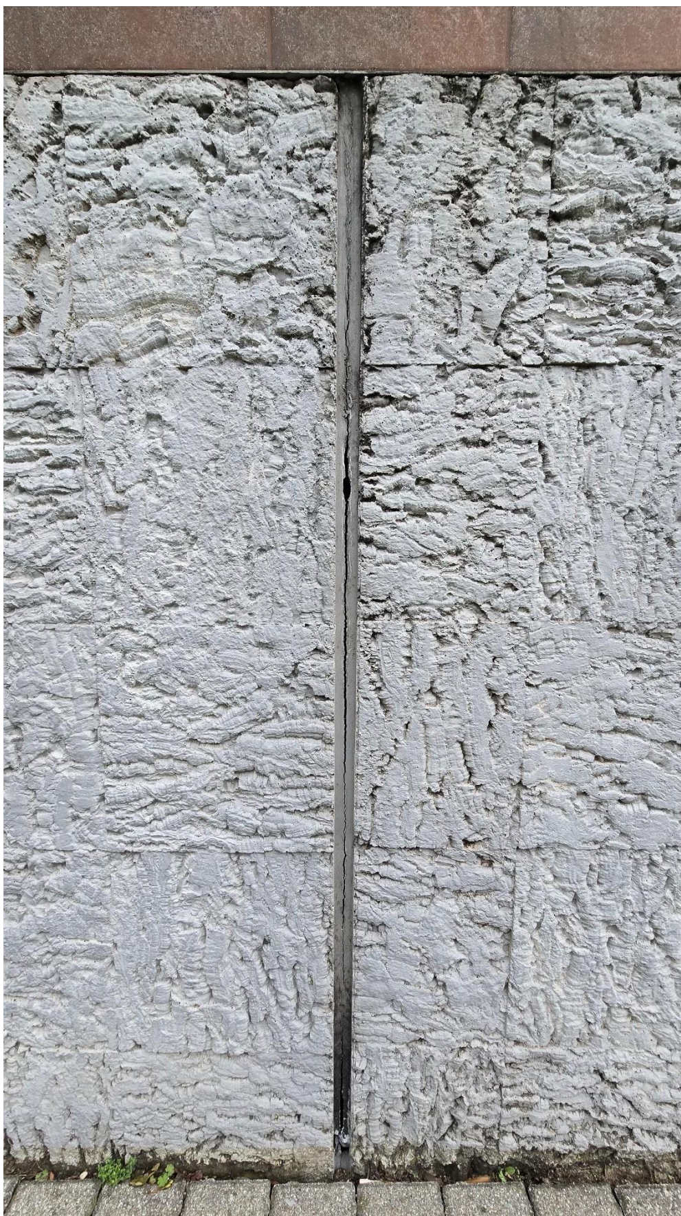
Nuotrauka Nr. 42 RECKLI plokščių sandūrose, užpildytose hermetiku, matomi trūkiai, krituliai patenka į sandūrą
