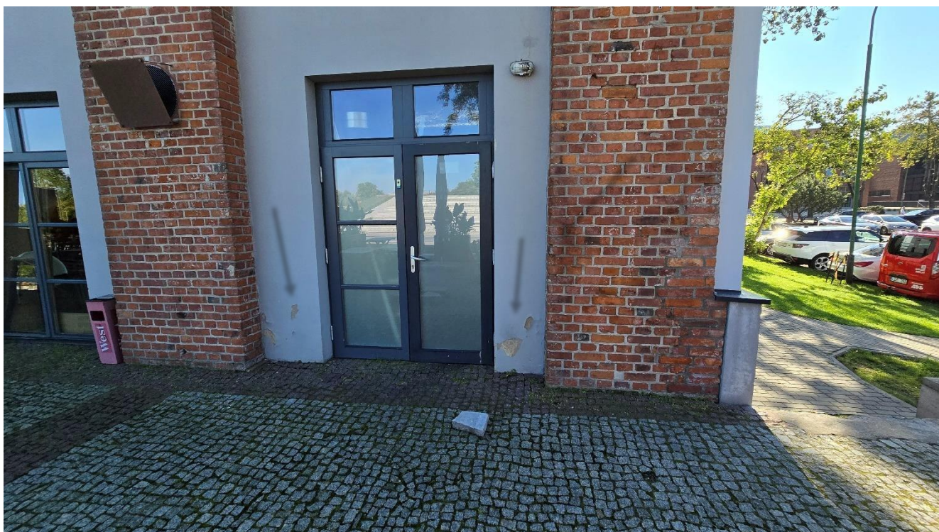
Nuotrauka Nr. 51 Fasade tarp ašių J-A/1 matomi nuo drėgmės ir šalčio poveikio atsokę dažai, keraminių molio plytų ir mūro siūlių pažaidos (žr. rodykles)
