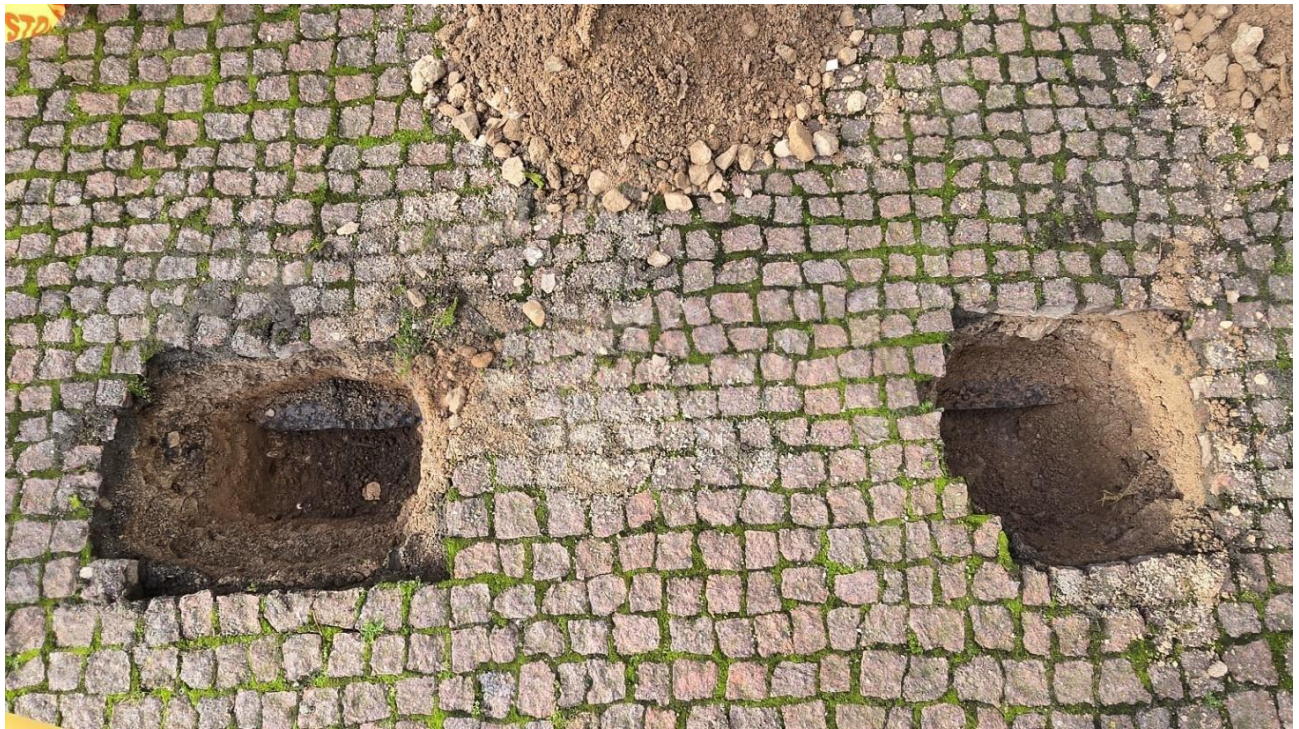
Nuotrauka Nr. 12 Siekiant nustatyti koku būdu krituliai patenka iš lauko į rūsio patalpų vidų, buvo atidengtos eksploatuojamo stogo grindinio konstrukcijos dalys iš išorės ties plieniniais atitvarų stulpeliais. Matoma rūsio perdangos ir sienos pabaiga ašyje H/2-3
