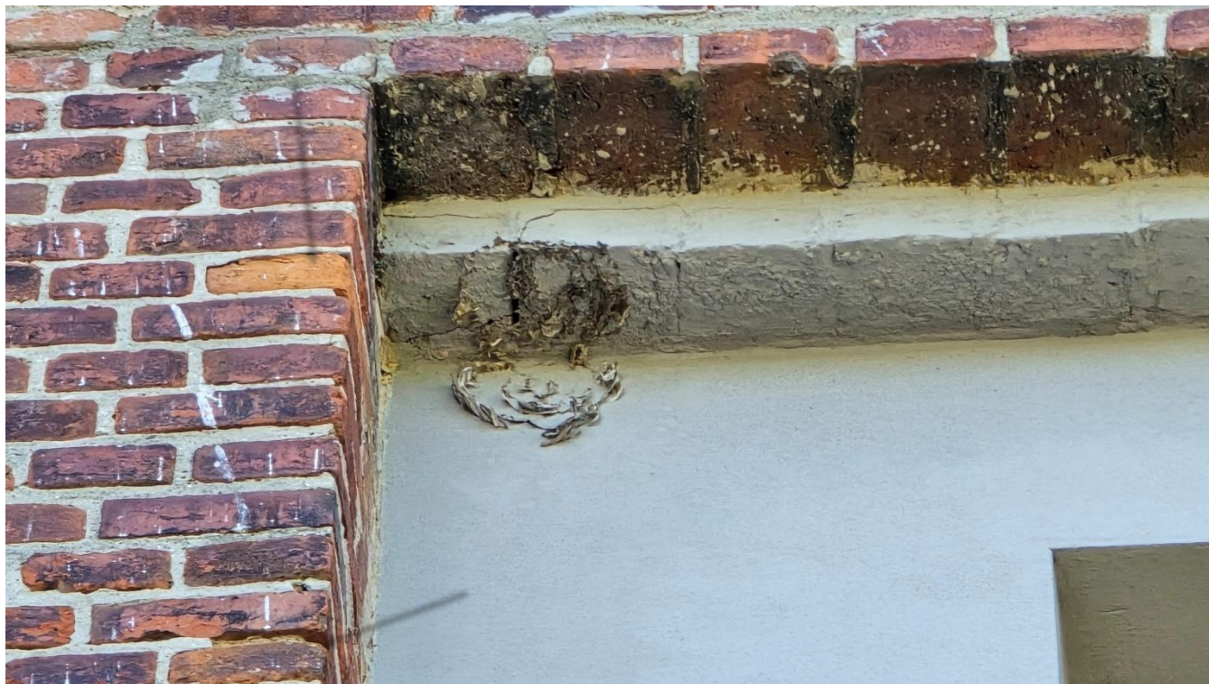
Nuotrauka Nr. 52 Nuo drėgmės ir šalčio poveikio atsiradusios keraminių molio plytų ir mūro siūlių pažaidos, ištrupėjimai (žr. žymėjimą rodyklėmis)
