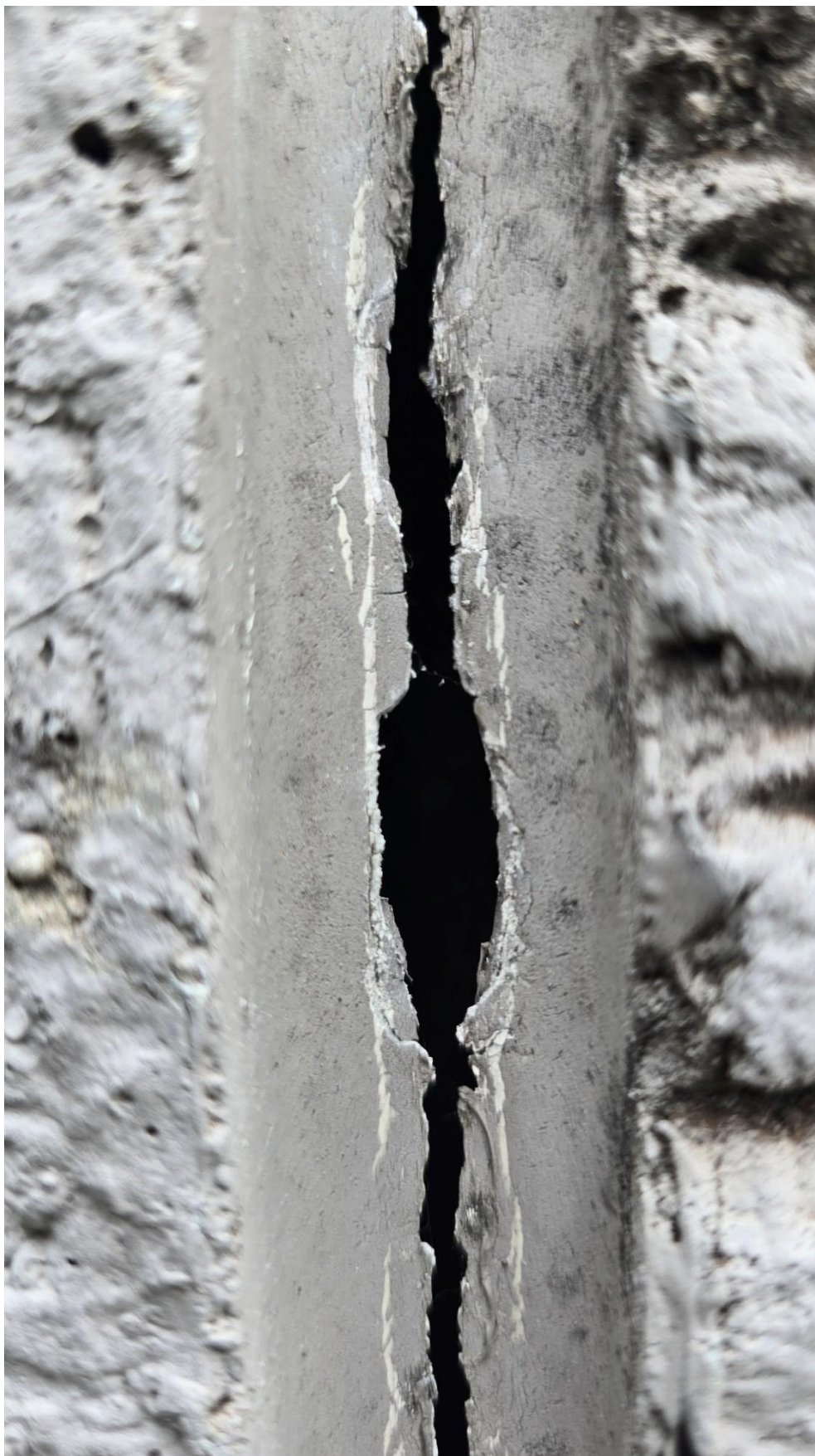
Nuotrauka Nr. 43 RECKLI plokščių sandūrose, užpildytose hermetiku, matomi trūkiai, krituliai patenka į sandūrą
