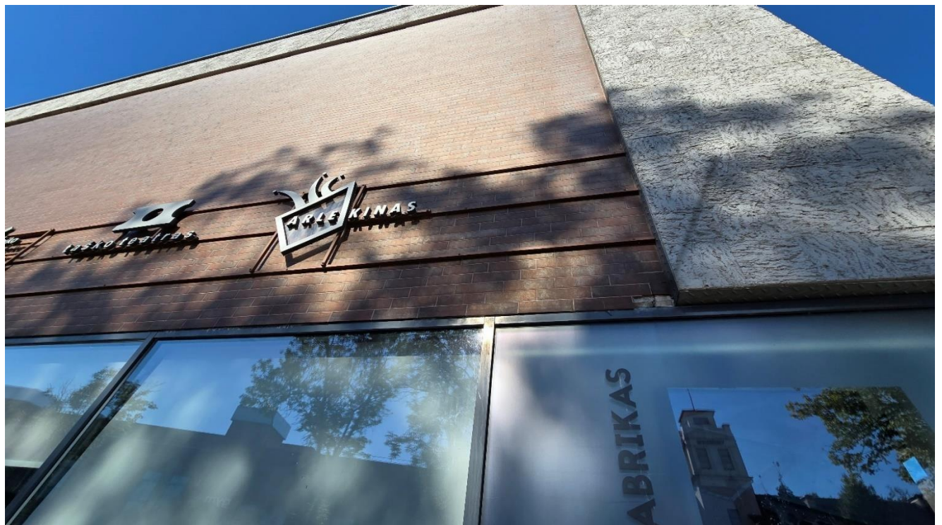
Nuotrauka Nr. 28 Paspaudus ranka šiltinamasis sluoksnis su klinkerio plytelėmis juda, nėra stabilus, į sandūrą tarp aliuminio vitrinų rėmo ir akmens vatos šiltinamojo sluoksnio patenka krituliai, gavusi drėgmės akmens vata išbrinko bei vietomis atšoko klinkerio plytelių apdaila (žr. rodyklę)
