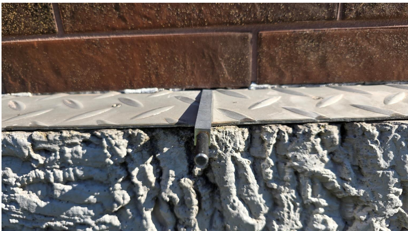
Nuotrauka Nr. 39 Apdailinė aliuminio juosta atšokusi nuo RECKLI plokščių paviršiaus visu ilgiu. Apdailinė aliuminio juosta privalėjo būti atbortuota, skardinės palangės tipo, sujungta su armavimo tinkleliu kad užtikrinti sandūros sandarumą. Neįrengti ventiliacijos vamzdeliai Ø12 mm ties RECKLI plokštėmis
