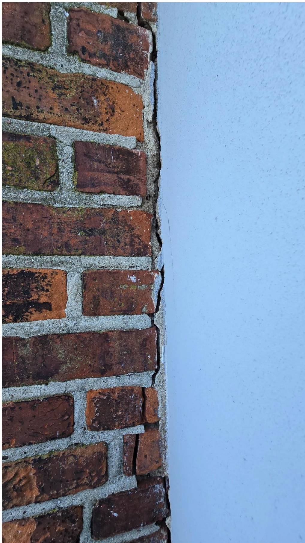
Nuotrauka Nr. 61 Vertikalus 4-5 mm pločio trūkis mūre ašyje J-I/1
