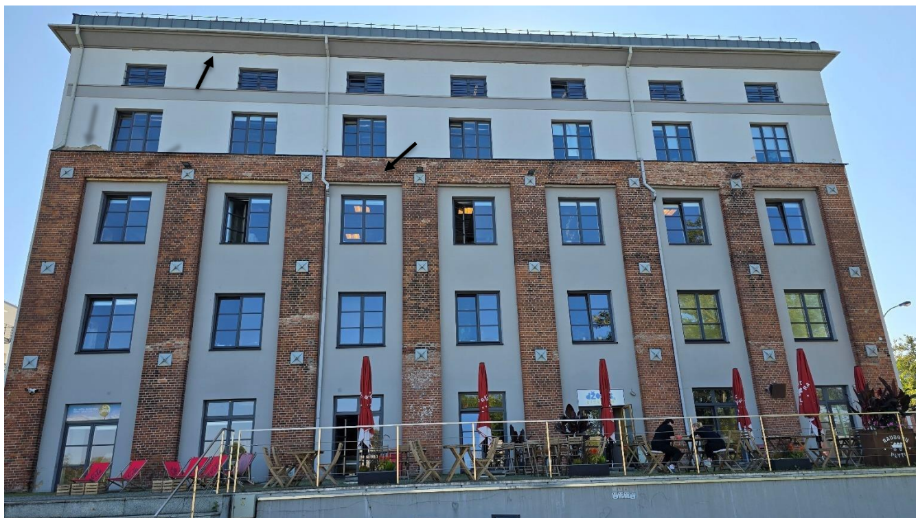
Nuotrauka Nr. 55 Fasade tarp ašių J-A/1 matomi nuo drėgmės ir šalčio poveikio atšokę dažai, keraminių molio plytų ir mūro siūlių pažaidos (žr. rodykles)
