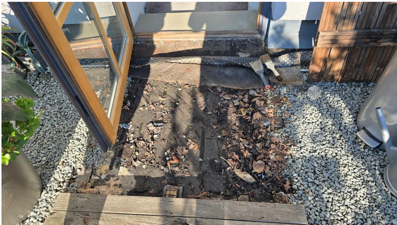
Nuotrauka Nr. 3 Esamos geotekstilės paviršius užterštas lapais, žemėmis, tinkamai nenufiltruoja kritulių vandens
