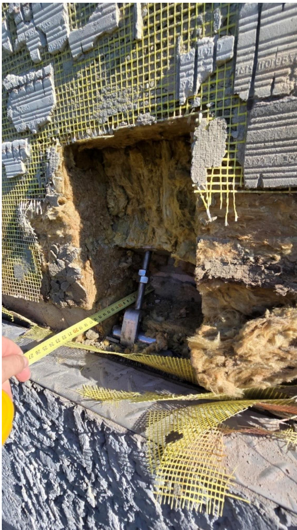
Nuotrauka Nr. 37 Nuo drėgmės poveikio šiltinamasis akmens vatos PAROC FAS 3 storis padidėjo nuo 160 mm iki 170-180 mm
