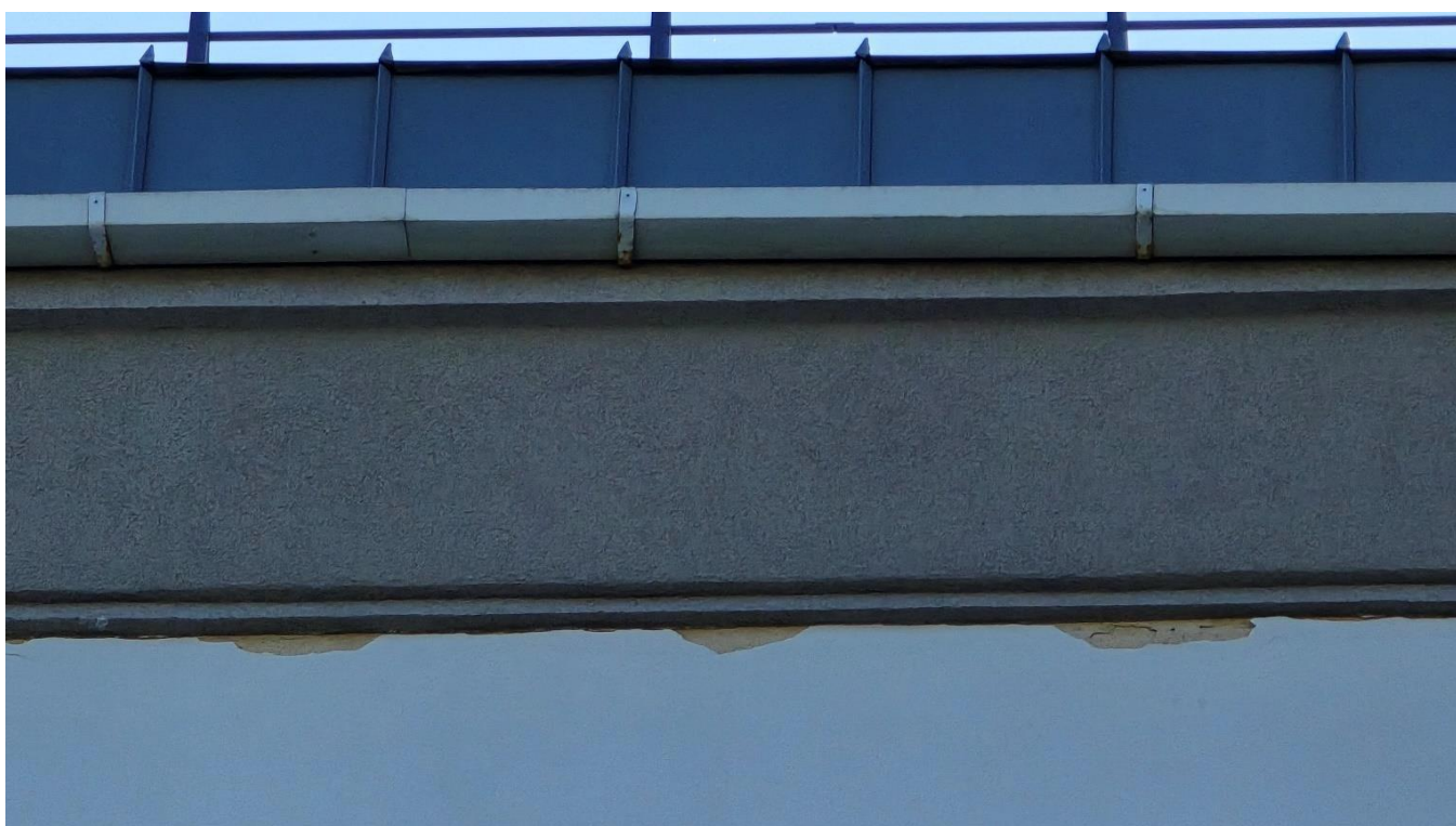
Nuotrauka Nr. 58 Fasade tarp ašių J-A/1 matomi nuo drėgmės ir šalčio poveikio atšokę dažai su tinku
