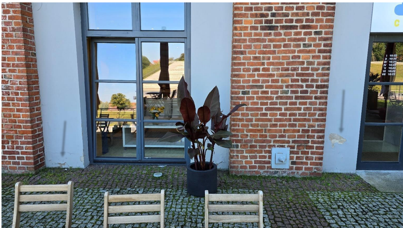
Nuotrauka Nr. 53 Fasade tarp ašių J-A/1 matomi nuo drėgmės ir šalčio poveikio atšokę dažai, keraminių molio plytų ir mūro siūlių pažaidos (žr. rodykles)
