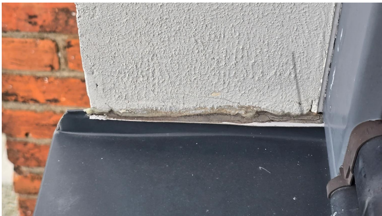
Nuotrauka Nr. 65 skardos palangių įrengimas nekokybiškas, užlenkimai ir sandūros neapsaugo nuo kritulių patekimo į sienų konstrukciją, neatitinka techninio projekto, konstrukcinės dalies Nr. 0308-TP-SK techninėse specifikacijose nurodytų reikalavimų palangių skardinimui, dėl drėgmės ir šalčio poveikio vietomis tinkas atšoko
