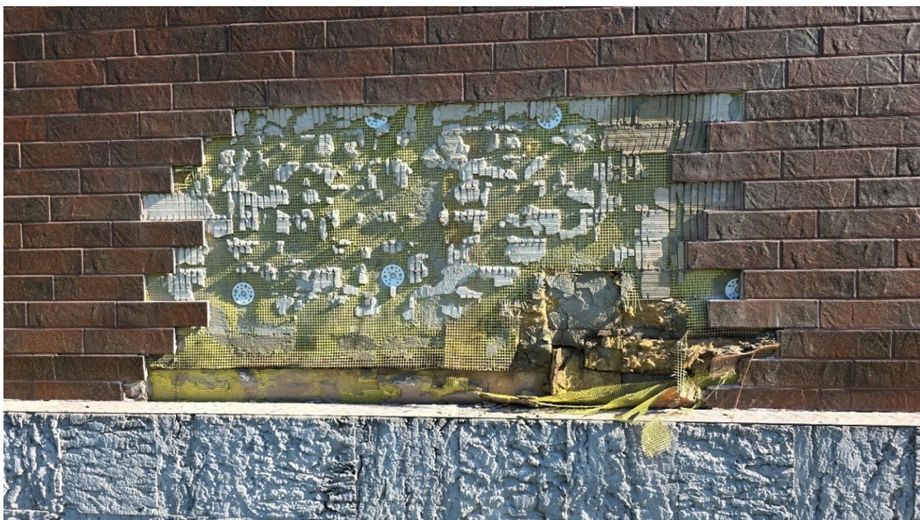
Nuotrauka Nr. 35 Armavimo tinklelis vietomis tarpusavyje neprakeistas, užleidžiant vieną tinklelį ant kito sandūroje ne mažiau kaip 100 mm, kaip nurodyta Statybos taisyklėse ST121895674.205.20.01:2012 Fasadų įrengimo darbai. Išorinių tinkuojamų sudėtinių termoizoliacinių sistemų įrengimas” (žr. žymėjimą rodykle).
