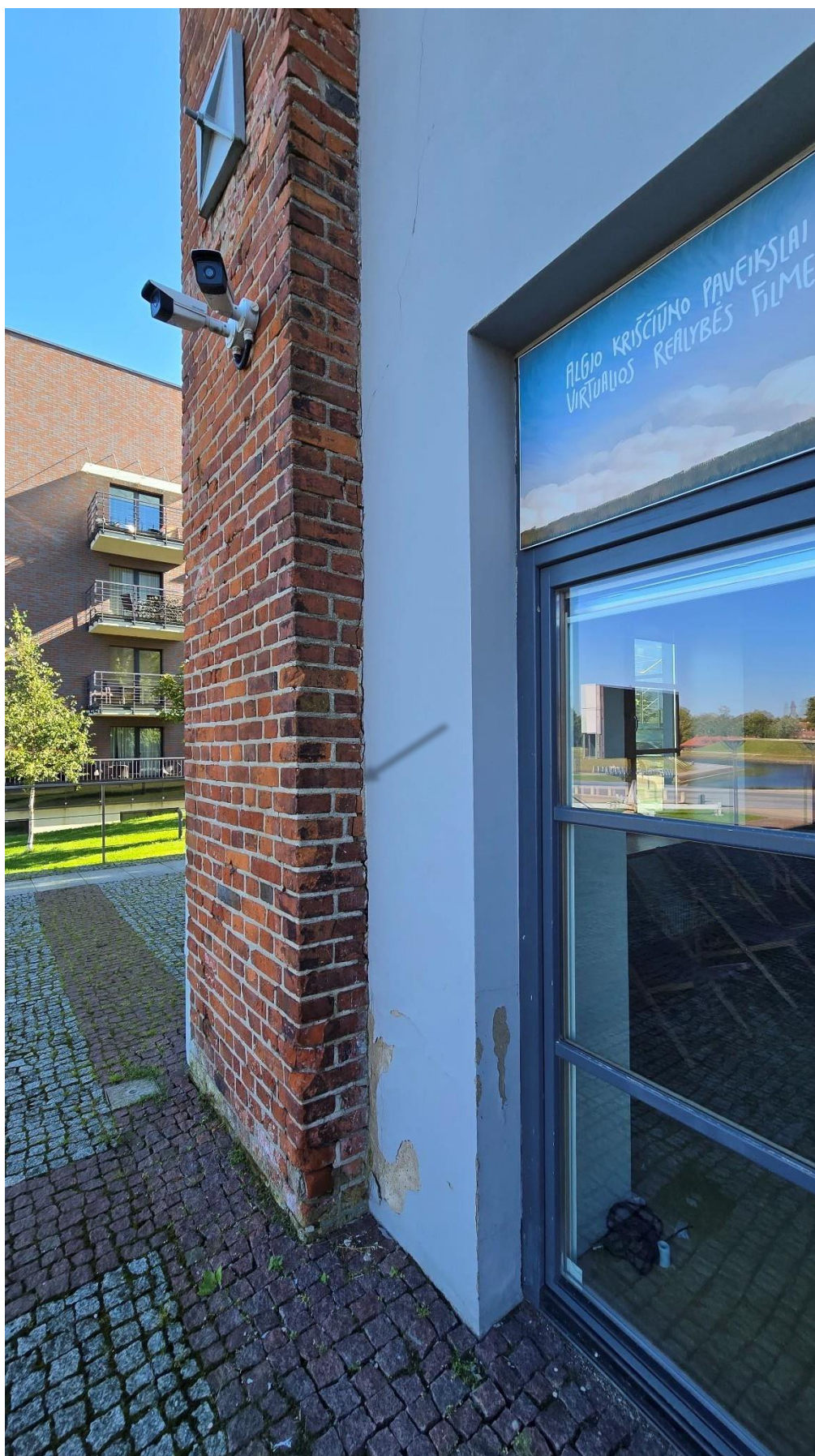
Nuotrauka Nr. 60 Vertikalus 4-5 mm pločio trūkis mūre ašyje J-I/1
