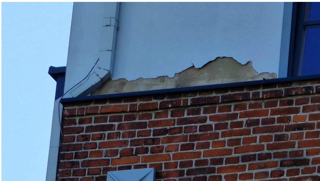
Nuotrauka Nr. 56 Fasade tarp ašių J-A/1 matomi nuo drėgmės ir šalčio poveikio atšokę dažai su tinku, keraminių molio plytų ir mūro siūlių pažaidos
