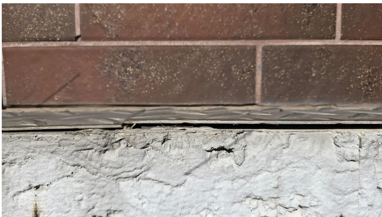
Nuotrauka Nr. 32 Apdailinė aliuminio juosta atšokusi nuo RECKLI plokščių paviršiaus visu ilgiu. Apdailinė aliuminio juosta privalėjo būti atbortuota, skardinės palangės tipo, sujungta su armavimo tinkleliu kad užtikrinti sandūros sandarumą (žr. žymėjimą rodyklėmis)
