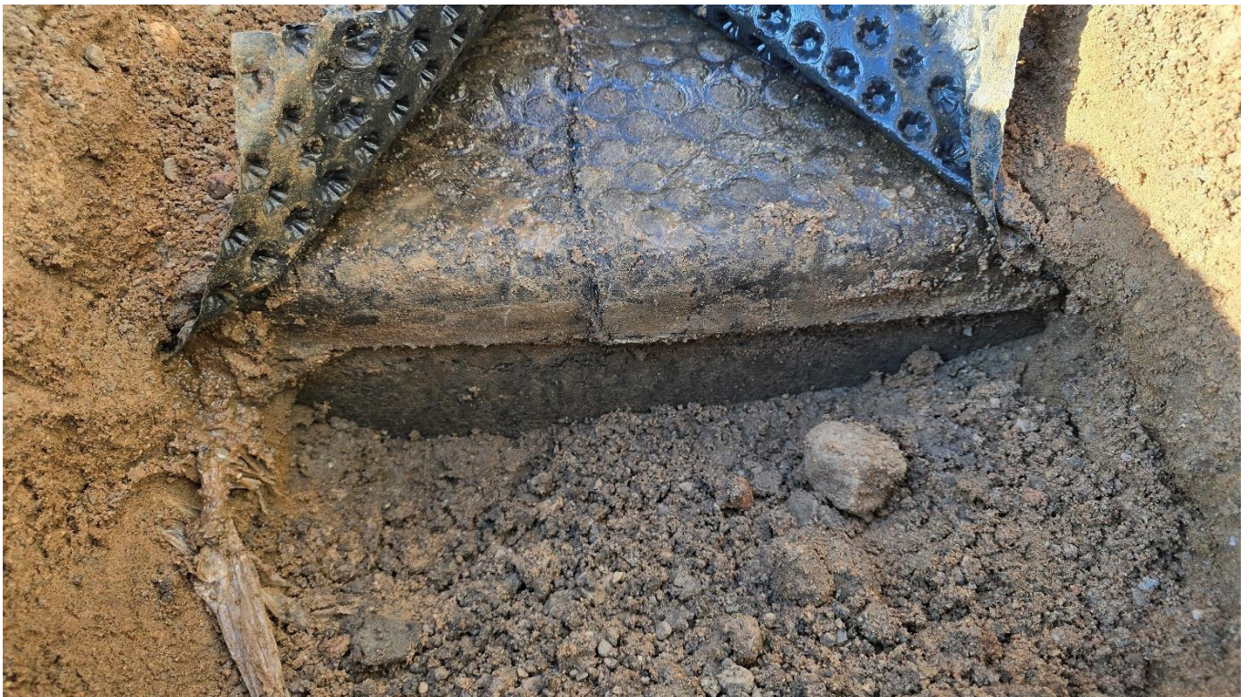
Nuotrauka Nr. 13 Siekiant nustatyti koku būdu krituliai patenka iš lauko į rūsio patalpų vidų, buvo atidengtos eksploatuojamo stogo grindinio konstrukcijos dalys iš išorės ties plieniniais atitvarų stulpeliais. Rangovas įrengė ne tokio tipo drenažinį lakštą (korį), įrengė drenažinį lakštą be geotekstilės sluoksnio. Matoma rūsio perdangos ir sienos pabaiga ašyje H/2-3
