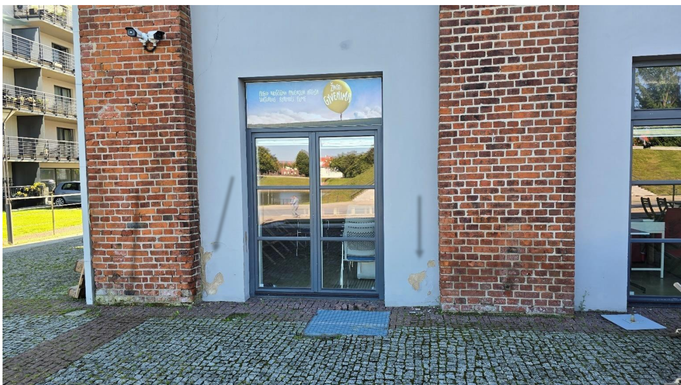
Nuotrauka Nr. 54 Fasade tarp ašių J-A/1 matomi nuo drėgmės ir šalčio poveikio atšokę dažai, keraminių molio plytų ir mūro siūlių pažaidos (žr. rodykles)
