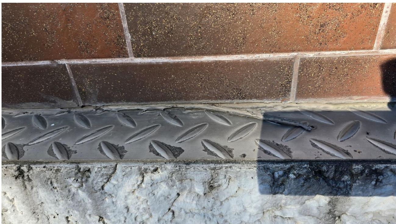
Nuotrauka Nr. 31 Sandūros tarp apdailinės aliuminio juostos ir klinkerio plytelių silikoninė siūlė atšokusi. Apdailinė aliuminio juosta privalėjo būti atbortuota, skardinės palangės tipo, sujungta su armavimo tinkleliu kad užtikrinti sandūros sandarumą
