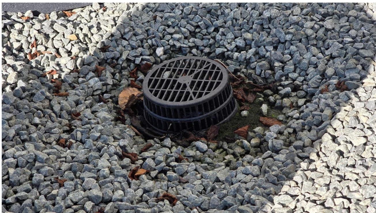
Nuotrauka Nr. 4 Esamos geotekstilės paviršius užterštas lapais, žemėmis, tinkamai nenufiltruoja kritulių vandens
