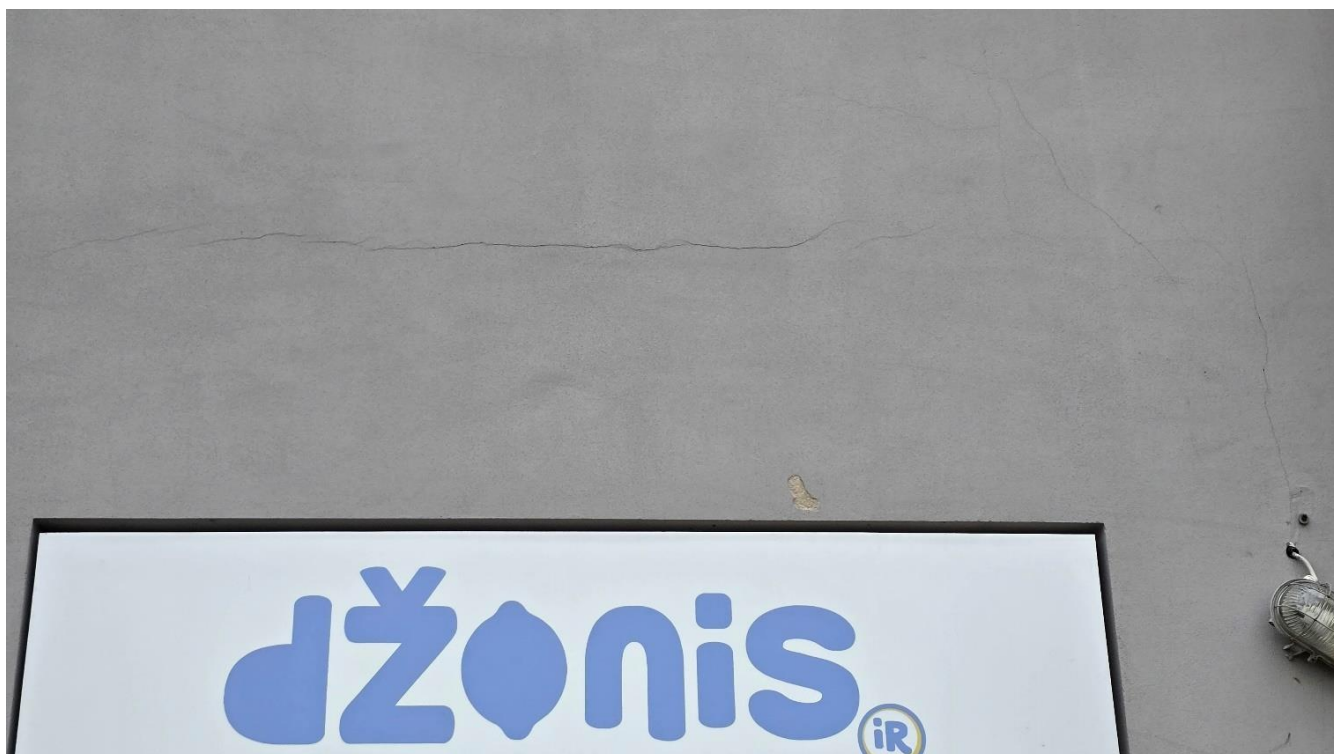
Nuotrauka Nr. 64 Trūkia tinko sluoksnyje, tinkas atšokęs, “barška” stuksenant
