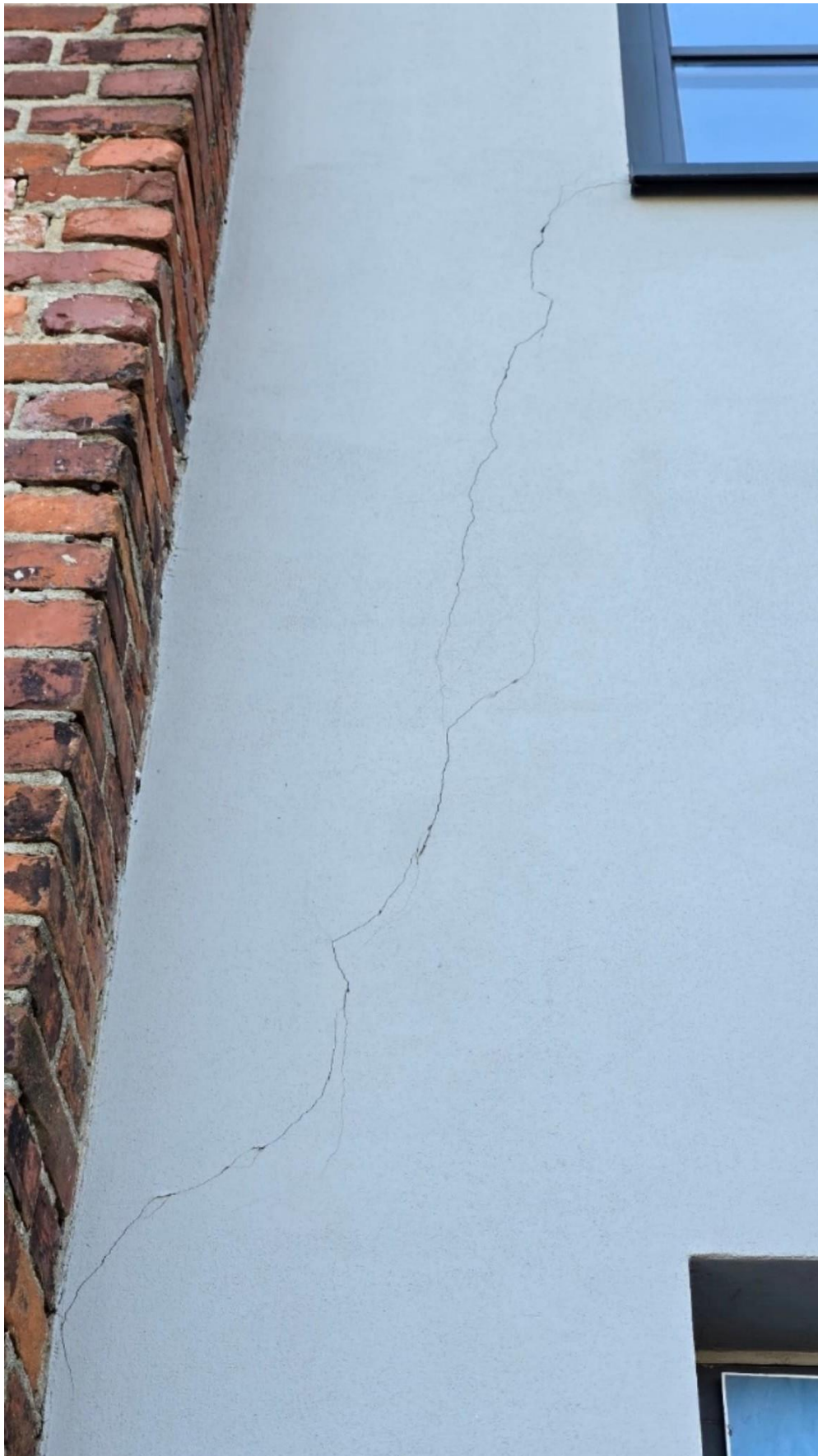
Nuotrauka Nr. 59 Vertikaliai įstrižas apie 1 mm pločio trūkis mūre ašyje J-I/1
