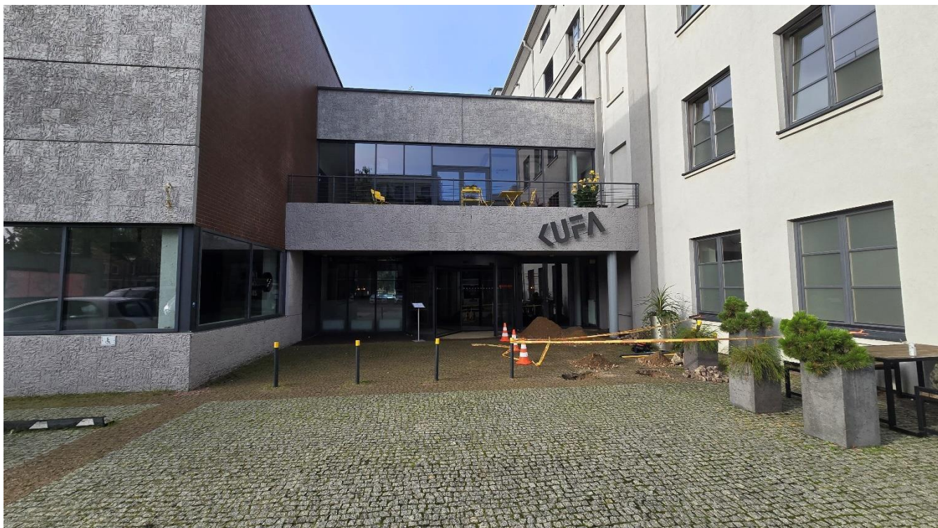
Nuotrauka Nr. 11 Siekiant nustatyti koku būdu krituliai patenka iš lauko į rūsio/pirmo aukšto patalpų vidų, buvo atidengtos eksploatuojamo stogo grindinio konstrukcijos dalys iš išorės ties įėjimo durimis/vitrinomis ir plieniniais atitvarų stulpeliais bei ties plienine kolona lauke
