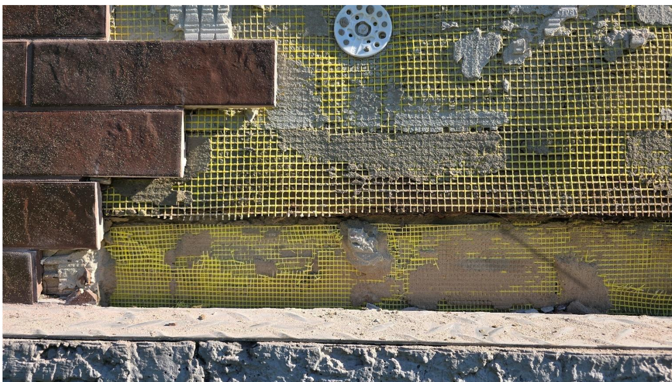
Nuotrauka Nr. 36 Armavimo tinklelis vietomis tarpusavyje neprakeistas, užleidžiant vieną tinklelį ant kito sandūroje ne mažiau kaip 100 mm (žr. žymėjimą rodykle).
