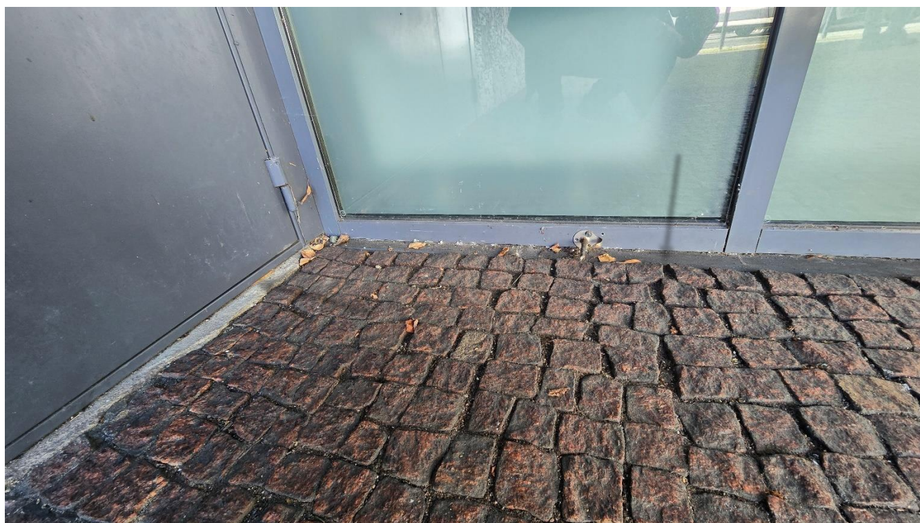
Nuotrauka Nr. 22 Išorinės durys iš lauko į pirmo aukšto patalpą Nr. 13 (laiptinę) sumontuotos virš pamato, neužsandarinant apatinės montavimo siūlės, matomos montažinės putos, krituliai per jas patenka į patalpų vidų. Pamatą ant kurio sumontuotos vitrinos/išorės durys įrengtas tame pačiame aukštyje kaip granito danga, granito dangai įrengti iki išorės durų/vitrinų neužtenka aukščio.
