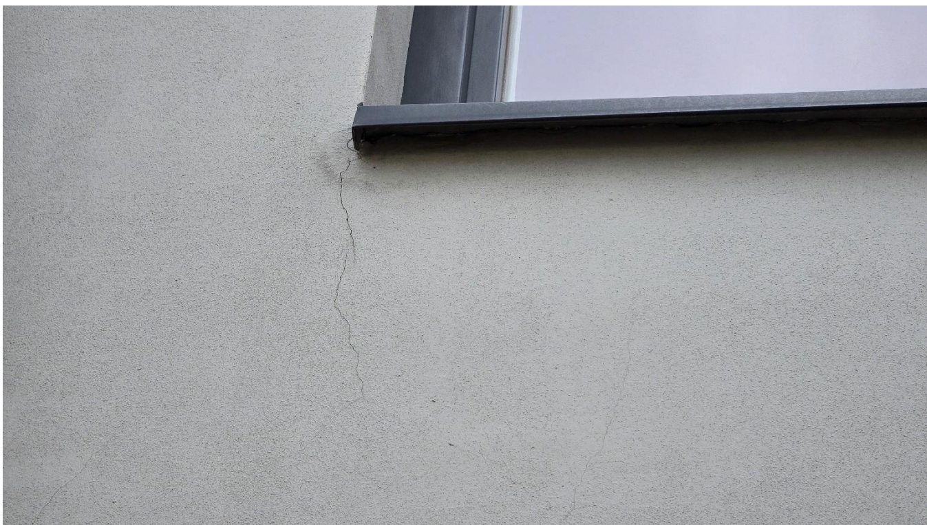
Nuotrauka Nr. 63 Trūkiai tinko sluoksnyje, tinkas atšokęs, “barška” stuksenant
