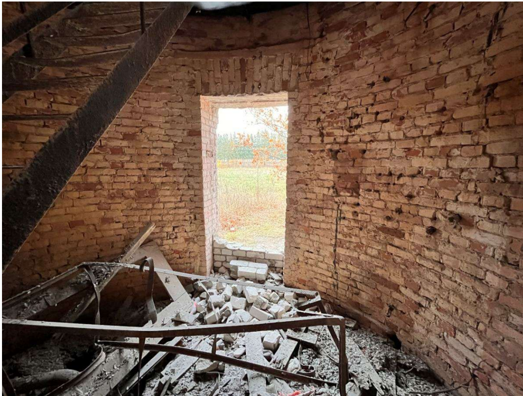
FF. 11 Vidinės pusės mūras. Mūrijimo kokybė labai skiriasi nuo išorinės pusės mūro kokybės: siūlės netvarkingos, panaudota apskaldytų plytų.
