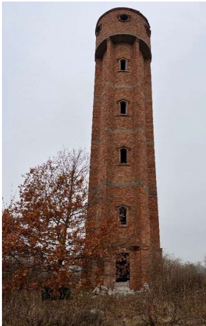
FF.1 Vaizdas iš rytinės pusės. Bokštas 6 tarpinių aukštų), viršutiniame tarpsnyje – vandens rezervuaro vieta.
