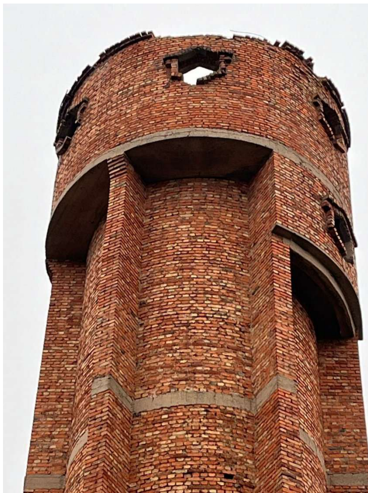
FF. 9 Šešiakampių langų angas juosia reljefiniai plytų mūro apvadai bei sandrikai. Kontraforsų viršuje – reljefiniai plytų mūro praplatinimai.
