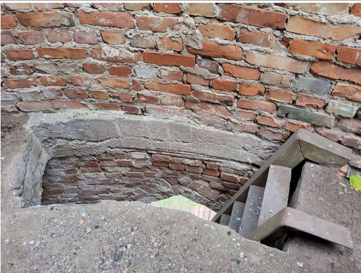
FF. 21 Anga patekimui į viršutiniame tarpsnyje esančią vandens rezervuaro patalpą. Angos ilgis 153 cm, plotis 48-55 cm.
