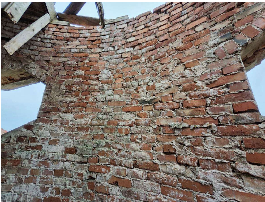
FF. 27 Viršutinės bokšto dalies vidinės pusės mūro plytos tokios pačios kaip ir apatinėje dalyje, naudotos ir apskaldytos ar pusplytės. Įmūryta ir šiek tiek aukštesnių plytų (25,5-26,0x7-7,5-8 cm). Dalis šių plytų su žmonių pirštų įspaudais.
