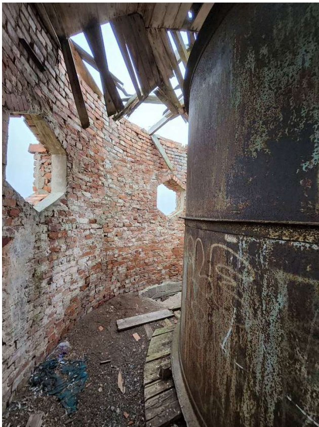
FF. 22 Vandens rezervuaro patalpa apskritimo plano su 6 šešiakampėmis langų angomis. Langai neišlikę, tik išlikę kai kurių langų mediniai rėmai.
