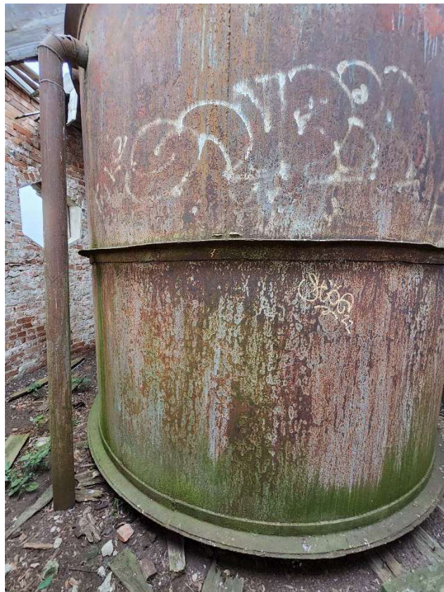
FF. 23 Rezevuaro skersmuo – 3,1 m, aukštis – 2,83 m sujungtas iš dviejų cilindrinų talpų. Vandens vamzdžiai metaliniai, apie 110 mm skersmens.
