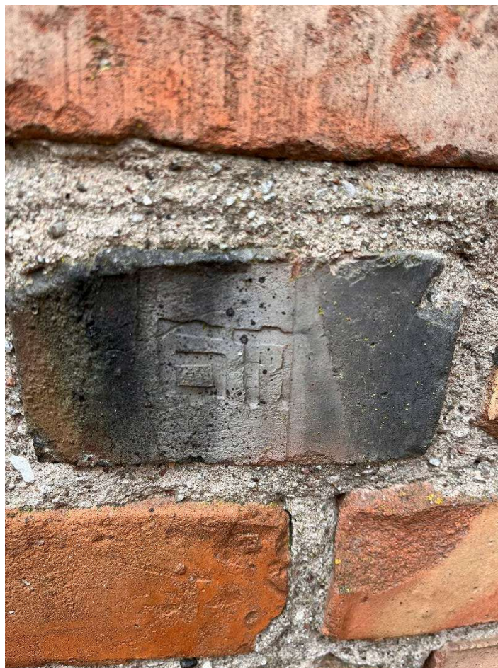
FF. 6 Kai kurios plytos perdegtos. Ant pateiktos perdegtos plytos galinės sienelės įspaudai Б П.
