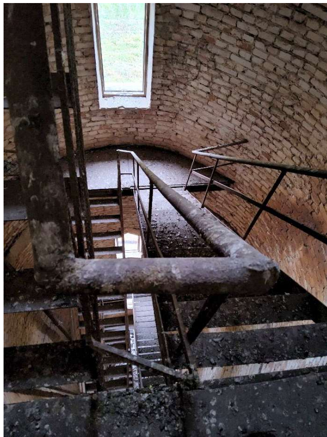
FF. 14 Metalo konstrukcijos laiptinė.
