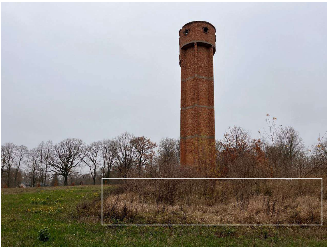
FF. 31 Vaizdas iš P pusės. Baltai pažymėta galimai buvusios požeminės patalpos/patalpų vieta apžėlusi krūmynais. Natūroje matomos atsivėrusios ertmės, išvesti vamzdžiai.
