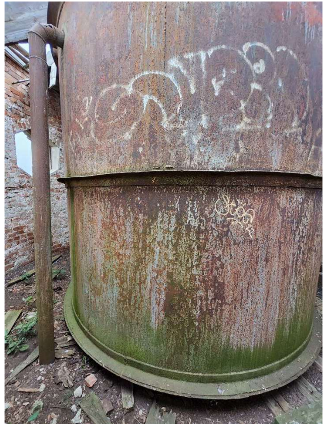
FF. 23 Rezevuaro skersmuo – 3,1 m, aukštis – 2,83 m sujungtas iš dviejų cilindrinų talpų. Vandens vamzdžiai metaliniai, apie 110 mm skersmens.
