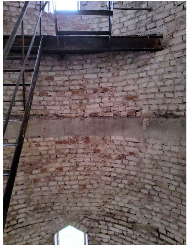
FF. 17 Bokšto mūras stiprintas betoniniais armuotais žiedais tarp antro ir trečio, trečio ir ketvirto, ketvirto ir penkto tarpinių.
