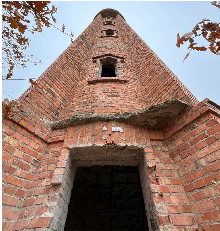
FF. 8 Įėjimo durų anga su reljefiniais plytų mūro apvadais ir sąrama. Virš durų buvęs stogelis neišlikęs. Antrame-ketvirtame tarpsniuose – siauro stačiakampio plano langai su trikampio plano sąramomis bei trikampio plano reljefiniais plytų mūro sandrikais.
