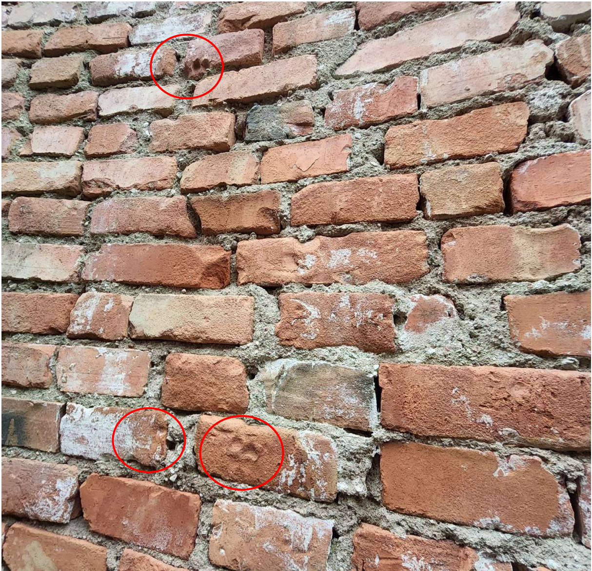
FF. 28 Dalis aukštesniųjų plytų (25,5-26,0x7-7,5-8 cm formato) su žmonių pirštų įspaudais. Šis bruožas gali reikšti, kad plytos gamintos paskubomis pritrūkus būtent bokštui pabaigti, arba tai – antrinio naudojimo plytos.
