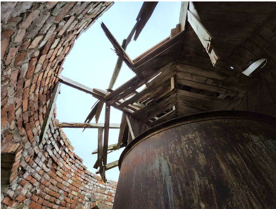
FF. 24 Stogas gegninės konstrukcijos, kūgio formos. Šiuo metu įlūžęs, labai blogos būklės.
