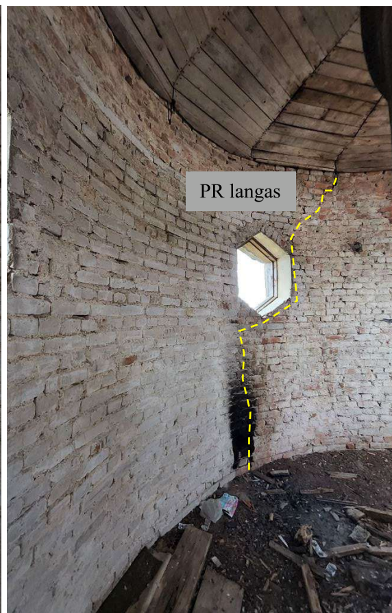
FF. 29 Plytų mūras skiriasi nuo R lango iki PR lango angos. Mūryta plonomis ankstyvojo pokario silikatinėmis plytomis (25x12x6,5 cm). Virš langų angų – tokios pačios molio plytos kaip ir kitur. Išlikę šių langų staktos.
