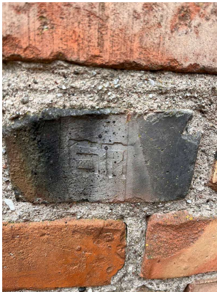
FF. 6 Kai kurios plytos perdegtos. Ant pateiktos perdegtos plytos galinės sienelės įspaudai Б П.
