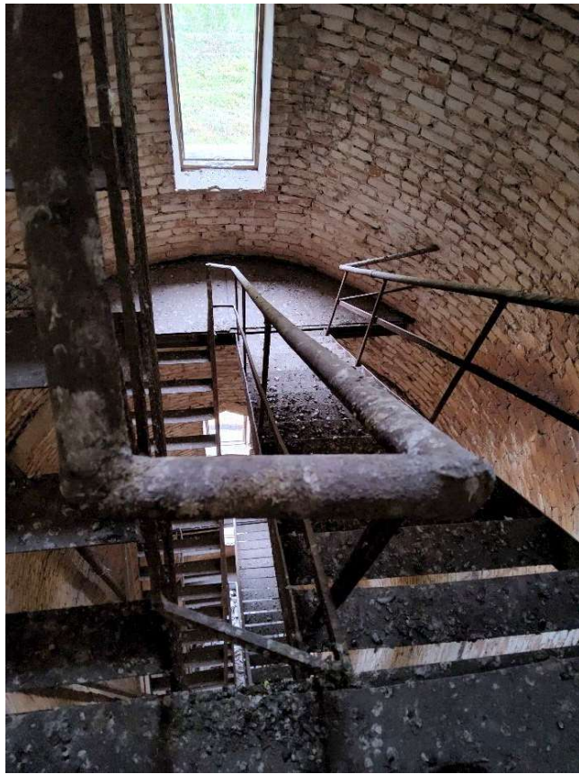
FF. 14 Metalo konstrukcijos laiptinė.
