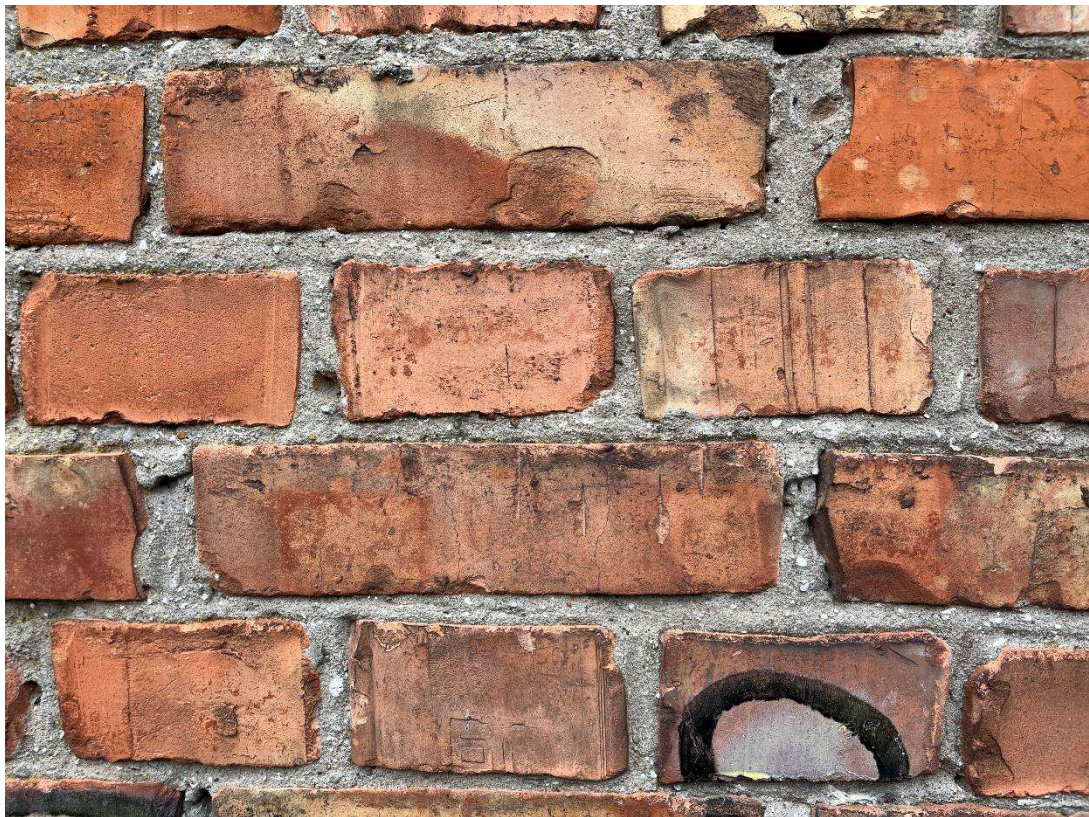
FF. 5 Išorinės pusės mūras. Plytų matmenys: 25-25,2x12x6,3-6,5 cm. Rišta cementiniu skiediniu su rūpau smėlio užpildu. Siūlės rievėtos, rievėtumas dalinai sunykęs. Plytų rišimo būdas – eilė trumpainių, eilė ilgainių. Plytų šoninėse ir galinėse plokštumose matomi įspaudai, parašyti kirilica: Б П arba П Б.
