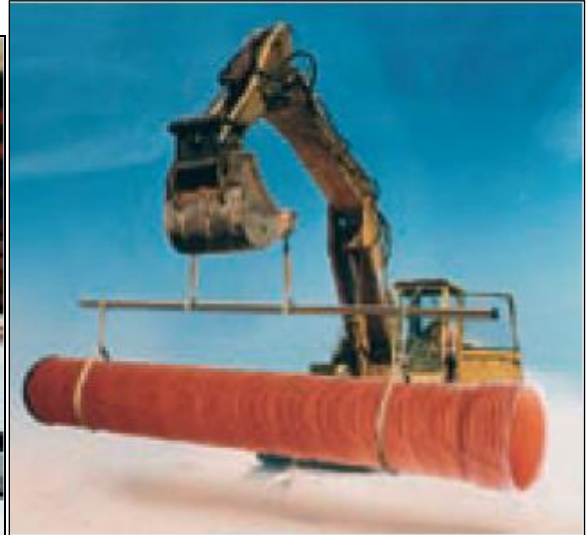
2 pav. Mechanizuotas vamzdžių krovimas
