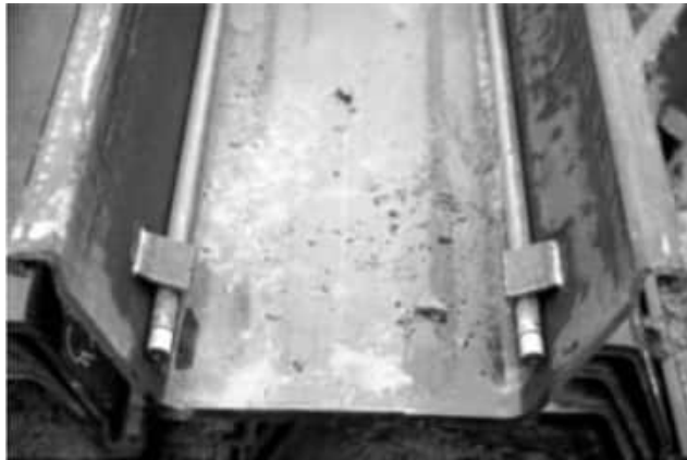
Pav. 3 Vamzdelių tvirtinimas prie įlaido
