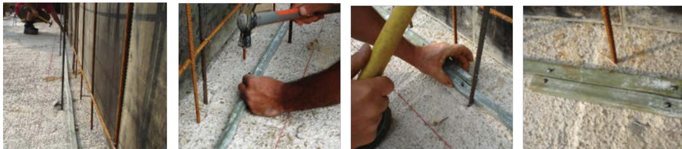
5.1 Paveikslas. Principinė siūlių sandarinimo įrengimo schema
