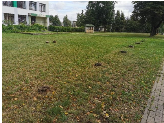
7 pav. Vejoje kyšantys šiluminių kamerų vamzdžiai ir likę neišrauti nukirstų medžių kelmai
