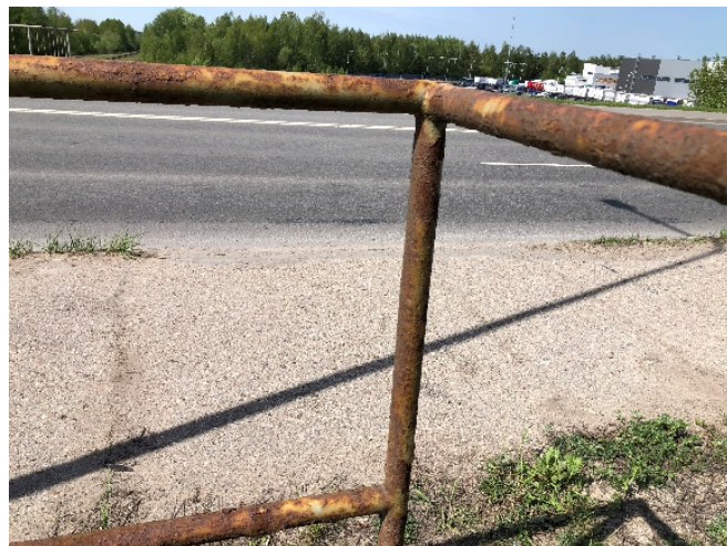
4 pav. Korozijos pažeisti viaduko turėklai
