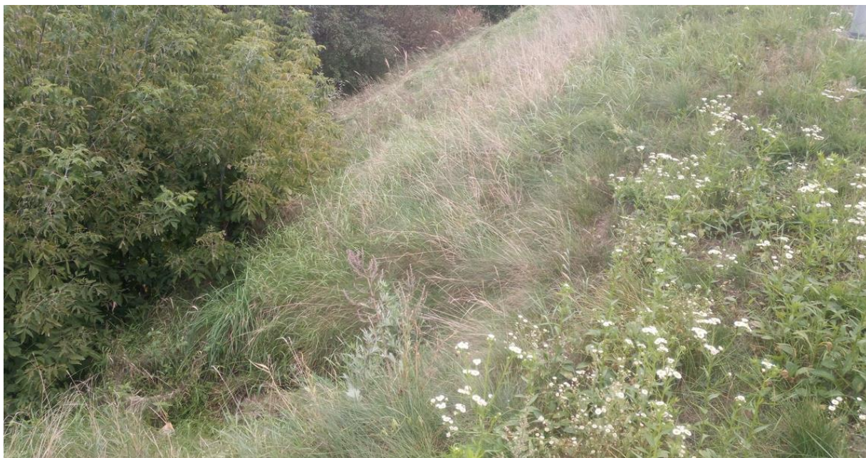
5 pav. Sankasos paviršiuje besiformuojanti lietaus išgrauža
