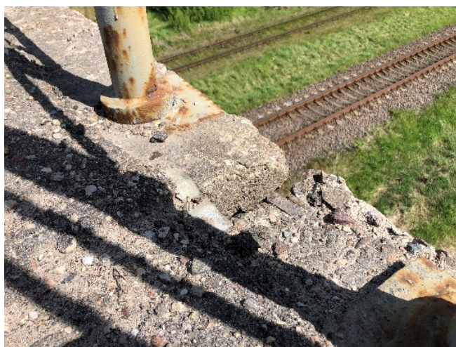
5 pav. Neįrengti deformaciniai pjūviai
