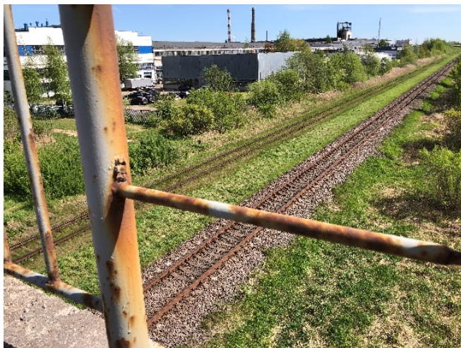
4 pav. Korozijos pažeisti viaduko turėklai
