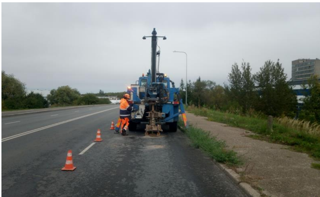
1 pav. Lauko darbai ties Gr.SZ-1 gręžimo įrenginiu KB20 sraigtniu (šnekiniu) gręžimo būdu d = 148 mm
