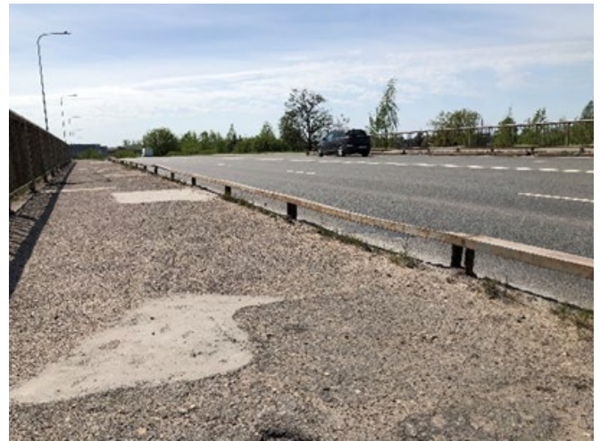
3 pav. Korozijos pažeisti viaduko atitvarai
