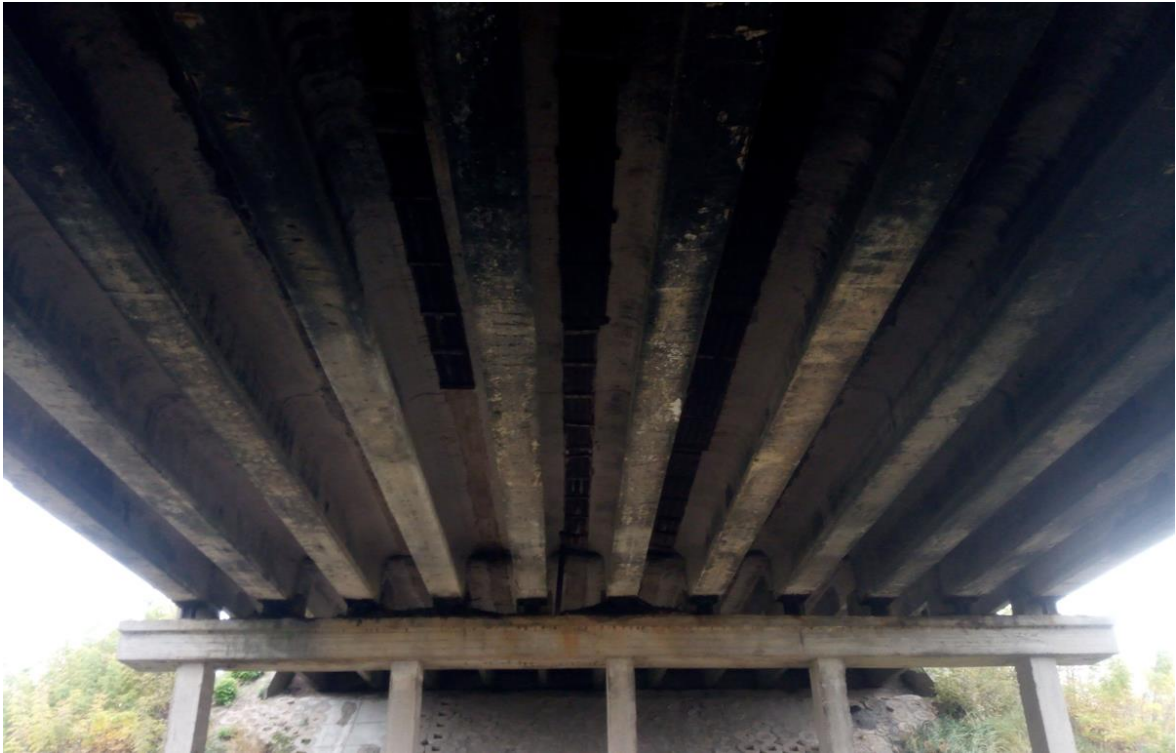
8 pav. Matomos atsidengusios vidinės viaduko sijos konstrukcijų dalys
