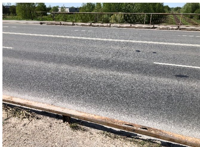
5 pav. Neįrengti deformaciniai pjūviai
