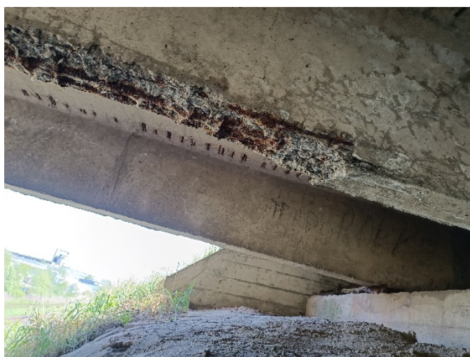
7 pav. Ištrupėjusęs apsauginis sijų betono sluoksnis, atsivėrusi armatūra
