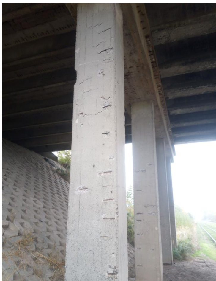
6 pav. Pažeistos viaduko kolonos ir jas laikantis rostverkas
