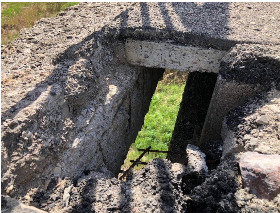
6 pav. Pažeisti, ištrupėję viaduko šaltilčiai
