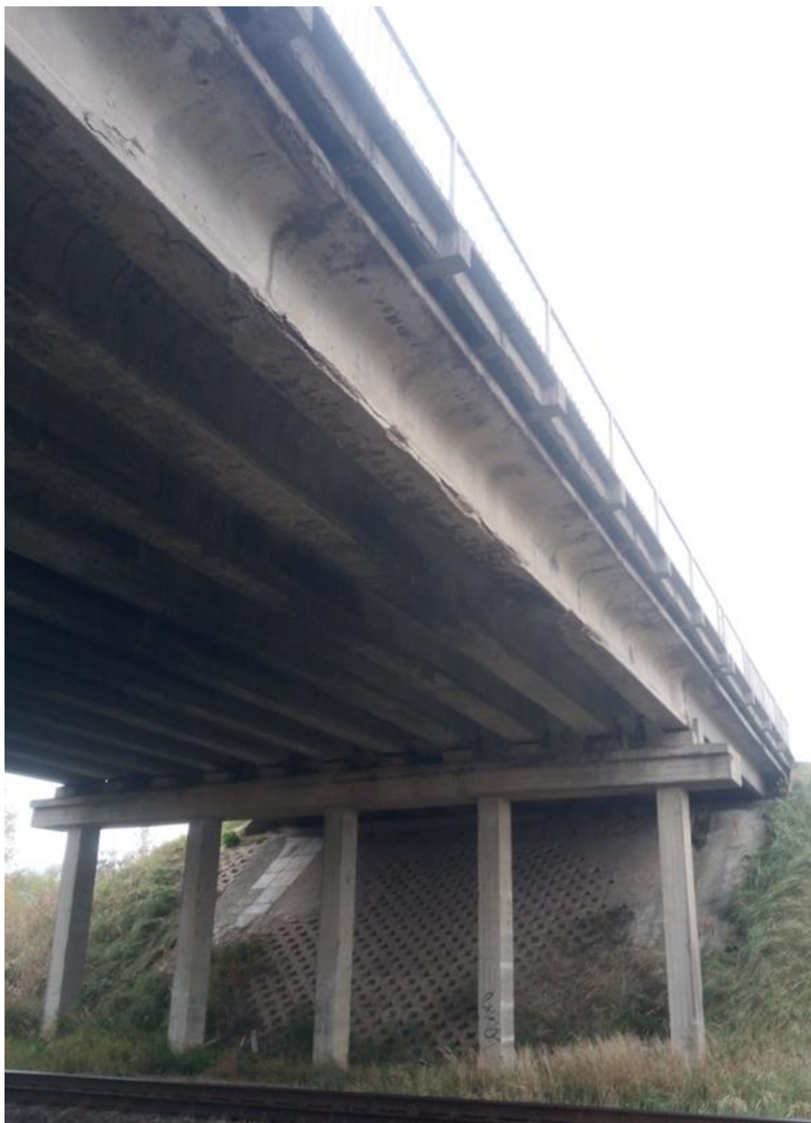
7 pav. Pažeista viaduko sija
