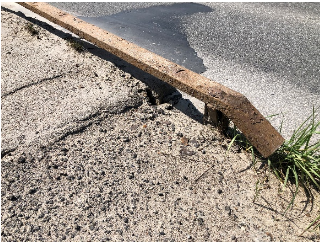
3 pav. Korozijos pažeisti viaduko atitvarai
