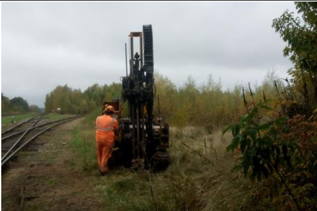
2 pav. Lauko darbai ties Gr.SZ-3 gręžimo įrenginiu GM100 vibraciniu-kalamuoju gręžimo būdu d = 50 \text{ mm}
