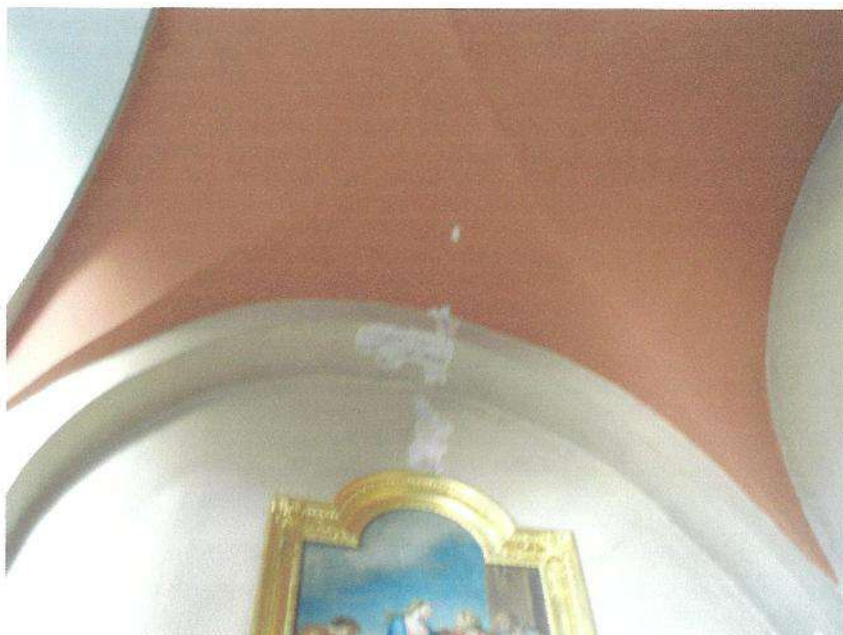
F31. Bobinčiaus šiaurinėj arkinėj sienoje atidengta XIX a. freskos technika atlikta tapybinė kompozicija. Matomi zondažai sienoje z.91,92 ir z.93 skliaute
