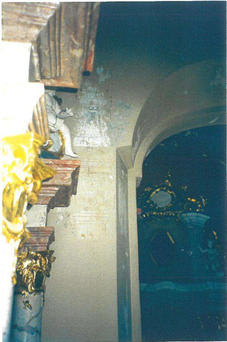
F23. Dešinosios navos koplyčios įėjimo arkos angokraščio atodanga z.58 . Matomi XIX a. ir Baroko laikotarpio (švelniai rausvas) tapybinio dekoro fragmentai.
