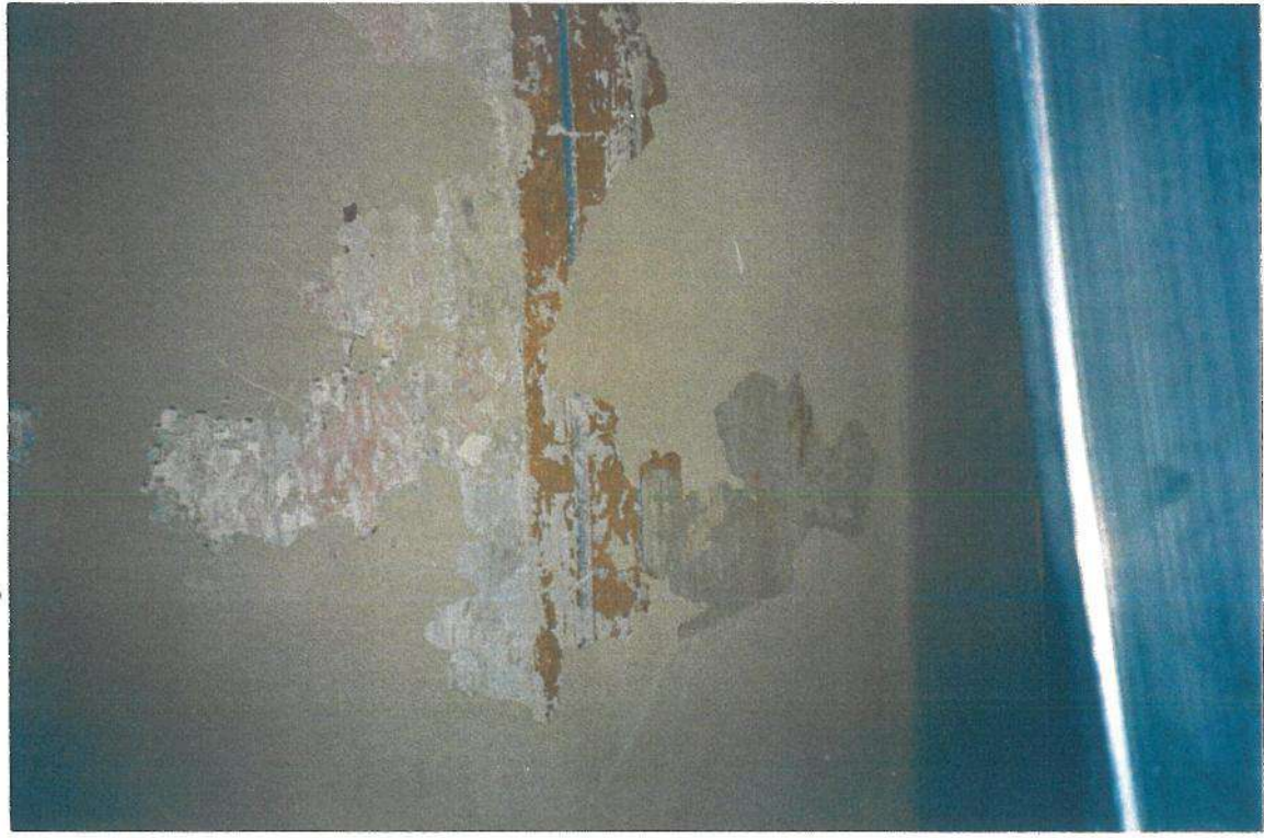
F23. Dešinosios navos koplyčios įėjimo arkos angokraščio atodanga z.58 . Matomi XIX a. ir Baroko laikotarpio (švelniai rausvas) tapybinio dekoro fragmentai.
